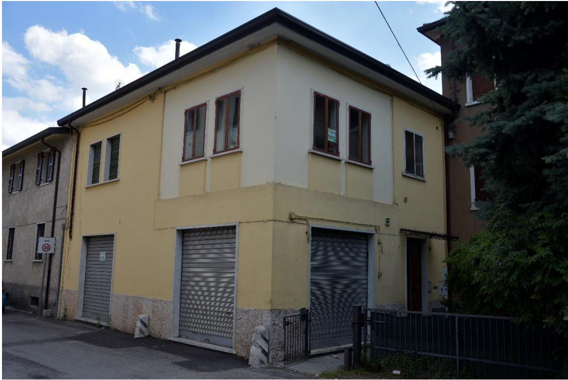
Fabbricato ubicato in via Brennero a Sant'Ambrogio di Valpolicella
