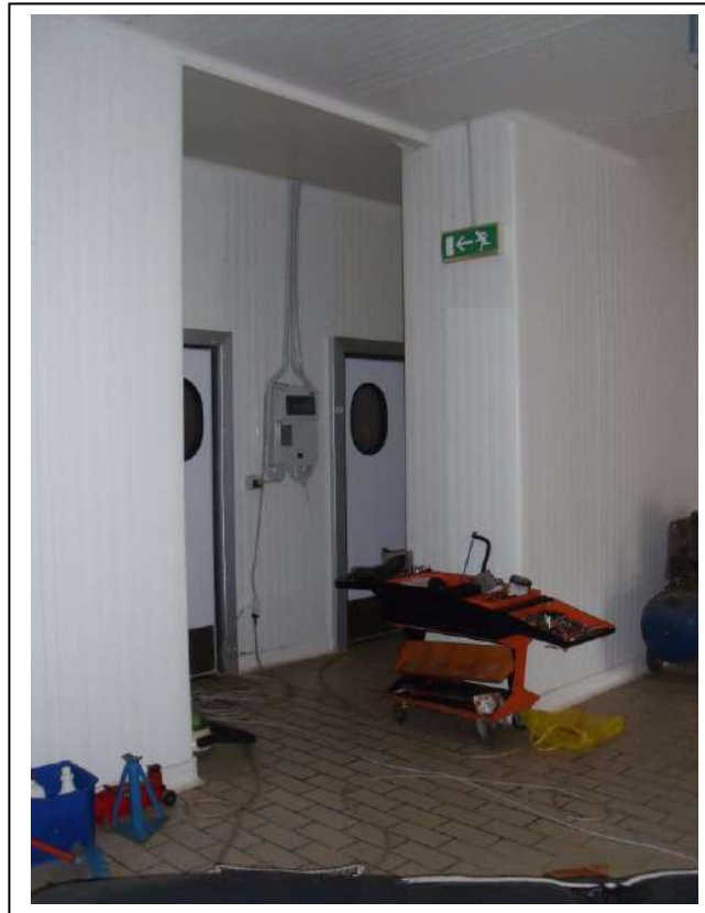
38. Interno “zona scarico merci” dell’unità immobiliare al piano terra, con vista lato nord, in foto sufficiente stato di manutenzione.
