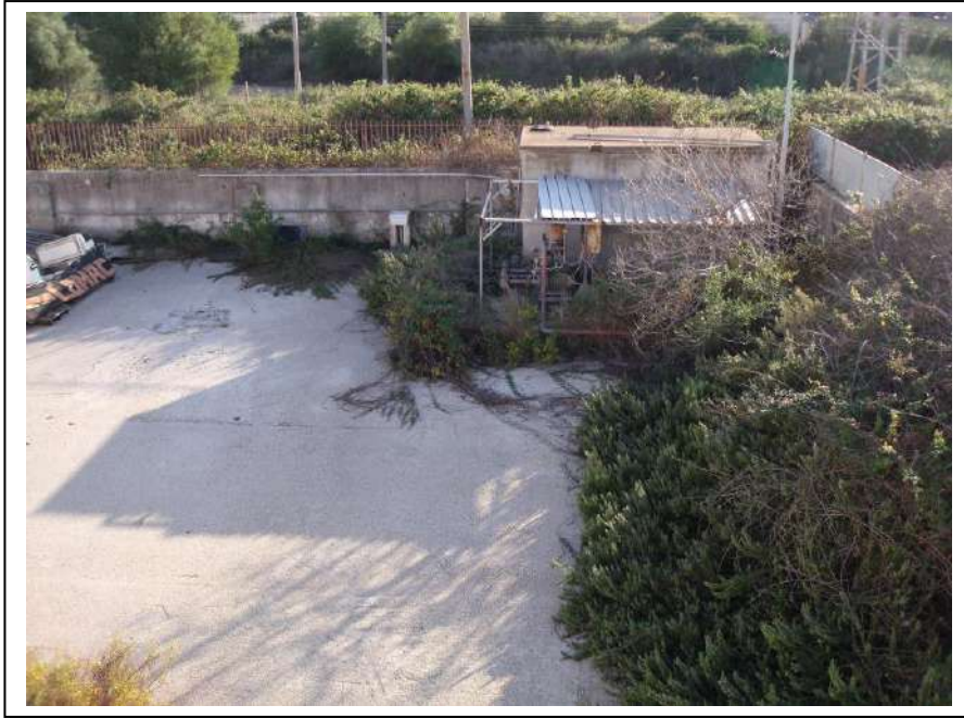
91. Esterno “terrazza praticabile” dell’unità immobiliare al piano primo, con vista lato sud-ovest, verso area di pertinenza retrostante al fabbricato.
