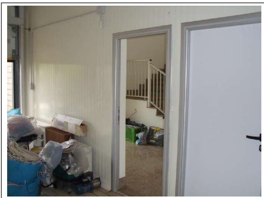
13. Interno “ingresso merci” dell’unità immobiliare al piano terra con vista lato sud, in foto sufficiente stato di manutenzione. Presenza di oggetti di varia natura.
