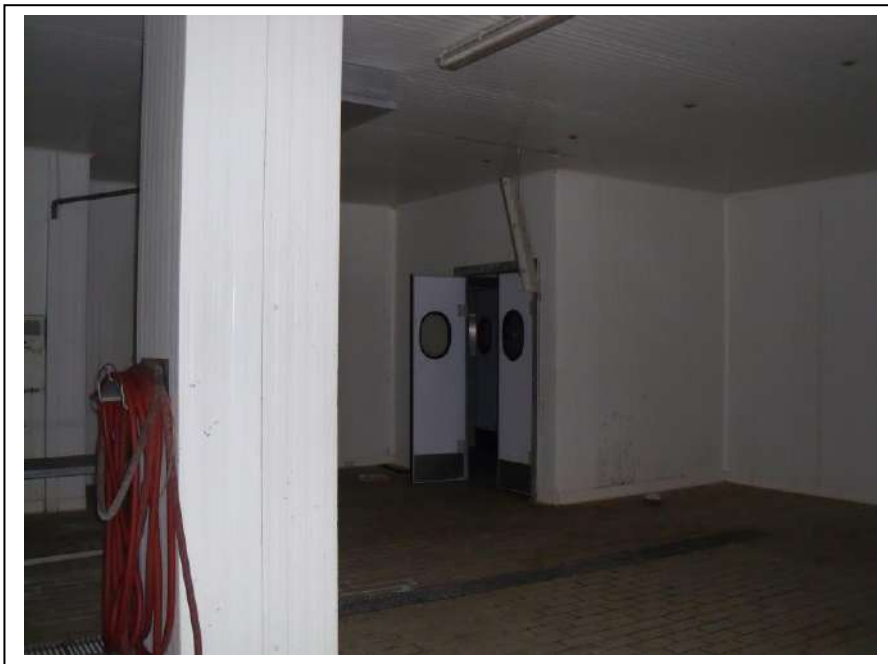
18. Interno vano “laboratorio sezionamento busti” dell’unità immobiliare al piano terra, con vista lato est, in foto discreto stato di manutenzione.
