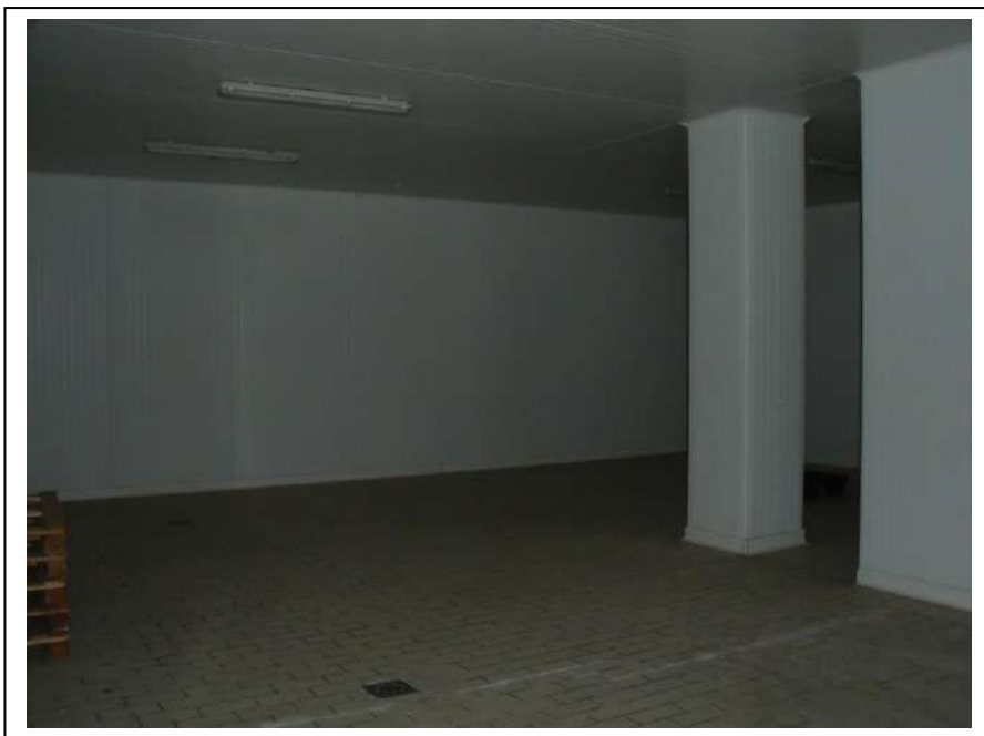
35. Interno “cella frigorifera” dell’unità immobiliare al piano terra, con vista lato est, in foto sufficiente stato di manutenzione.
