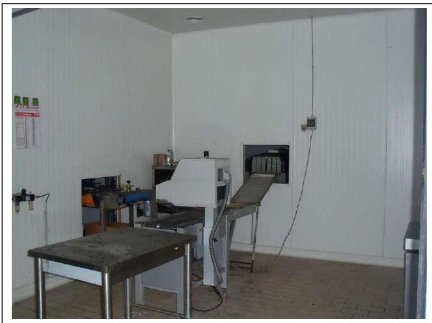
19. Interno “sala imballaggio” dell’unità immobiliare al piano terra, con vista lato ovest, in foto sufficiente stato di manutenzione.
