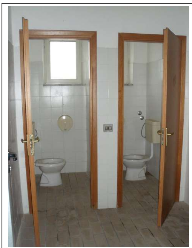
31. Interno servizi igienici dell’unità immobiliare al piano terra, con vista lato sud-ovest, in foto sufficiente stato di manutenzione.
