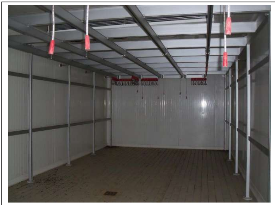
14. Interno “cella preconfezionati” dell’unità immobiliare al piano terra con vista lato ovest, in foto sufficiente stato di manutenzione.
