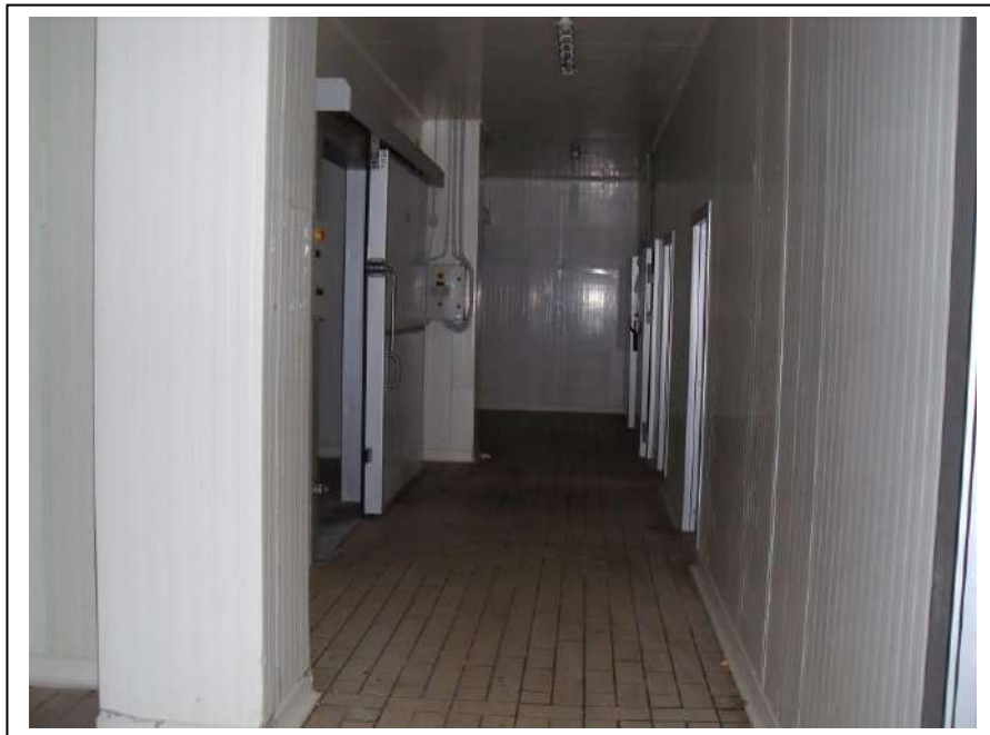
27. Interno “anti-cella” dell’unità immobiliare al piano terra, con vista lato sud-est, in foto sufficiente stato di manutenzione.
