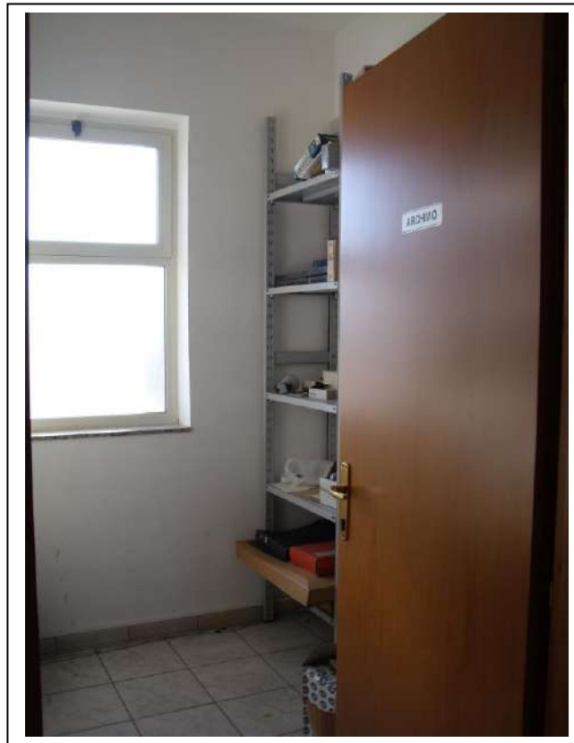
56. Interno "archivio" dell'unità immobiliare al piano primo, con vista lato nord, in foto sufficiente stato di manutenzione.
