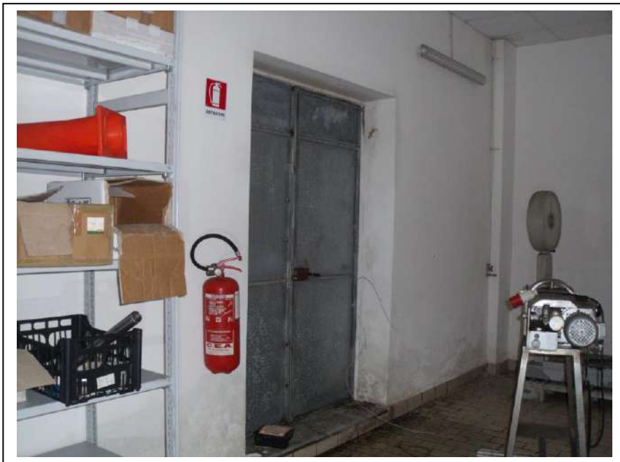
20. Interno “deposito cartoni” dell’unità immobiliare al piano terra, con vista lato nord, in foto cattivo stato di manutenzione.
