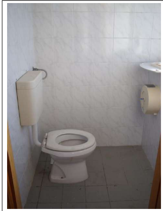
49. Interno “servizio igienico spogliatoio donne” dell’unità immobiliare al piano primo, con vista lato sud-ovest, in foto sufficiente stato di manutenzione.
