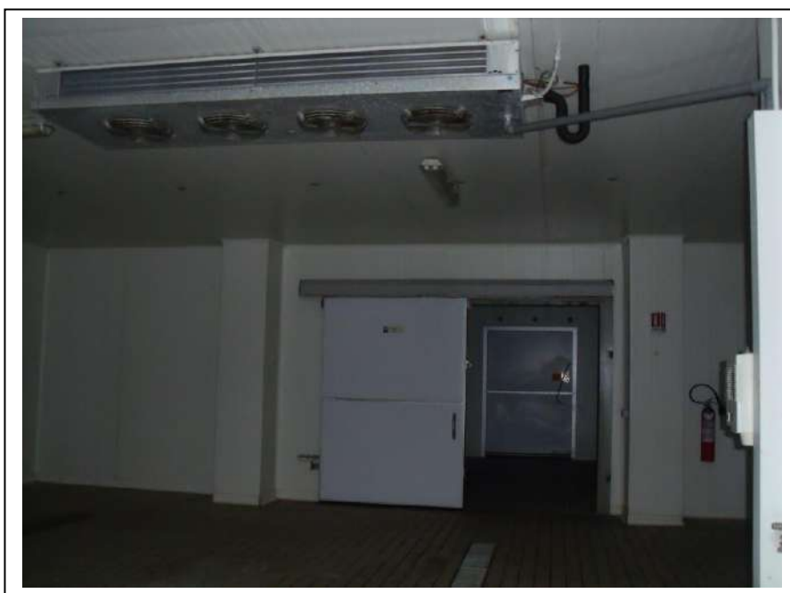
17. Interno vano “laboratorio sezionamento busti” dell’unità immobiliare al piano terra, con vista lato sud-est, in foto discreto stato di manutenzione.
