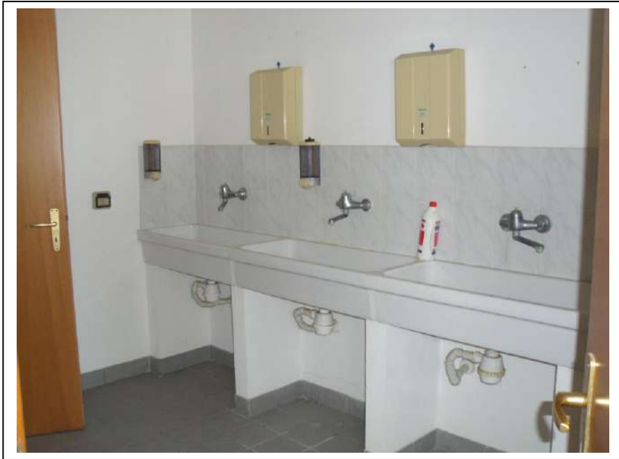
51. Interno “antibagno spogliatoio uomini” dell’unità immobiliare al piano primo, con vista lato sud, in foto buono stato di manutenzione.
