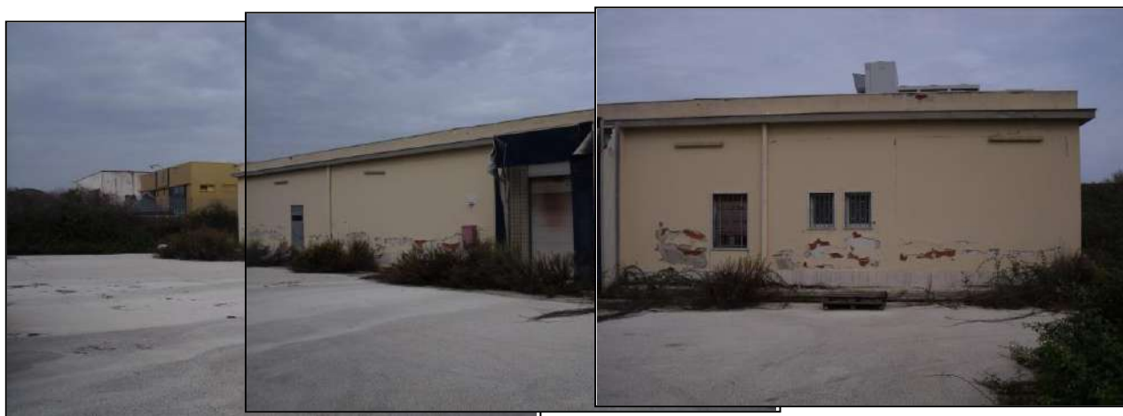
07-08-09. Prospetto retrostante con esposizione a sud-ovest su area di pertinenza asfaltata, presenza di vegetazione spontanea in prossimità del fabbricato, lungo il marciapiede circostante.
