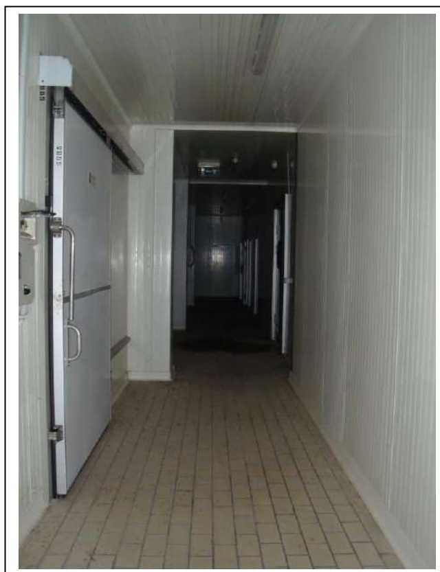
25. Interno “anti-cella” dell’unità immobiliare al piano terra, con vista lato sud-est, in foto sufficiente stato di manutenzione.
