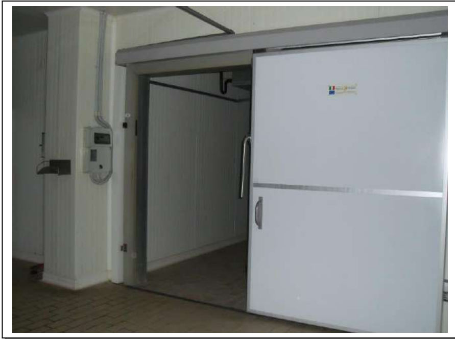
33. Interno “anti-cella” dell’unità immobiliare al piano terra, con vista lato nord, in foto sufficiente stato di manutenzione.
