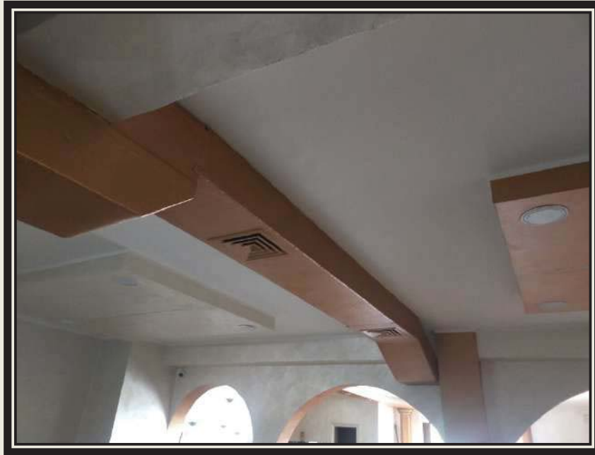
FOTO N° 14 – LOCALE COMMERCIALE - FOGLIO 5 - PARTICELLA 623 - SUB 1 - PIANO TERRA
