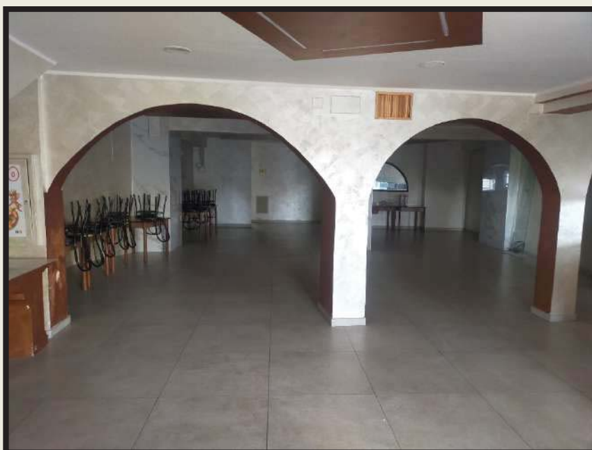
FOTO N° 11 – LOCALE COMMERCIALE - FOGLIO 5 - PARTICELLA 623 - SUB 1 - PIANO TERRA
