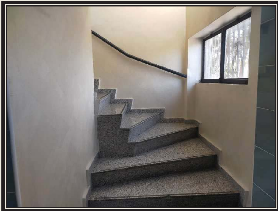
FOTO N° 16 – LOCALE COMMERCIALE – SCALA DI COLLEGAMENTO CON I BAGNI SITUATI AL PRIMO SOTTOSTRADA A SERVIZIO DEL LOCALE
