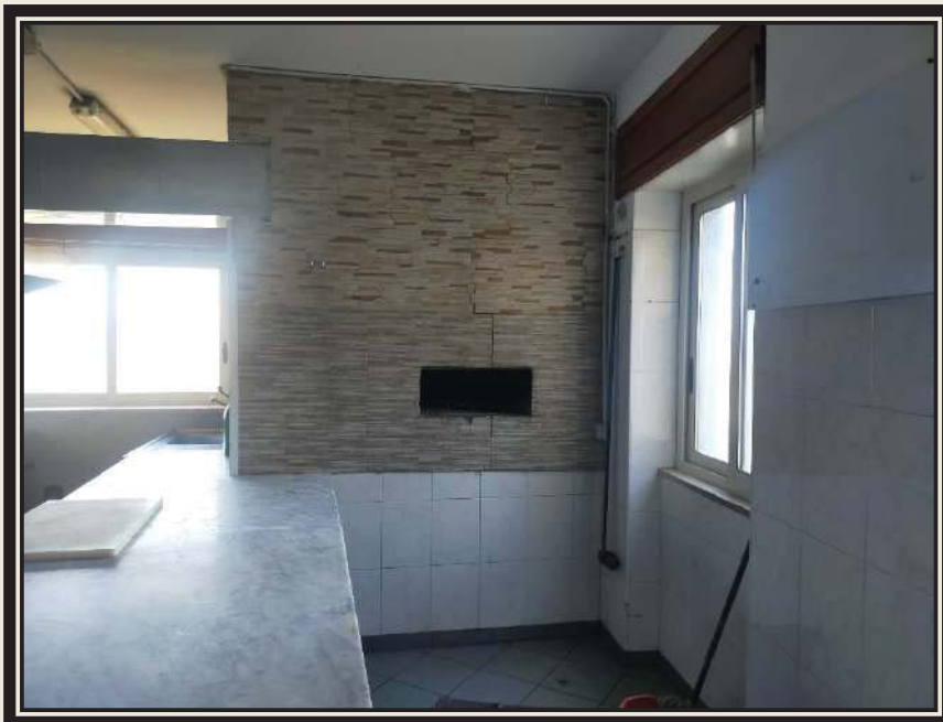
FOTO N° 15 – LOCALE COMMERCIALE – ZONA CUCINA - FOGLIO 5 - PARTICELLA 623 - SUB 1 - PIANO TERRA
