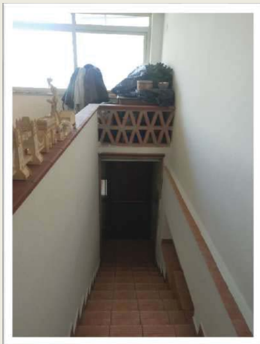
FOTO N° 10 – SCALA INTERNA DI COLLEGAMENTO : APPARTAMENTO – LOCALE COMMERCIALE
