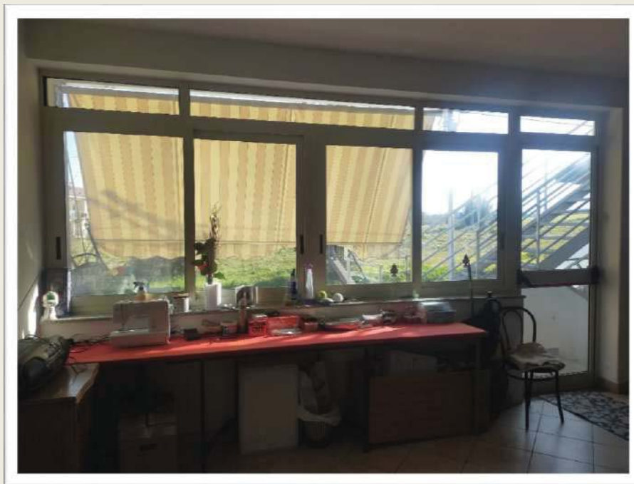
FOTO N° 5 – APPARTAMENTO - FOGLIO 5 - PARTICELLA 623 - SUB 2 - PIANO PRIMO
