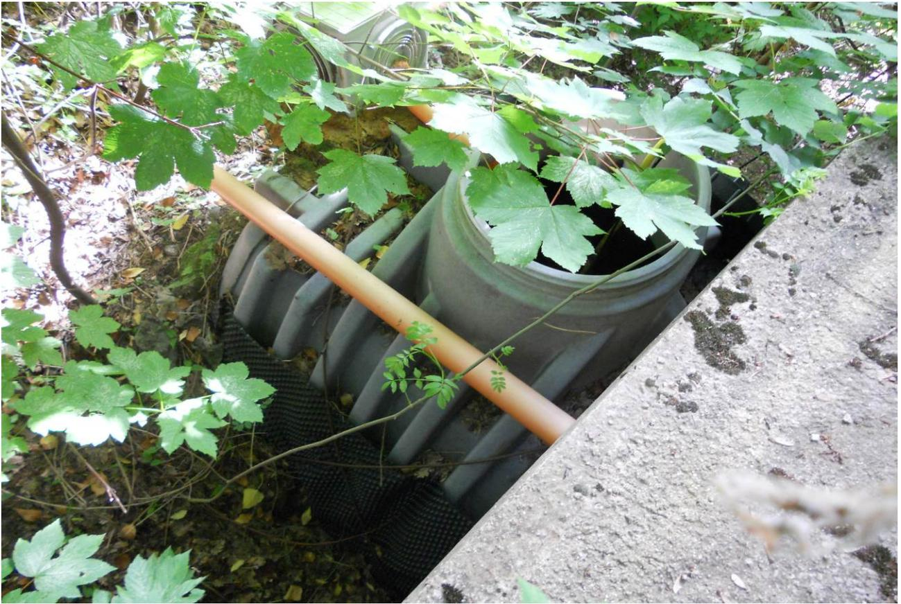
FOTO 15 – particolare cisterna raccolta acque piovane posizionata sul lato a monte
