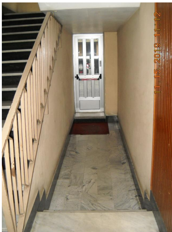
Foto 9 – accesso al cortile
