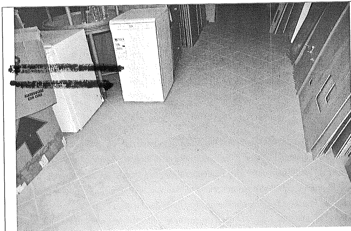
Foto n. 8 – Garage sub 17, particolare della pavimentazione
