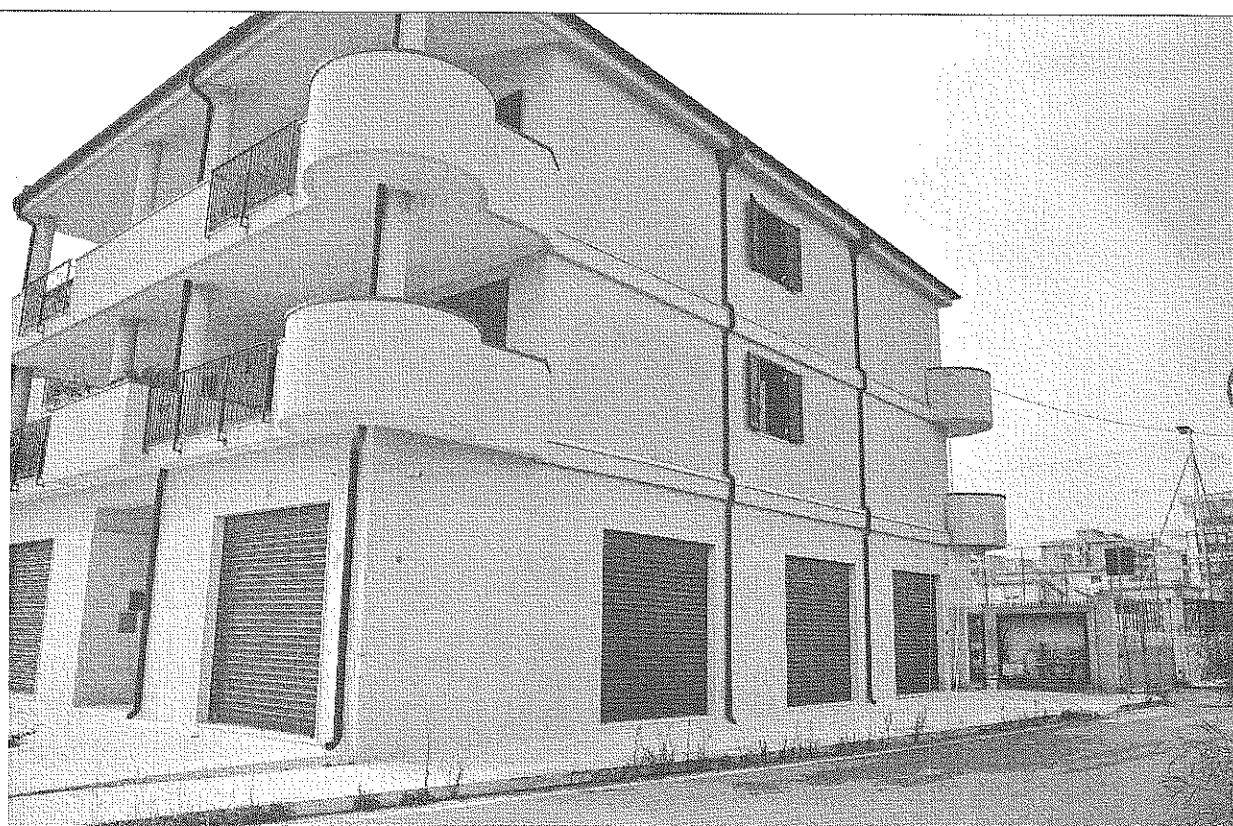
FOTO N.5 – Prospetto dell'edificio lato nord
