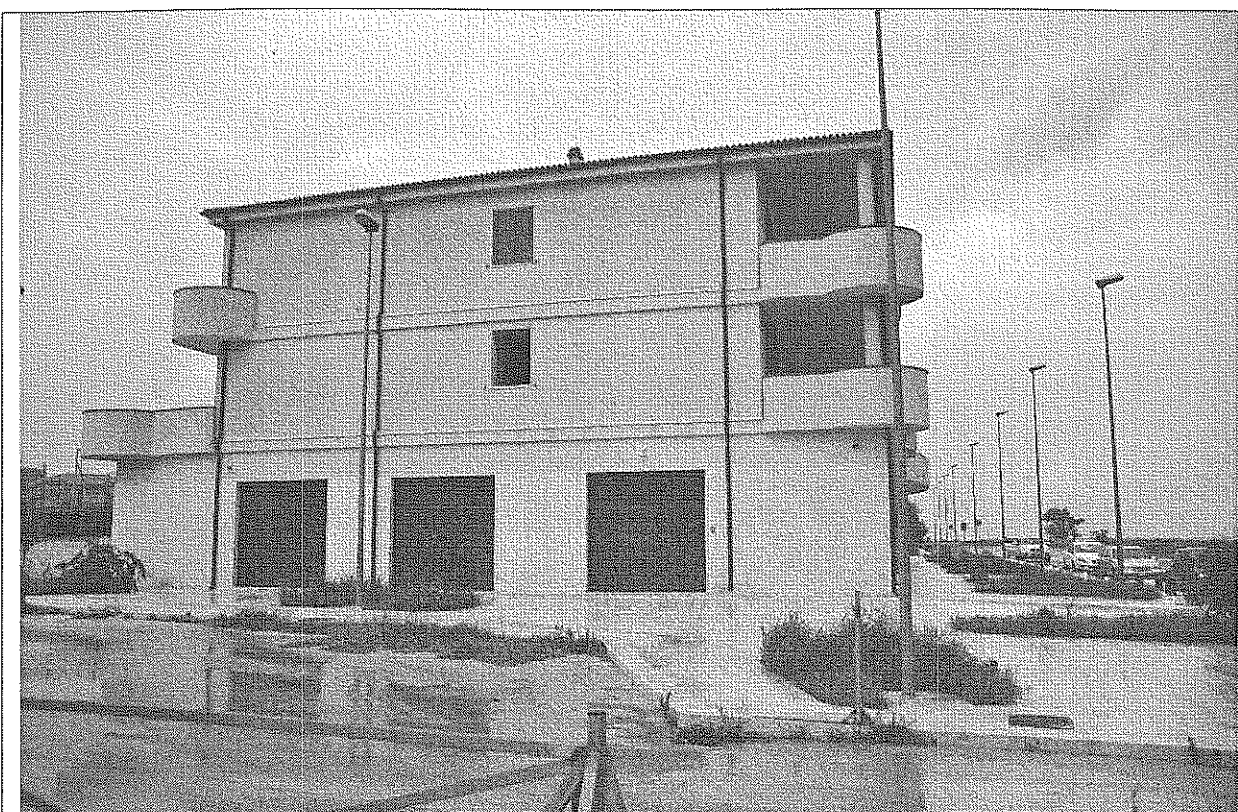
FOTO N.2 – Prospetto dell'edificio lato sud
