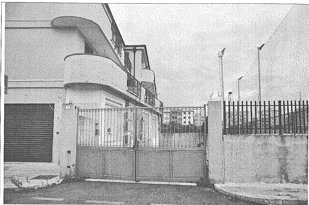
FOTO N.4 – Prospetto dell'edificio lato ovest
