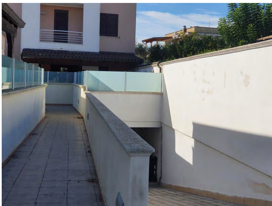
Prospetto interno Principale su area comune
