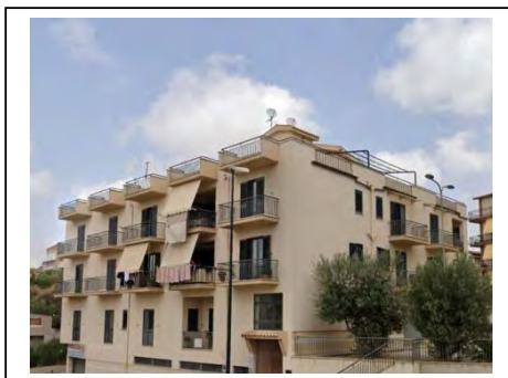
Esterno fabbricato e vano scala
