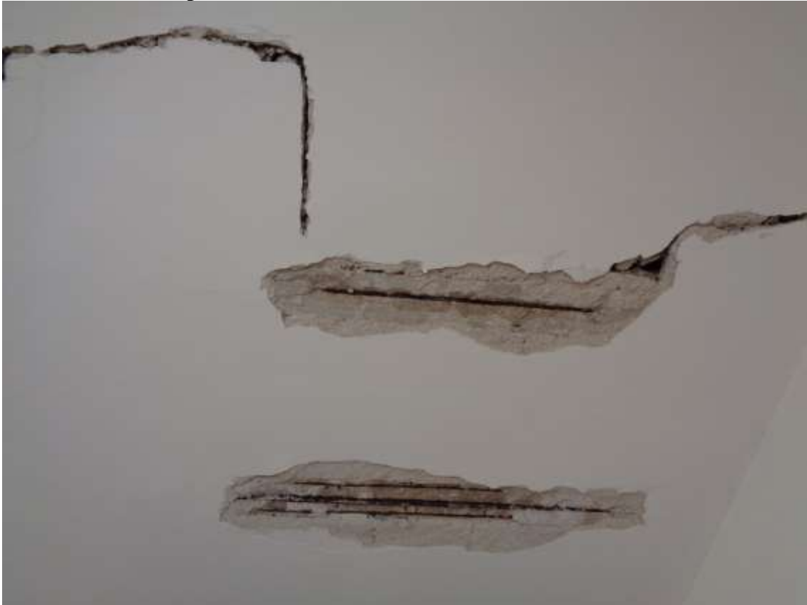
ispezione travi del solaio stanza da letto
