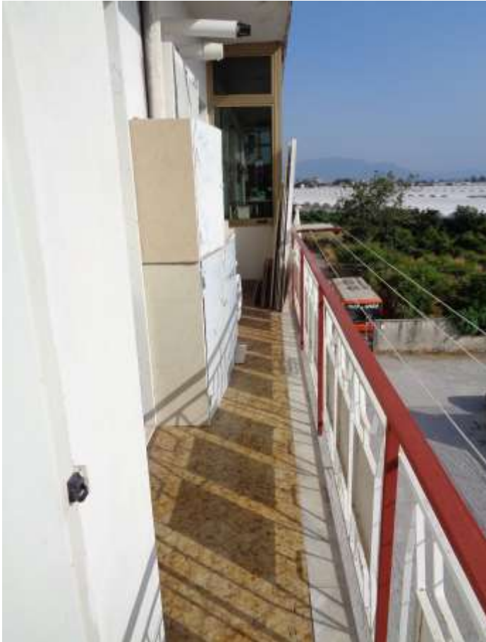
balcone con veranda
