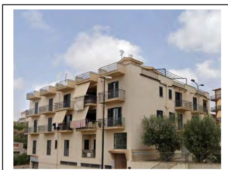
Esterno fabbricato e vano scala
