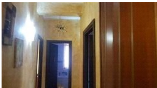
particolare porte interne, luci e tinteggiatura pareti
