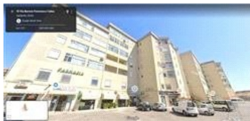
prospetto ovest (via Celsa) estratto da google maps
