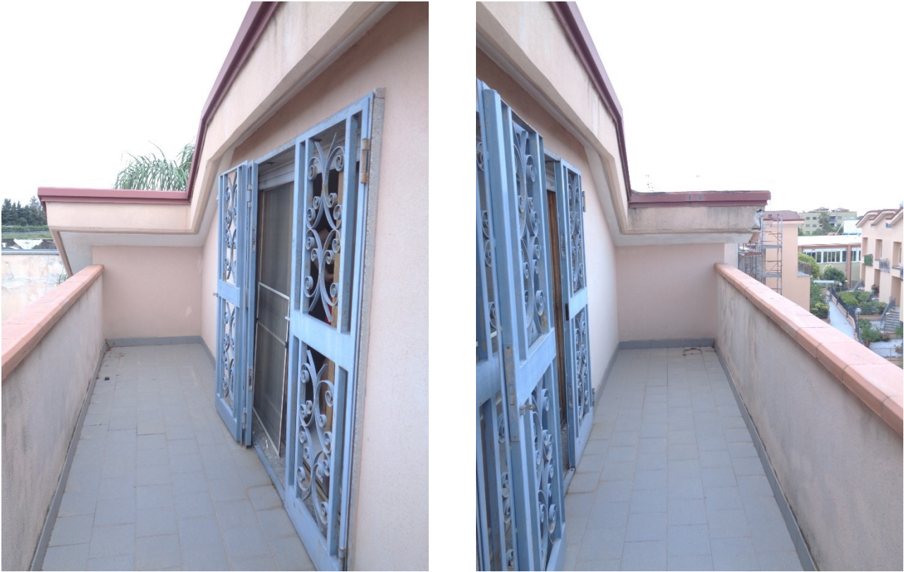
Piano secondo – balcone lato Sud
