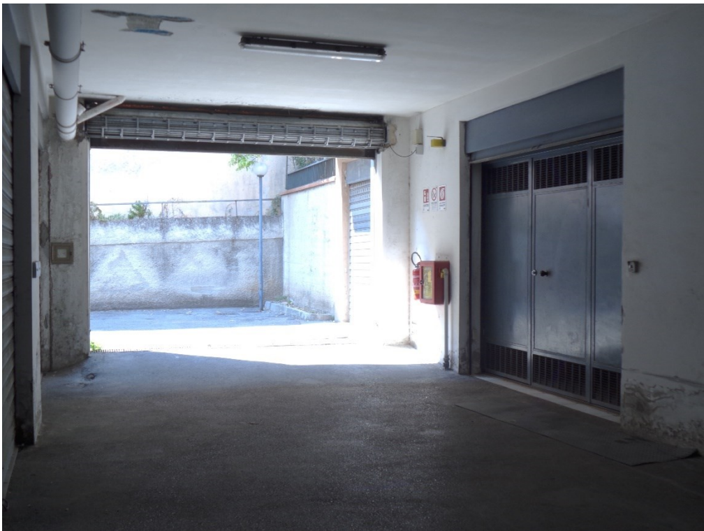
Percorso carrabile interrato – ingresso autorimessa
