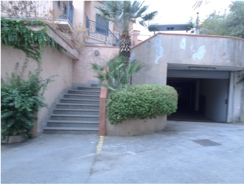
Scale di accesso percorso pedonale principale e ingresso esterno percorso carrabile interrato
