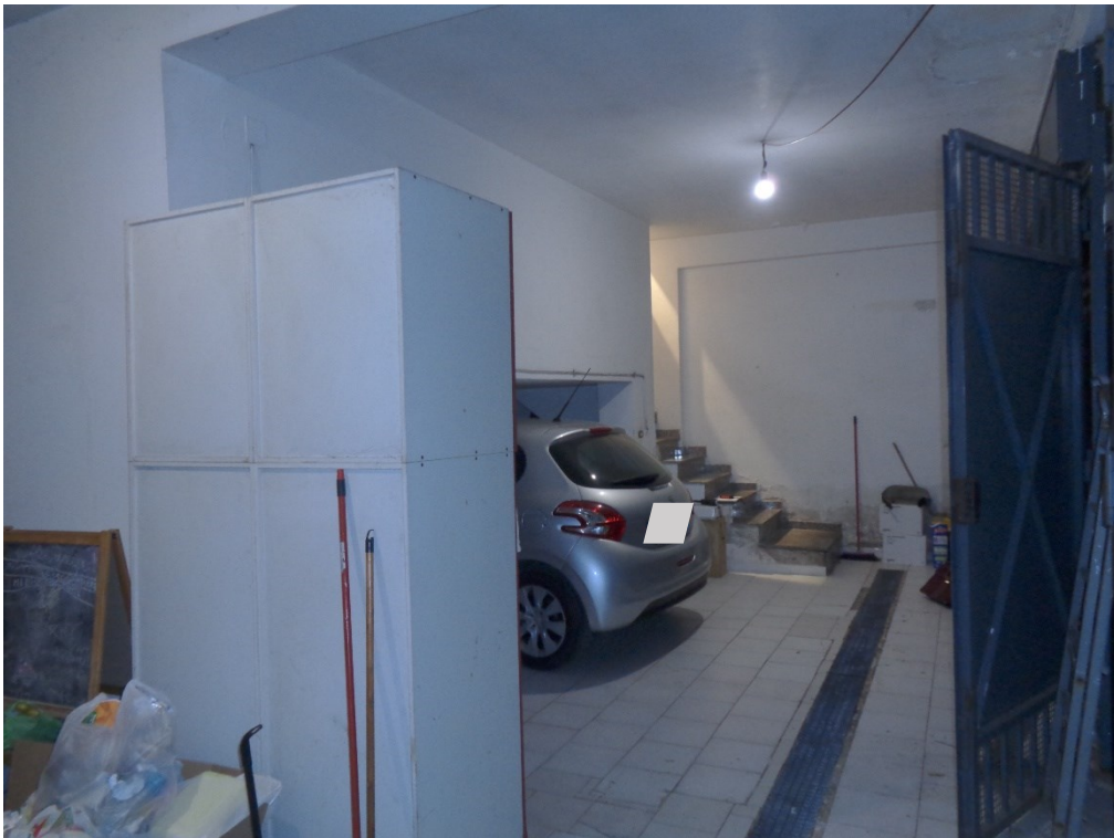
Autorimessa e scala di accesso al seminterrato
