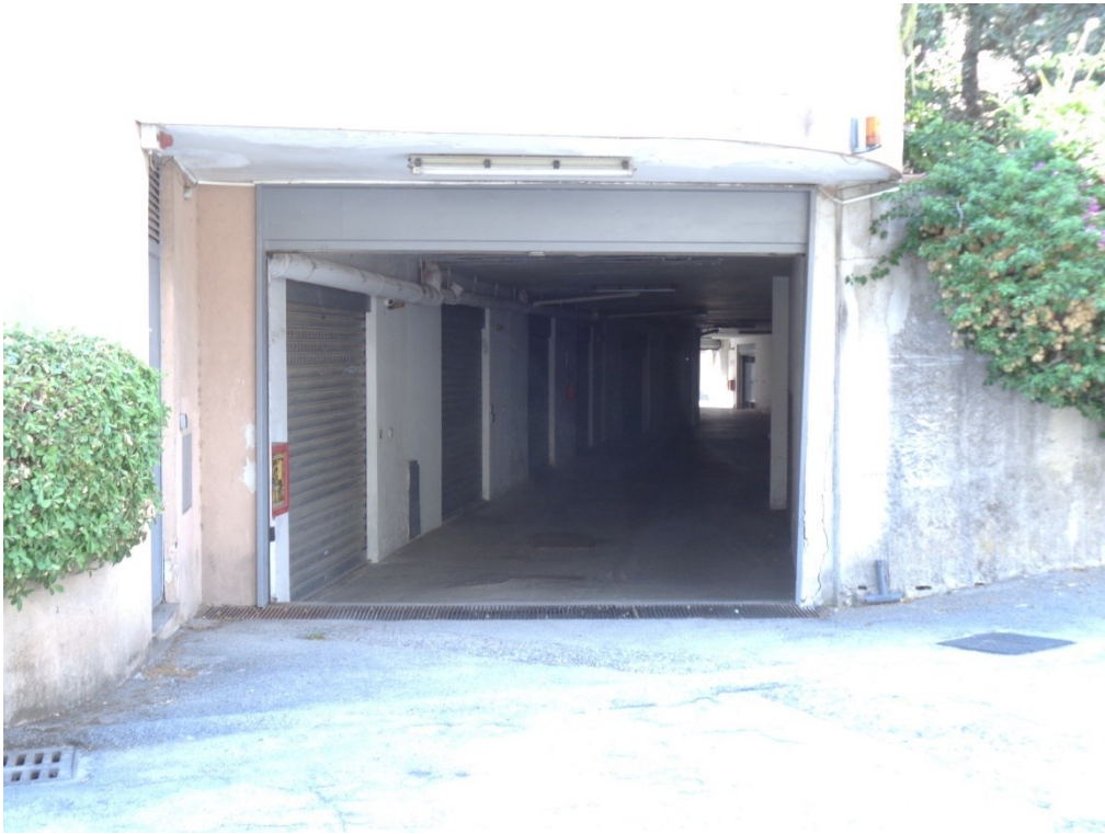
Percorso carrabile interrato
