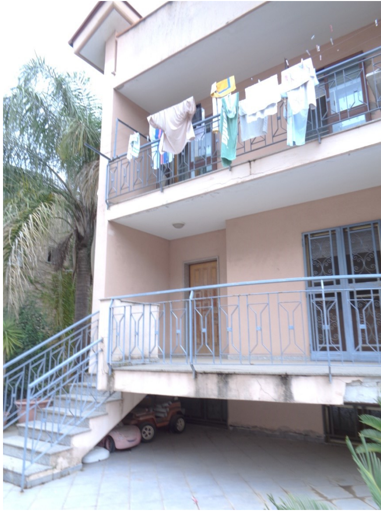
Vista esterna dallo spazio privato esterno a quota del percorso pedonale principale - lato Sud
