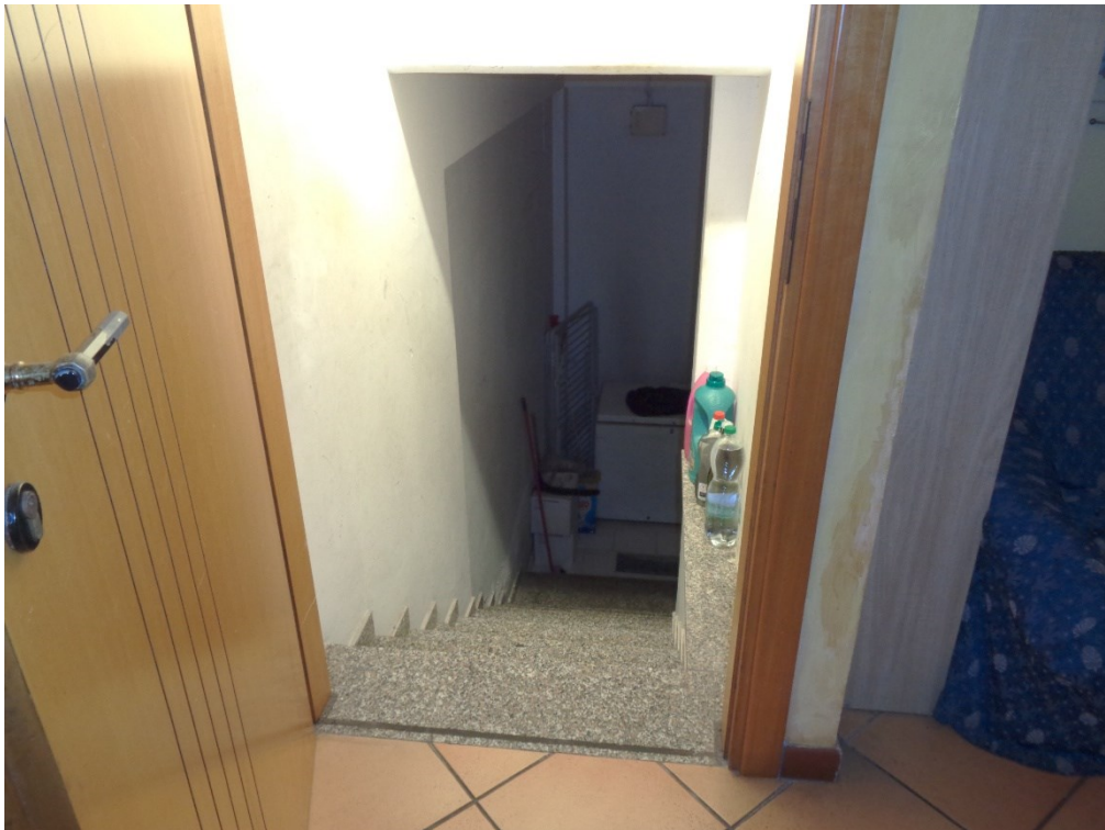
Scala di accesso dal seminterrato al piano interrato
