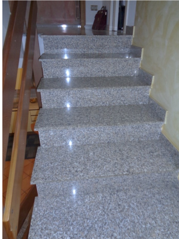
Scala di accesso al piano terra
