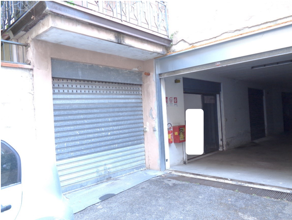
Ingresso esterno deposito interrato e accesso autorimessa
