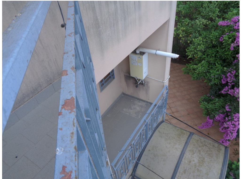
Piano primo – vista balcone del piano terra – lato Nord
