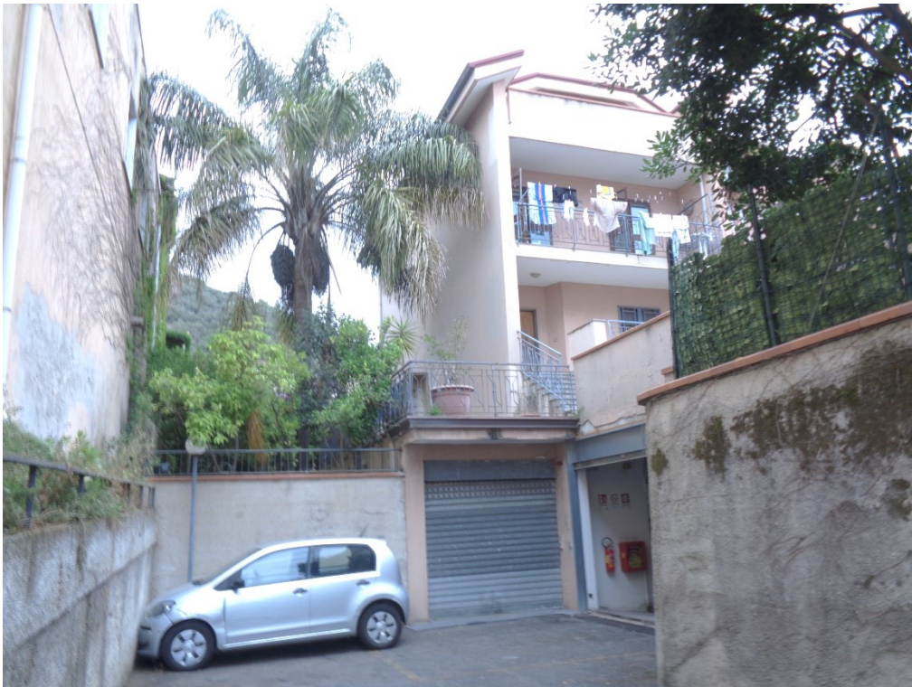
Ingresso esterno deposito interrato e vista lato Sud
