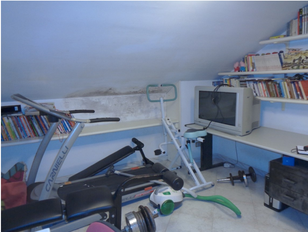
Piano secondo – camera/hobby lato Nord
