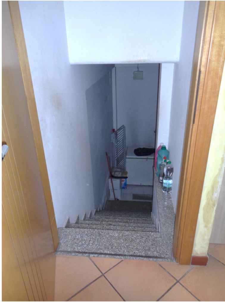
Scala di accesso dal seminterrato al piano interrato
