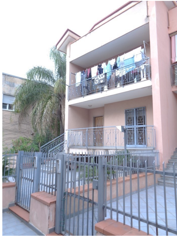
Vista lato Sud immobile
