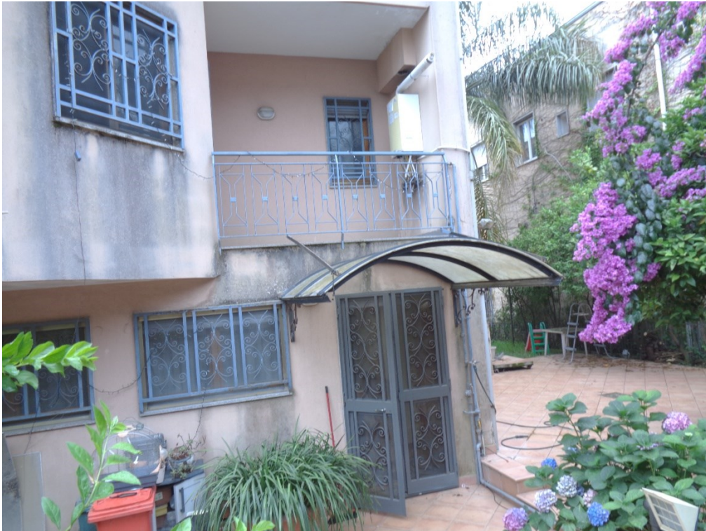
Piano seminterrato – ingresso esterno tavernetta - lato Nord
