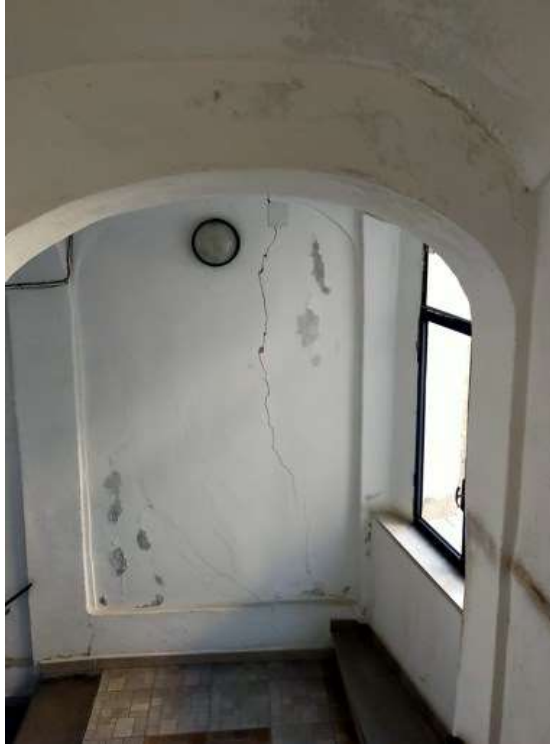
Figura n. 14 - Foto vano scala
