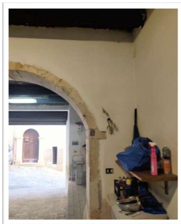
Figura n. 9 - Locale Piano Terra
