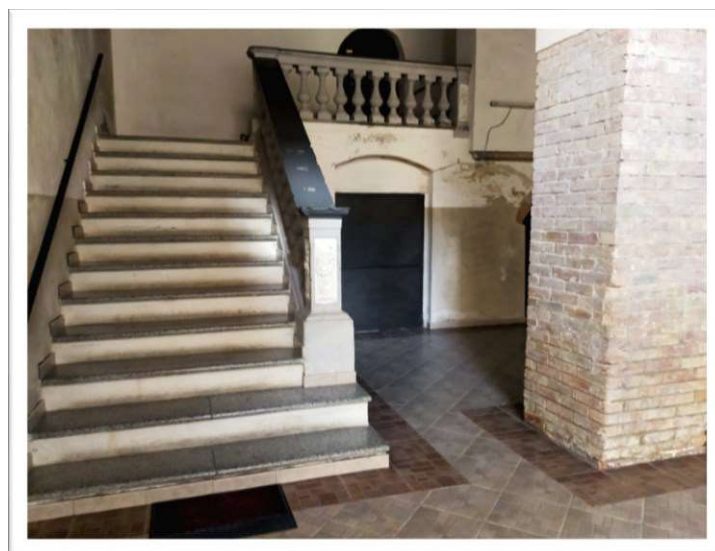
Figura n. 13 - Foto vano scala
