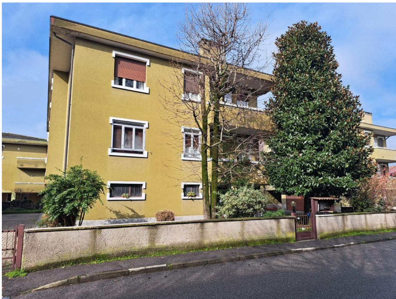
Foto 1 – Vista esterna fronte
