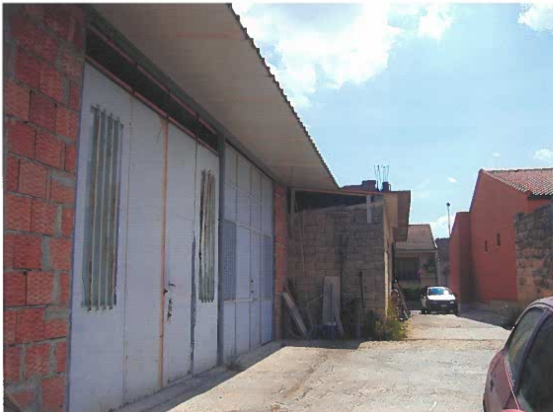
Foto 28 . Vista laterale Locale Ricovero Attrezzi , posto sul retro del Deposito , con stradella privata.
