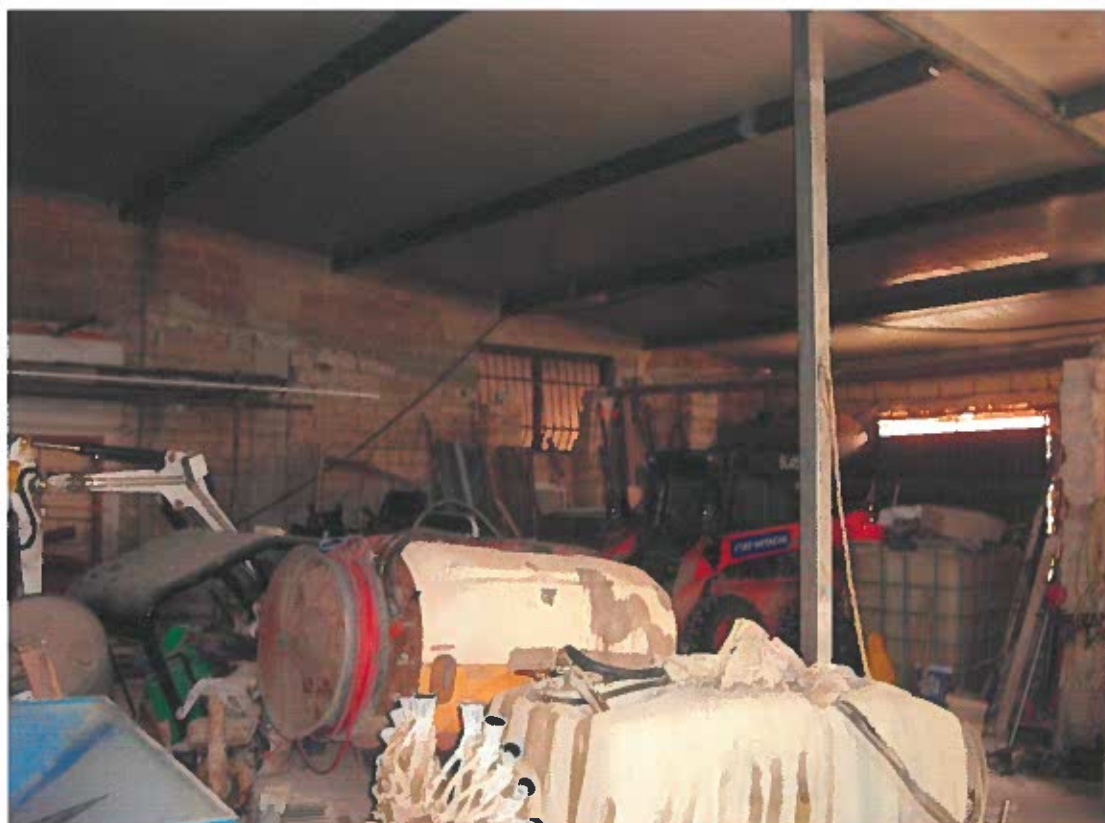
Foto 31 . Vista interna del Locale Ricovero Attrezzi e Macchinari ( si nota struttura precaria ).
