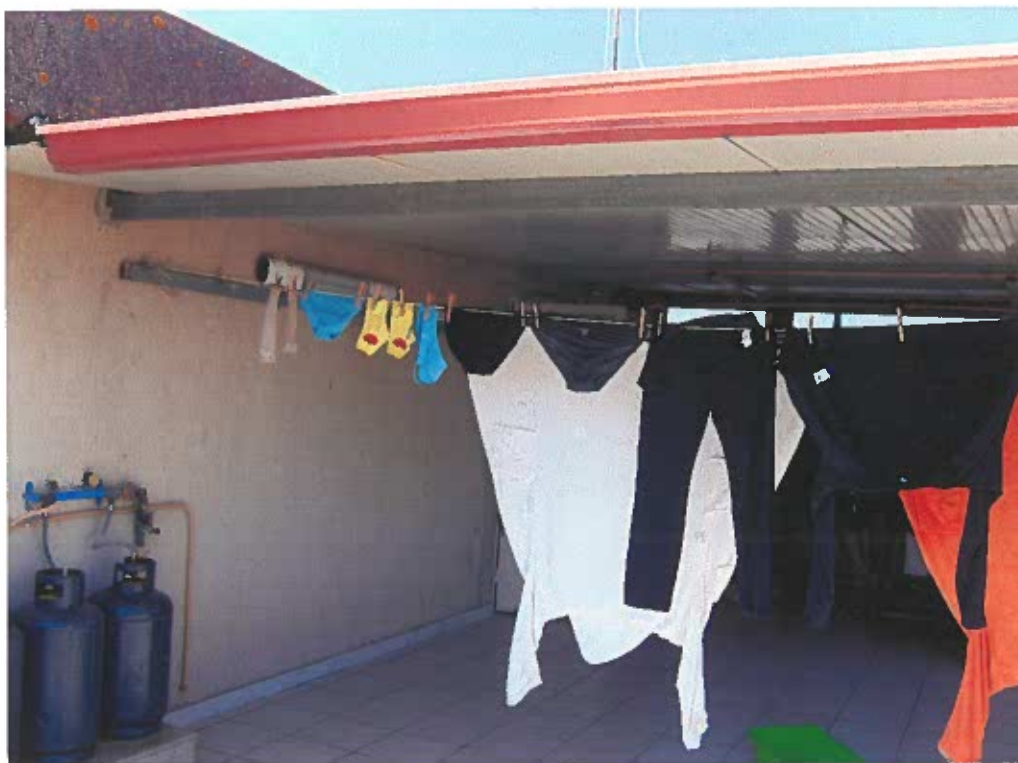
Foto 23 . Terrazza con copertura leggera .
