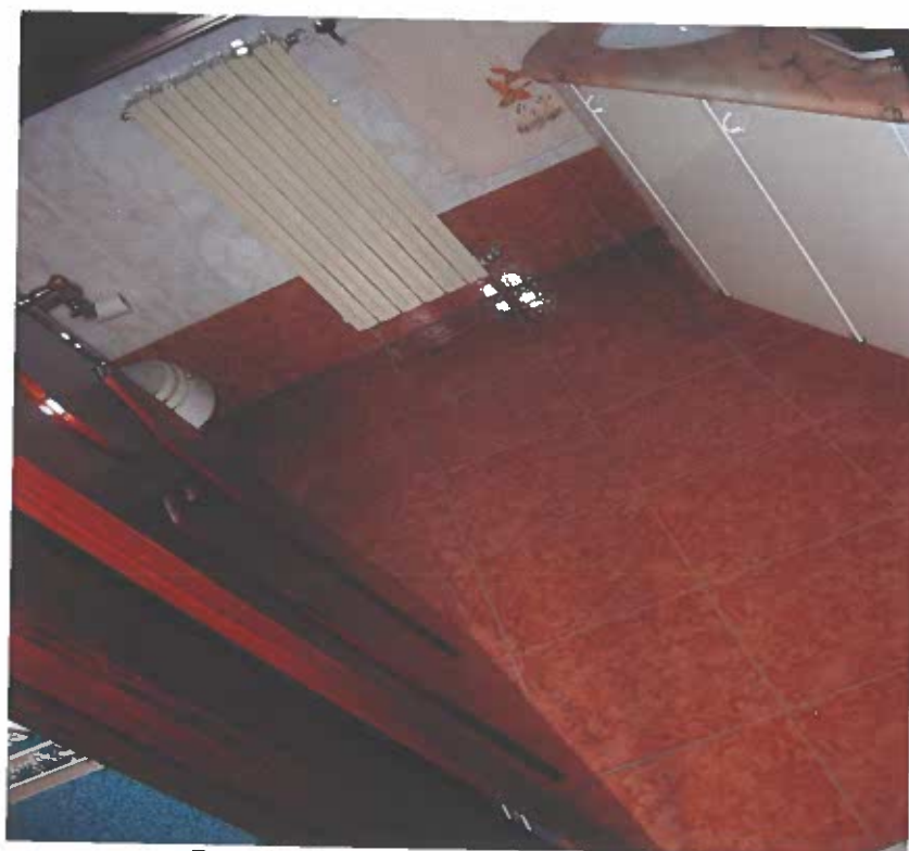
Foto 12 . Appartamento Piano Primo : Bagno
