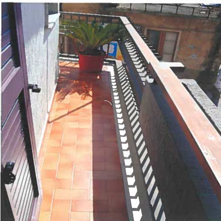
Foto 14 . Appartamento Piano Primo : particolare balcone cucina.
