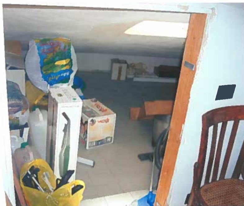
Foto 22 . Sottotetto non abitabile .
