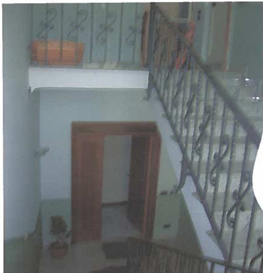
Foto 15 . Corpo scala : è visibile l'ingresso appartamento Piano Secondo e l'accesso al sottotetto.
