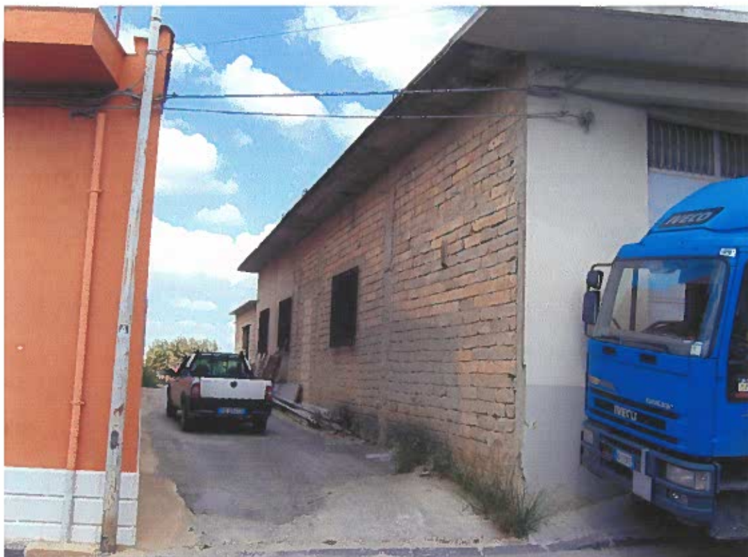
Foto 27 . Vista laterale Deposito , con accesso stradella privata della stessa ditta.
