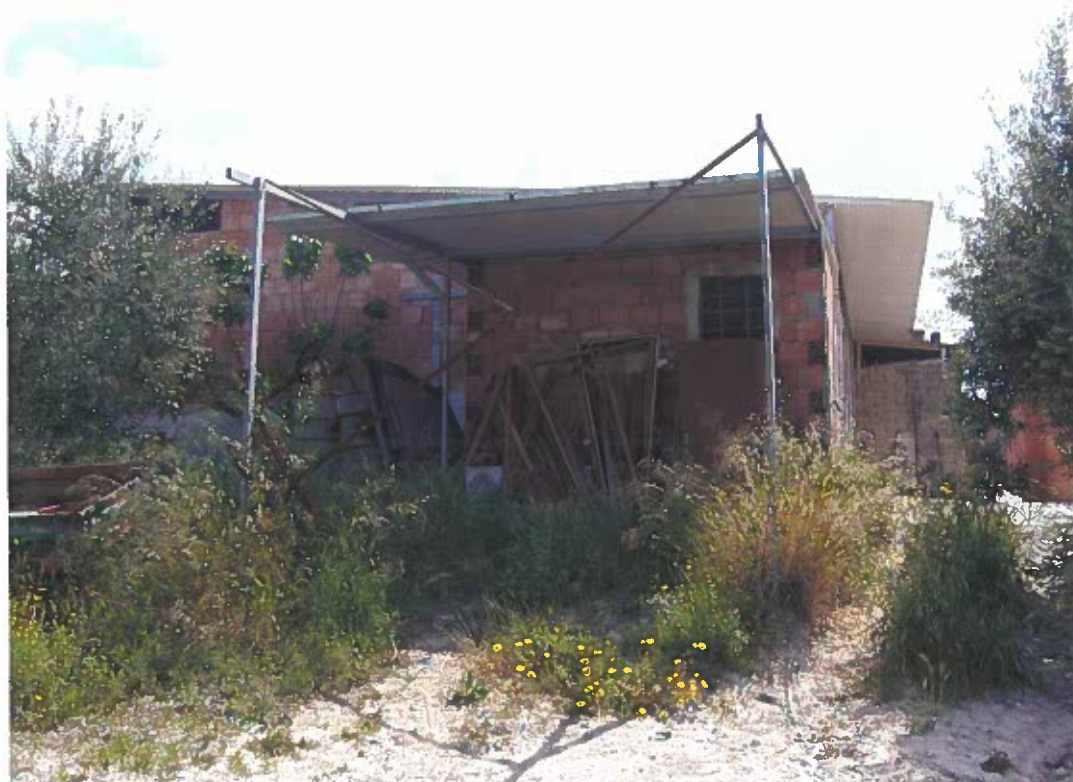
Foto 29 . Vista nord del Locale Ricovero Attrezzi e Macchinari ( si nota locale ripostiglio e tettoia ).
