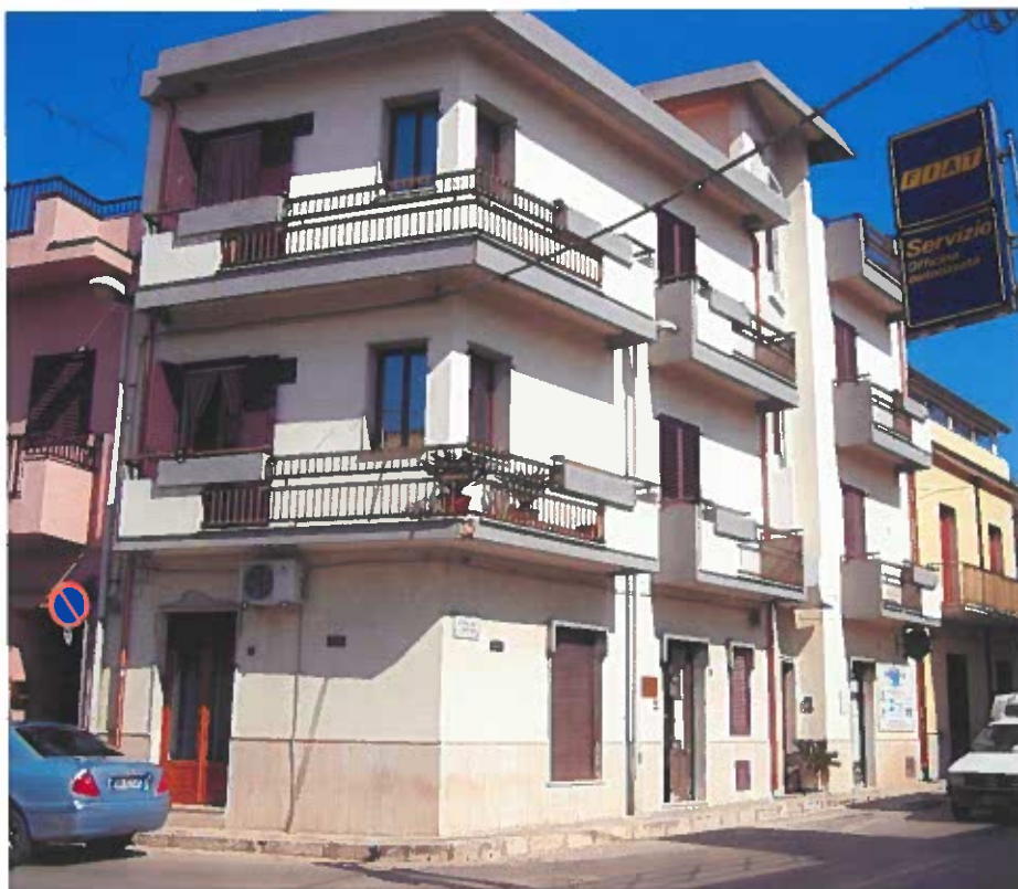
Foto. 1 . Vista di insieme edificio via Principe Umberto nn. 47-49-51-53
