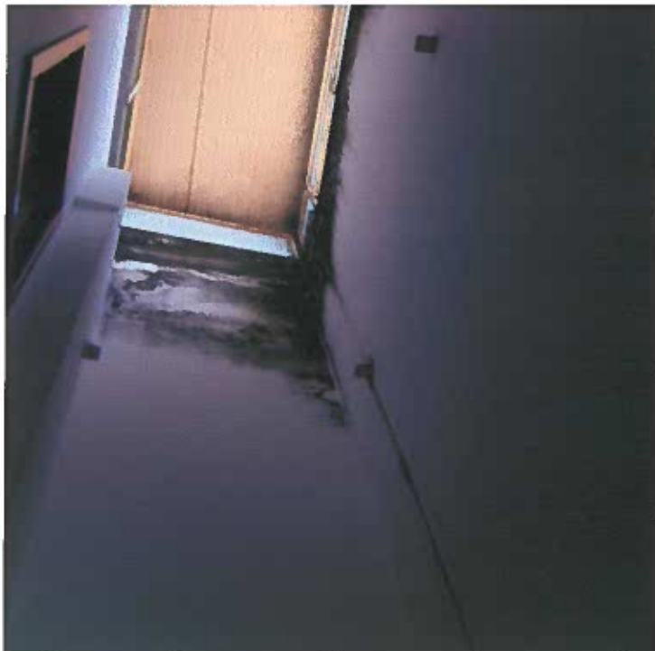
Foto 13 . Appartamento Piano Primo : Pozzo luce - ripost./lavand.
