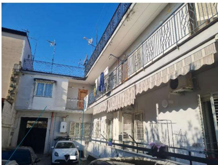
Locale lavanderia – porta di accesso
