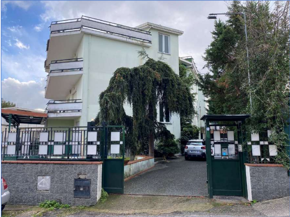
Foto 2. Cannello di ingresso fabbricato su via Lucci.
