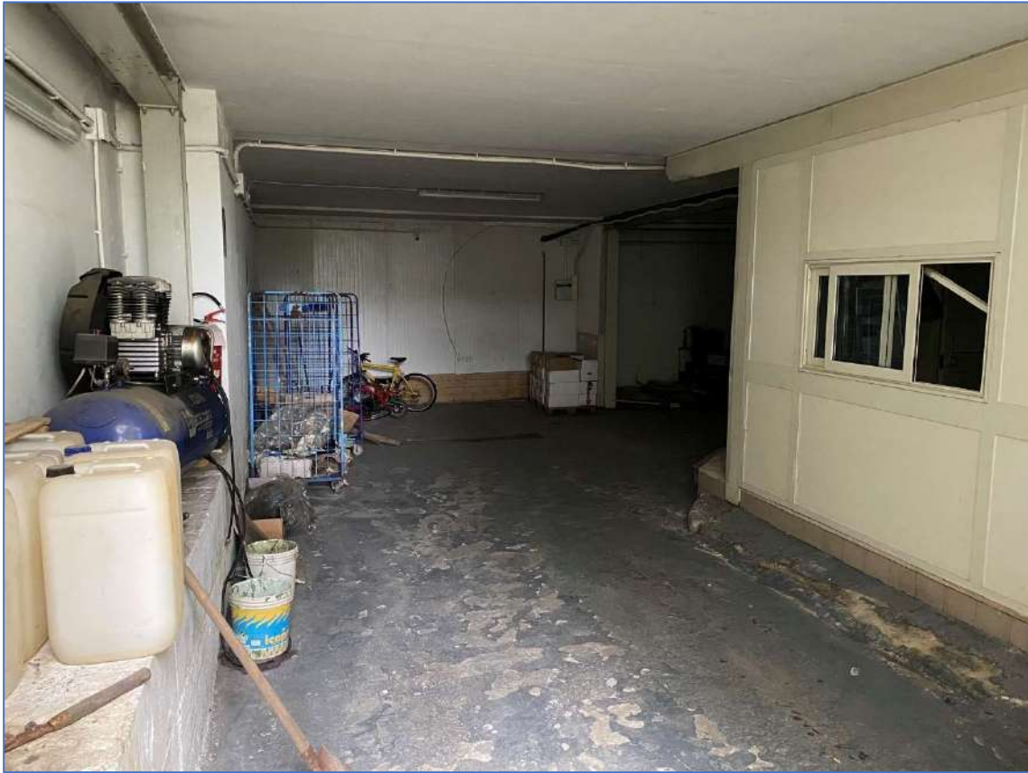
Foto 39. Immobile piano seminterrato, zona uffici.
