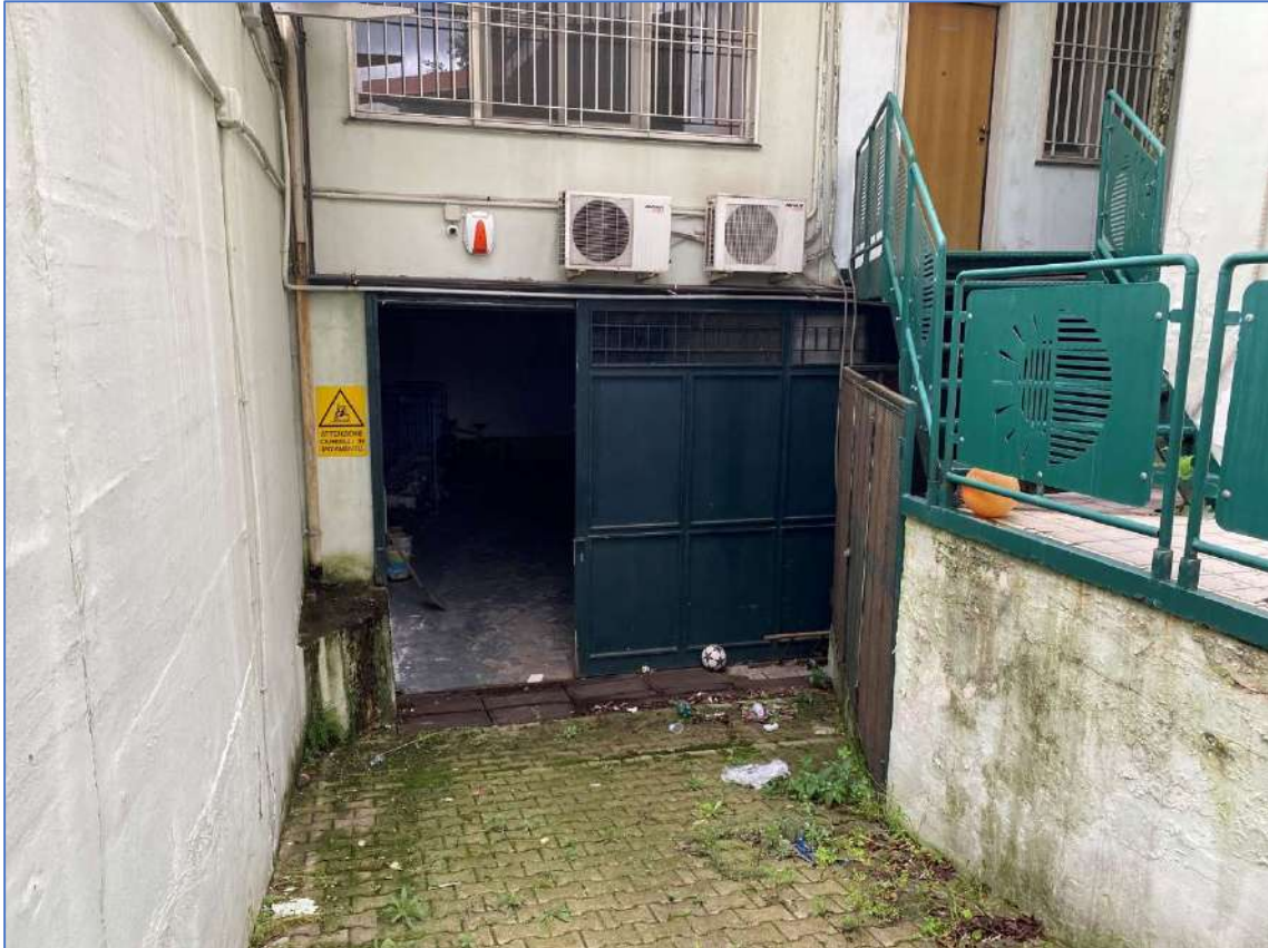
Foto 37. Ingresso immobile piano seminterrato (subalterni 7 e 8) da corte comune.
