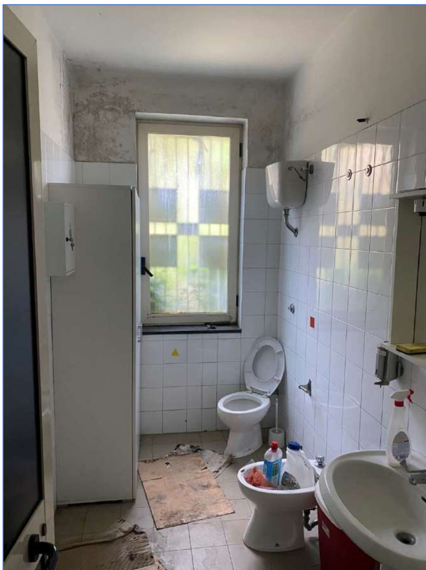
Foto 25. Interno immobile piano terra, zona uffici.
