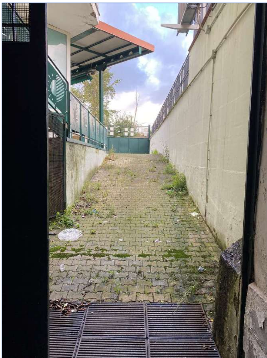
Foto 38. Rampa ingresso immobile piano seminterrato (subalterni 7 e 8).
