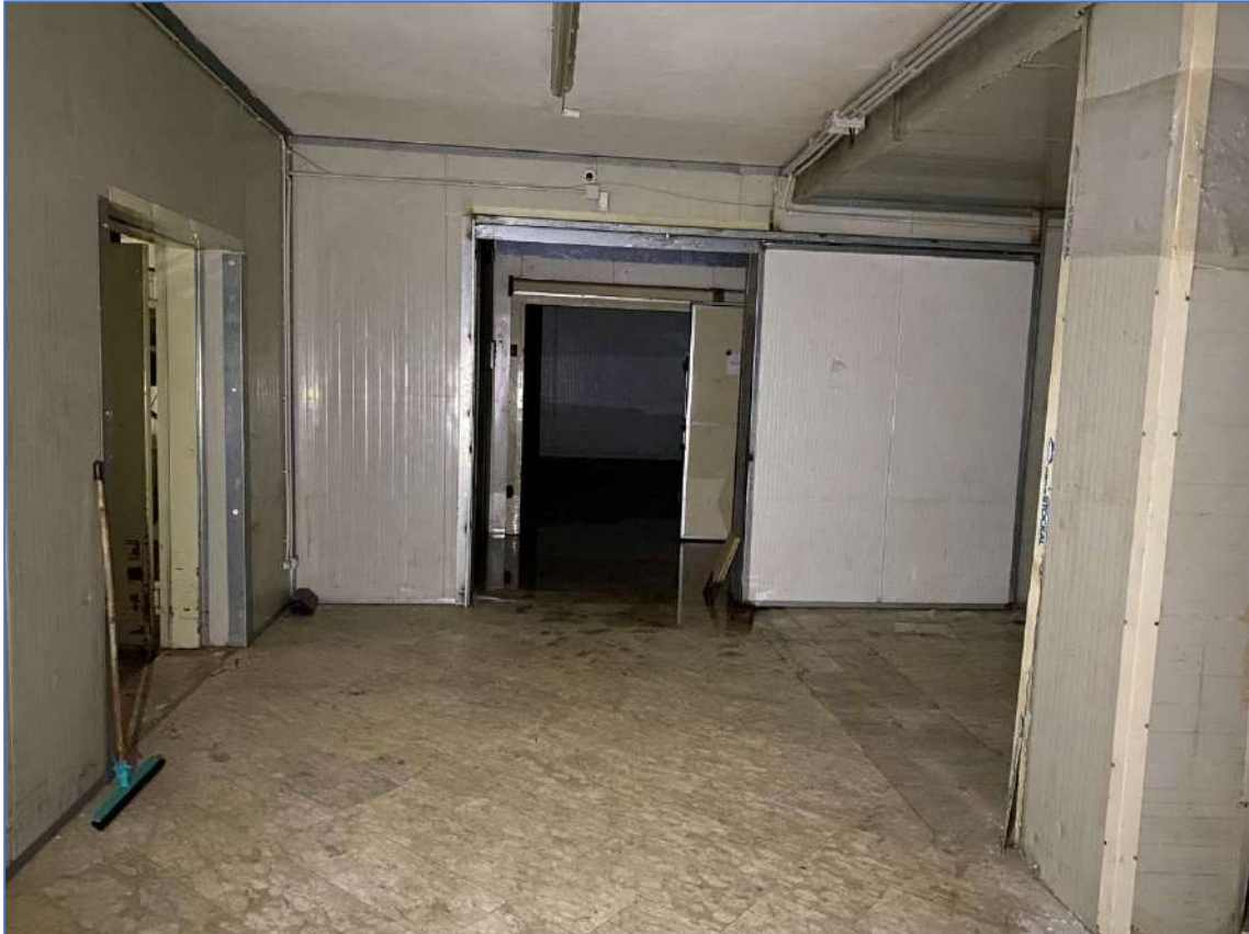
Foto 46. Immobile piano seminterrato, zona magazzino.
