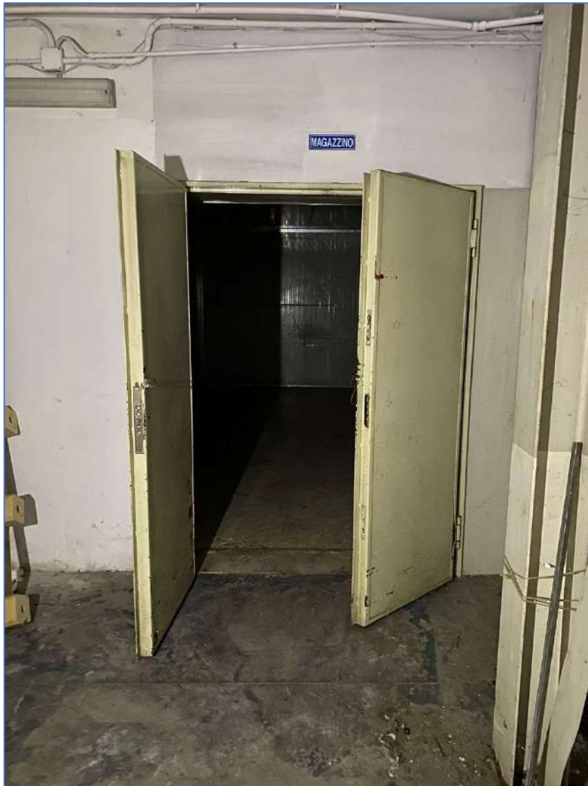
Foto 44. Immobile piano seminterrato, ingresso zona magazzino.
