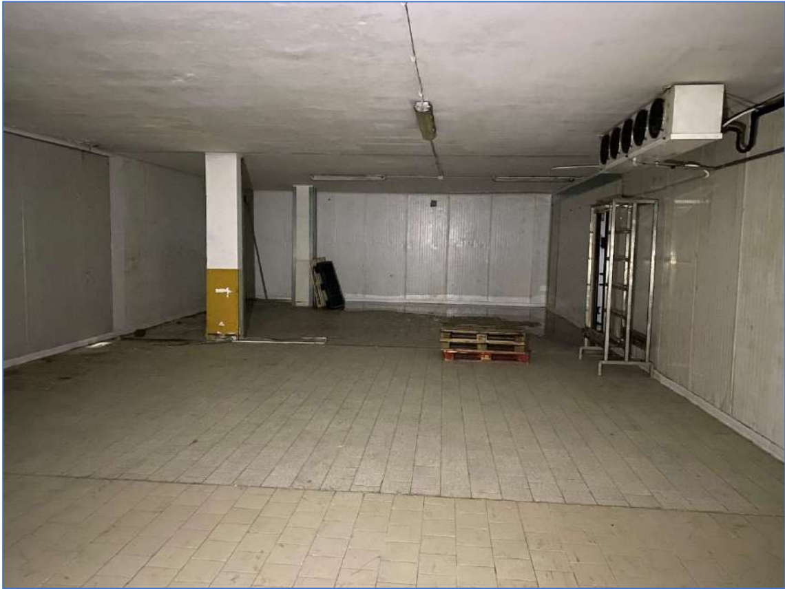
Foto 50. Immobile piano seminterrato, zona magazzino.
