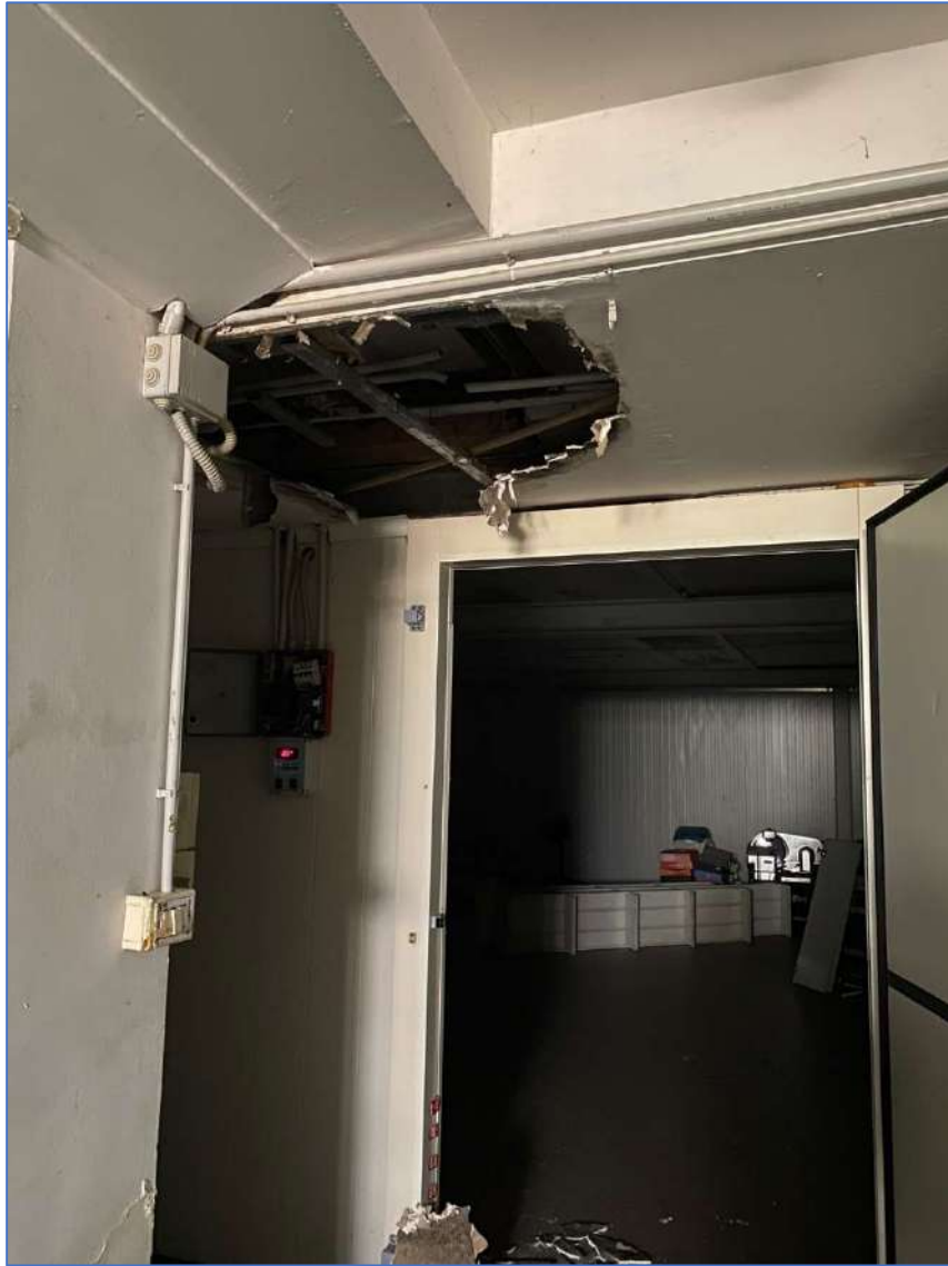
Foto 35. Interno immobile piano terra, zona magazzino.
