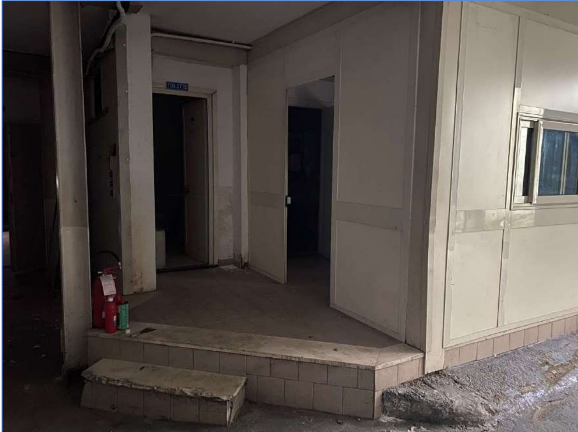
Foto 40. Immobile piano seminterrato, zona uffici.
