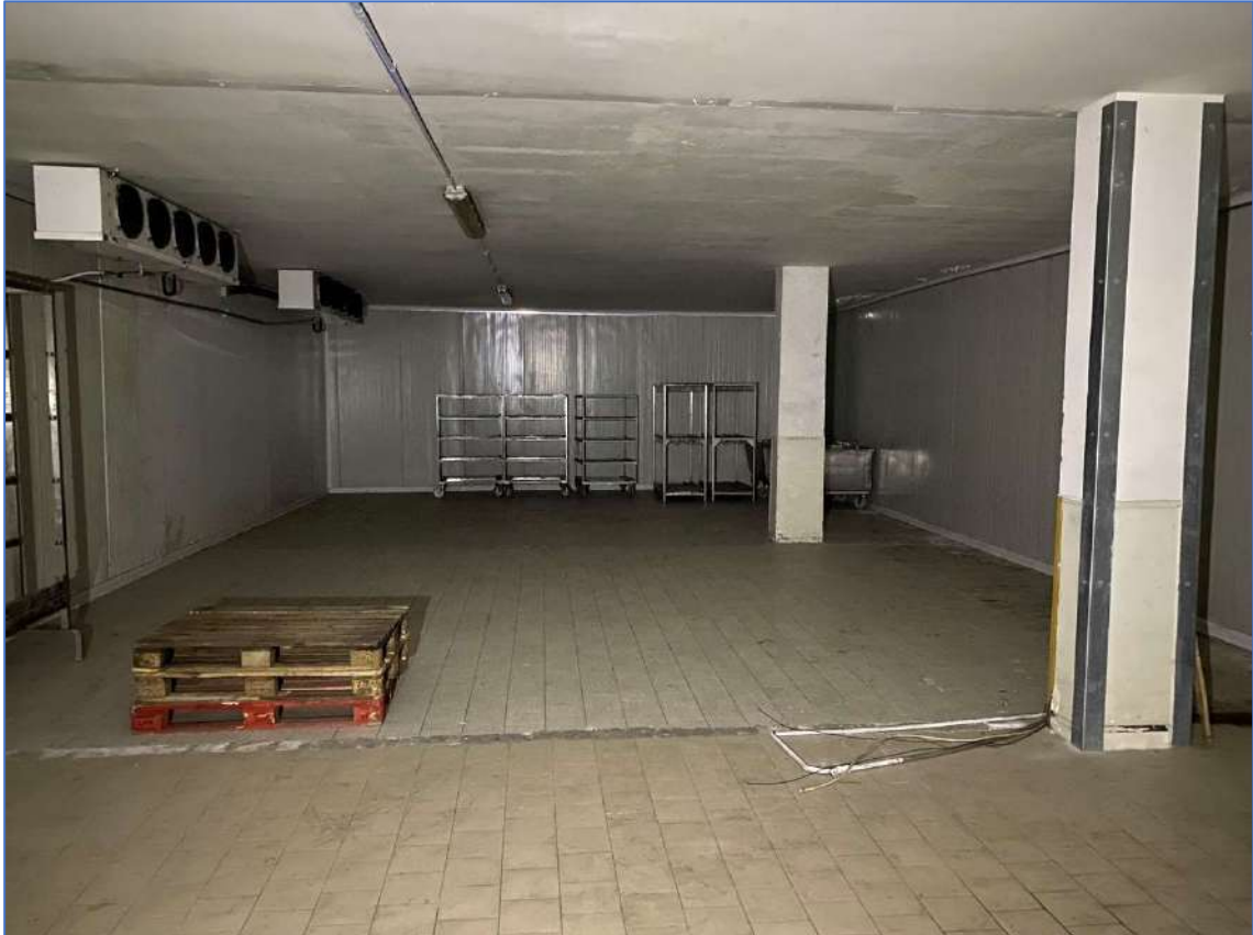
Foto 49. Immobile piano seminterrato, zona magazzino.
