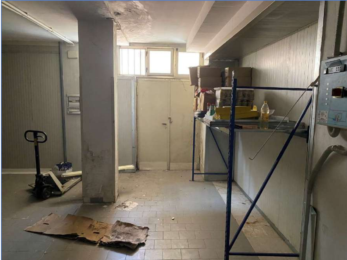
Foto 34. Interno immobile piano terra, zona magazzino.
