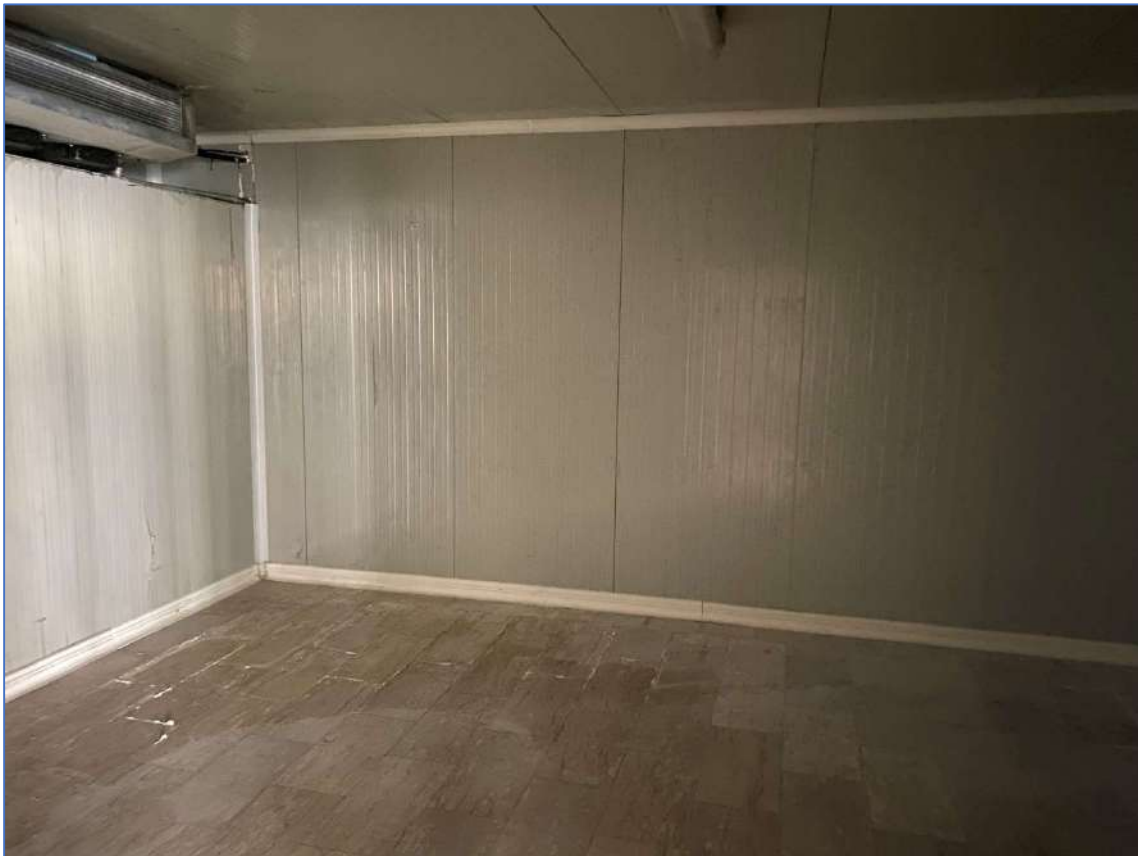
Foto 29. Interno immobile piano terra, zona magazzino.
