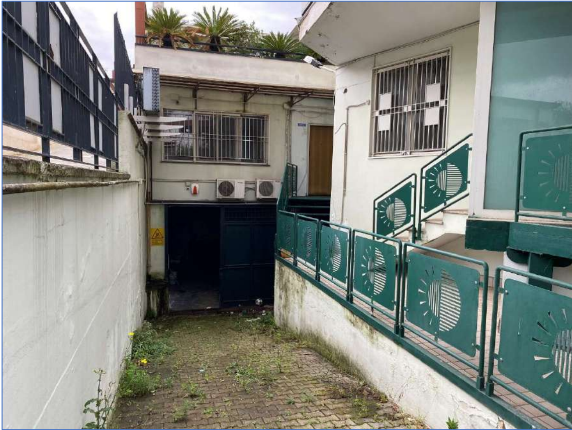
Foto 36. Ingresso immobile piano seminterrato (subalterni 7 e 8) da corte comune.
