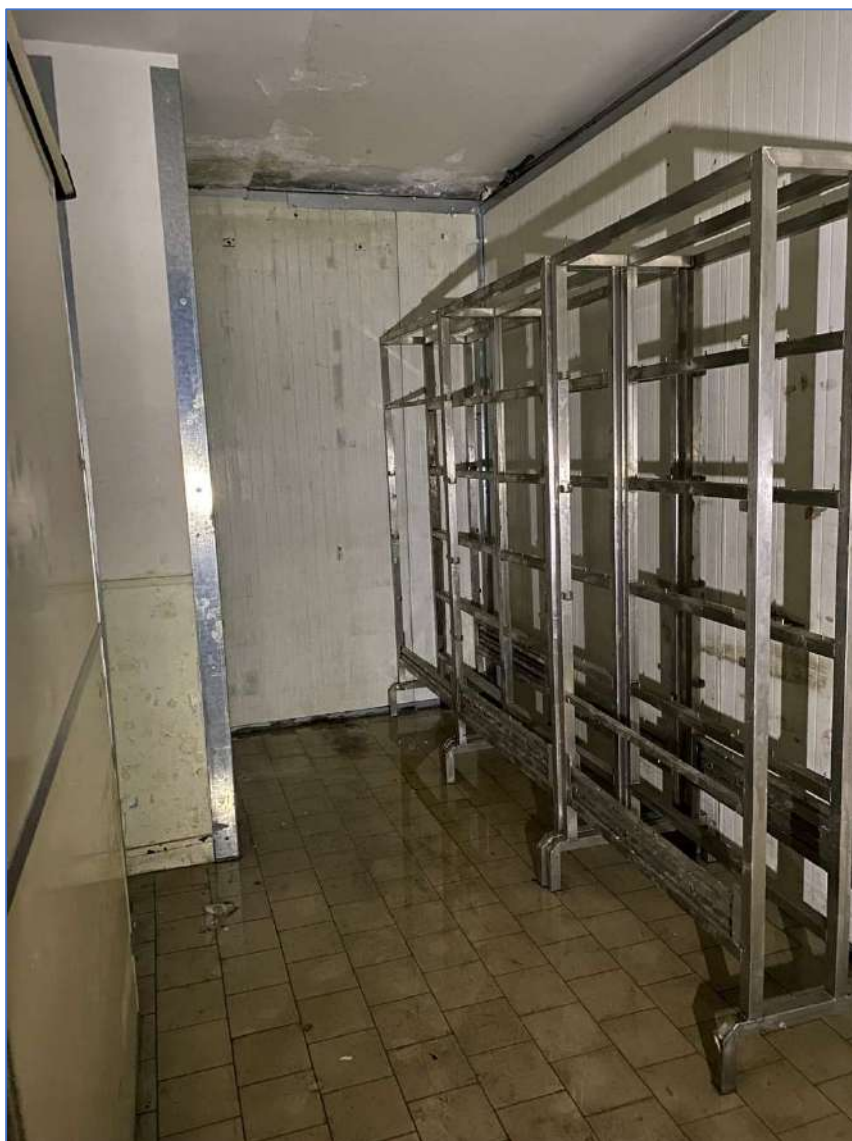
Foto 47. Immobile piano seminterrato, zona magazzino.
