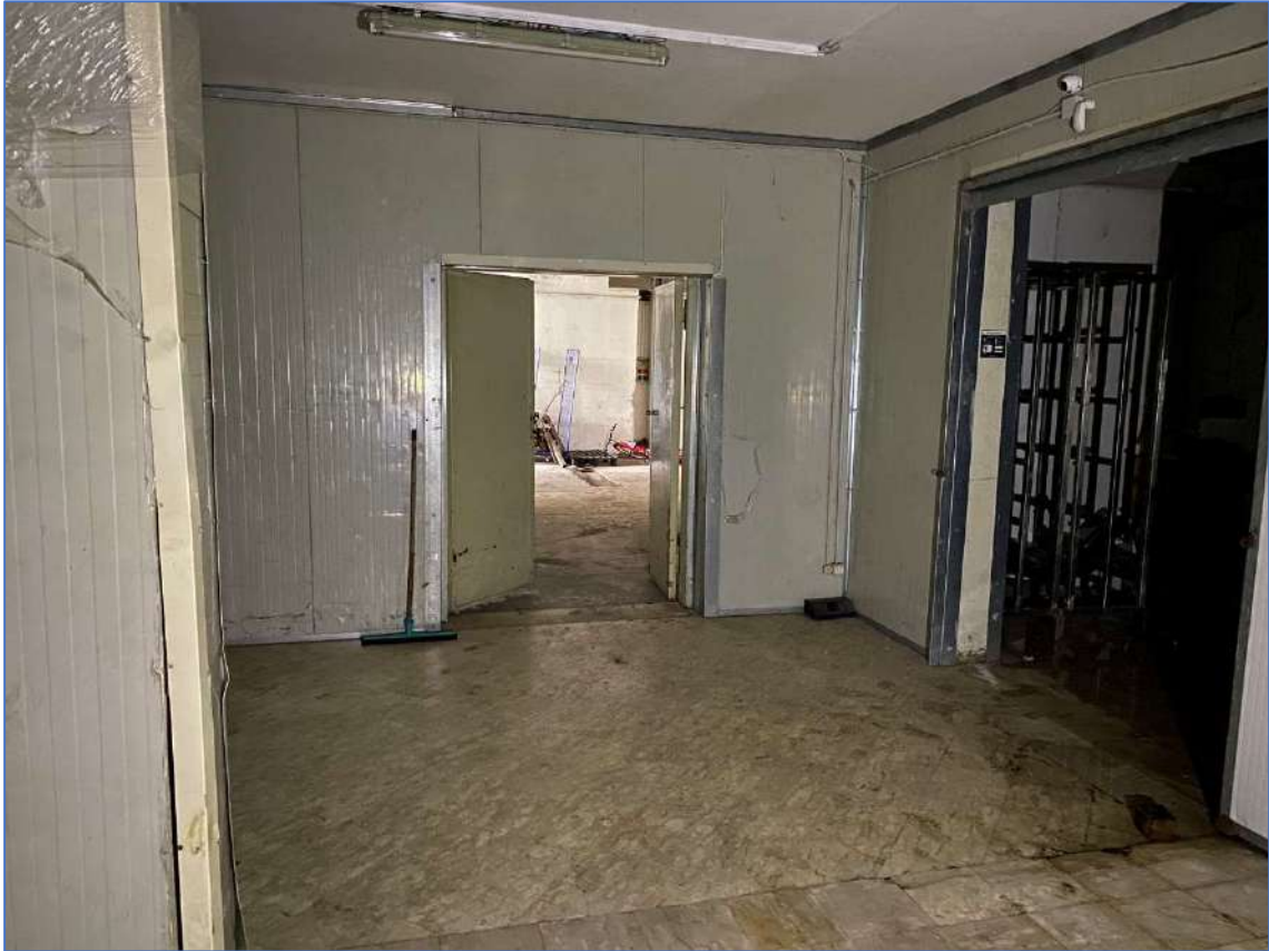
Foto 51. Immobile piano seminterrato, zona magazzino.
