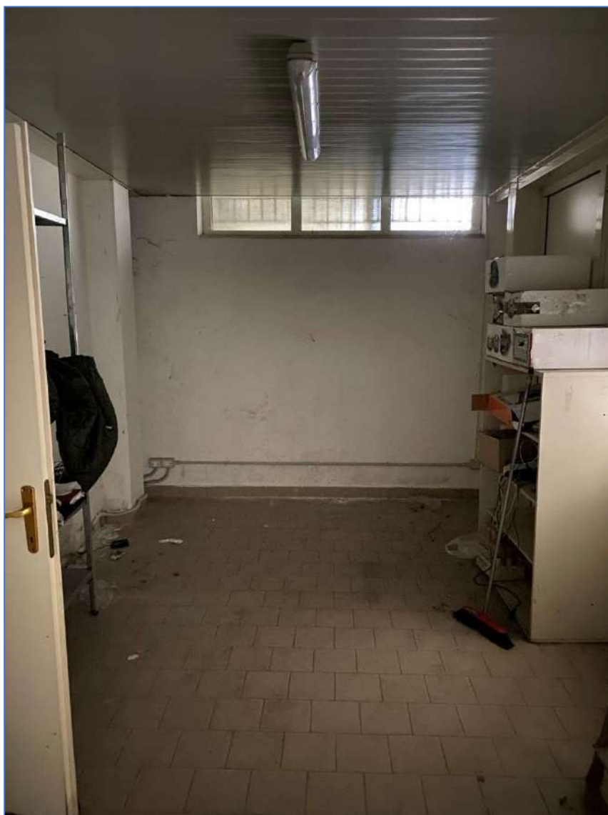
Foto 41. Immobile piano seminterrato, zona uffici.
