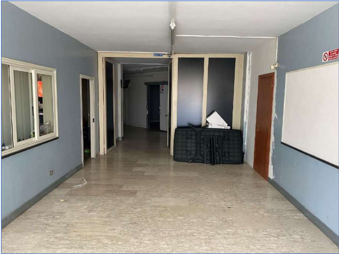
Foto 15. Interno immobile piano terra, zona uffici.
