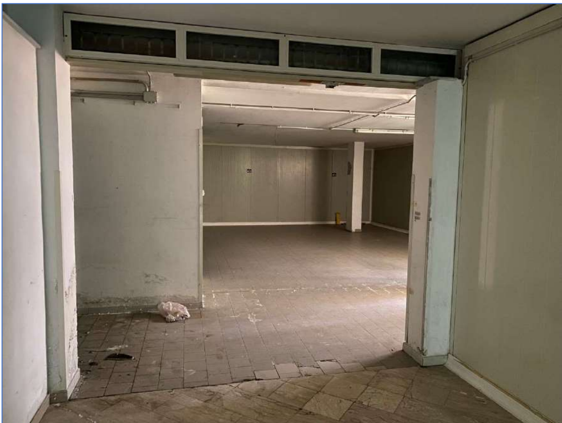
Foto 30. Interno immobile piano terra, zona magazzino.
