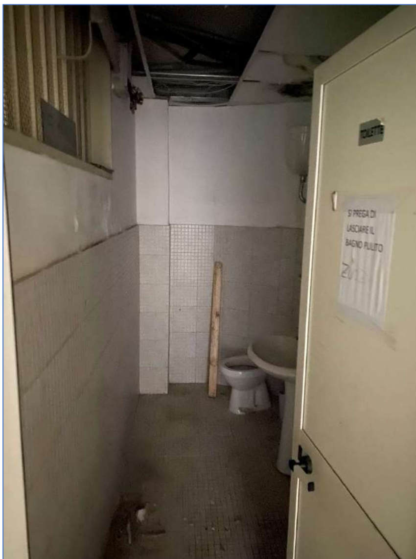
Foto 43. Immobile piano seminterrato, zona uffici.
