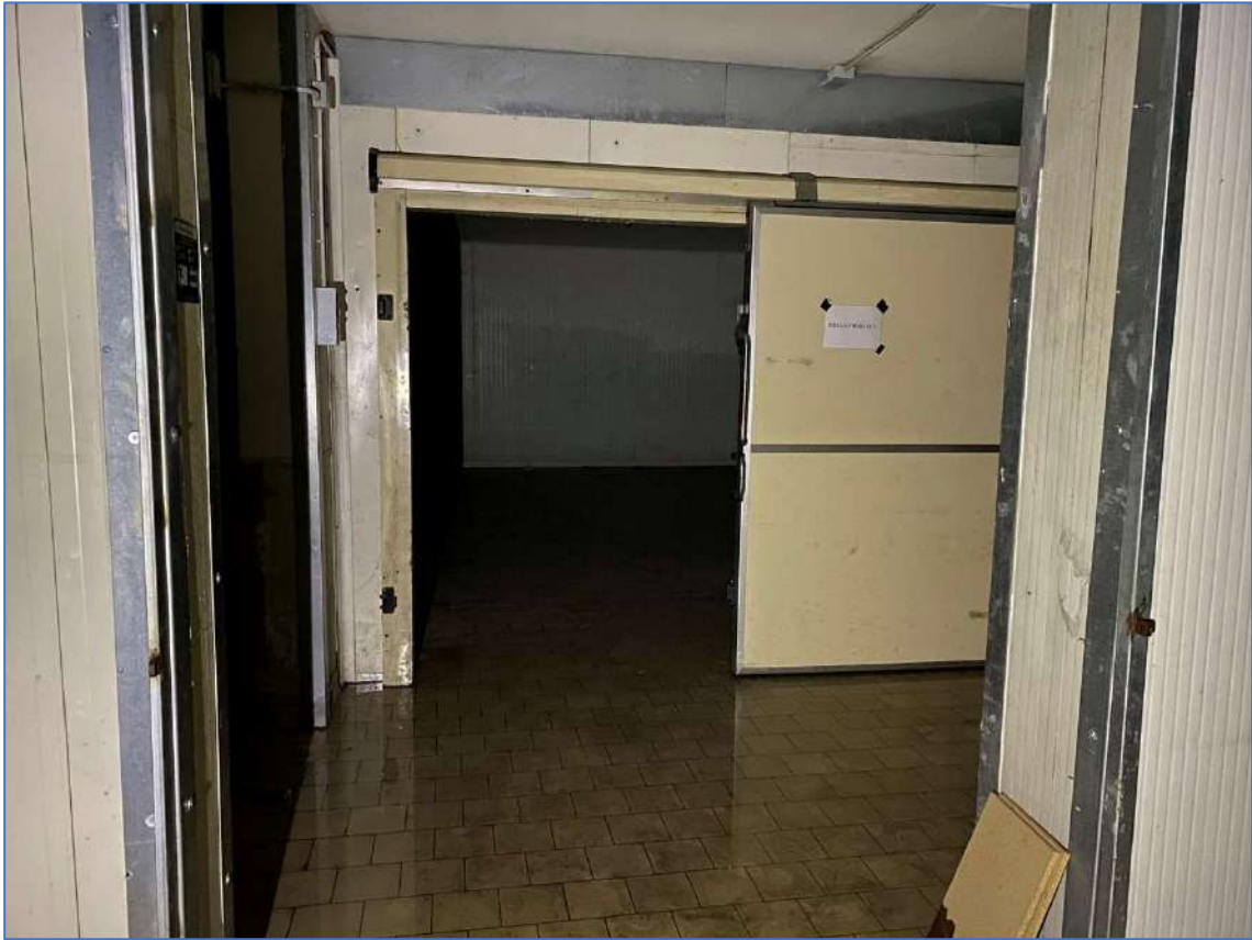
Foto 48. Immobile piano seminterrato, zona magazzino.
