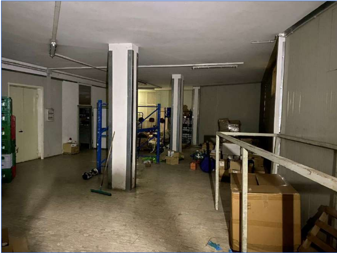
Foto 45. Immobile piano seminterrato, zona magazzino.
