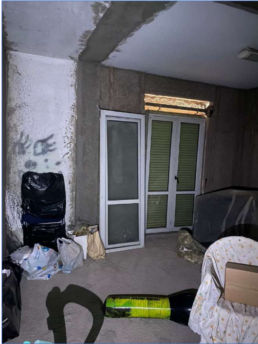
Foto 18. Porzione di immobile non rifinita.
