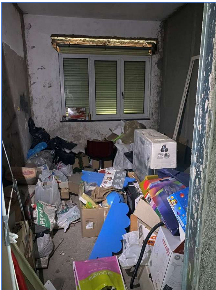
Foto 17. Porzione di immobile non rifinita.
