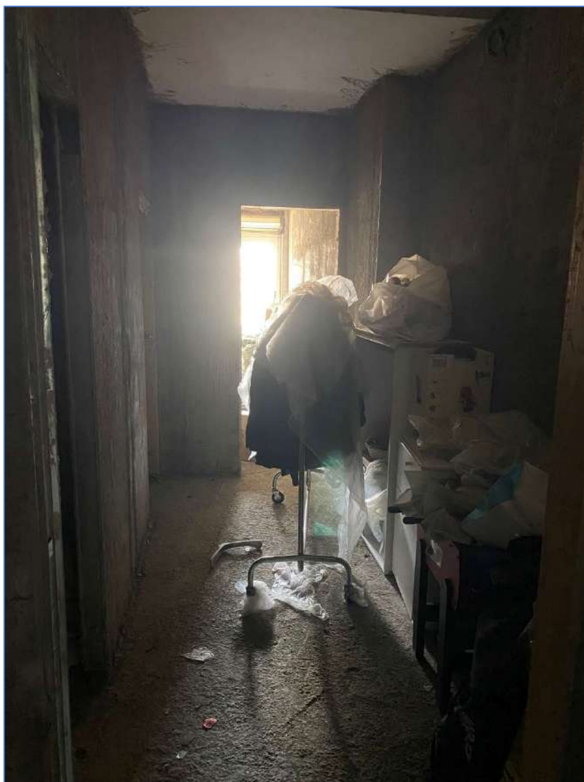
Foto 16. Porzione di immobile non rifinita.
