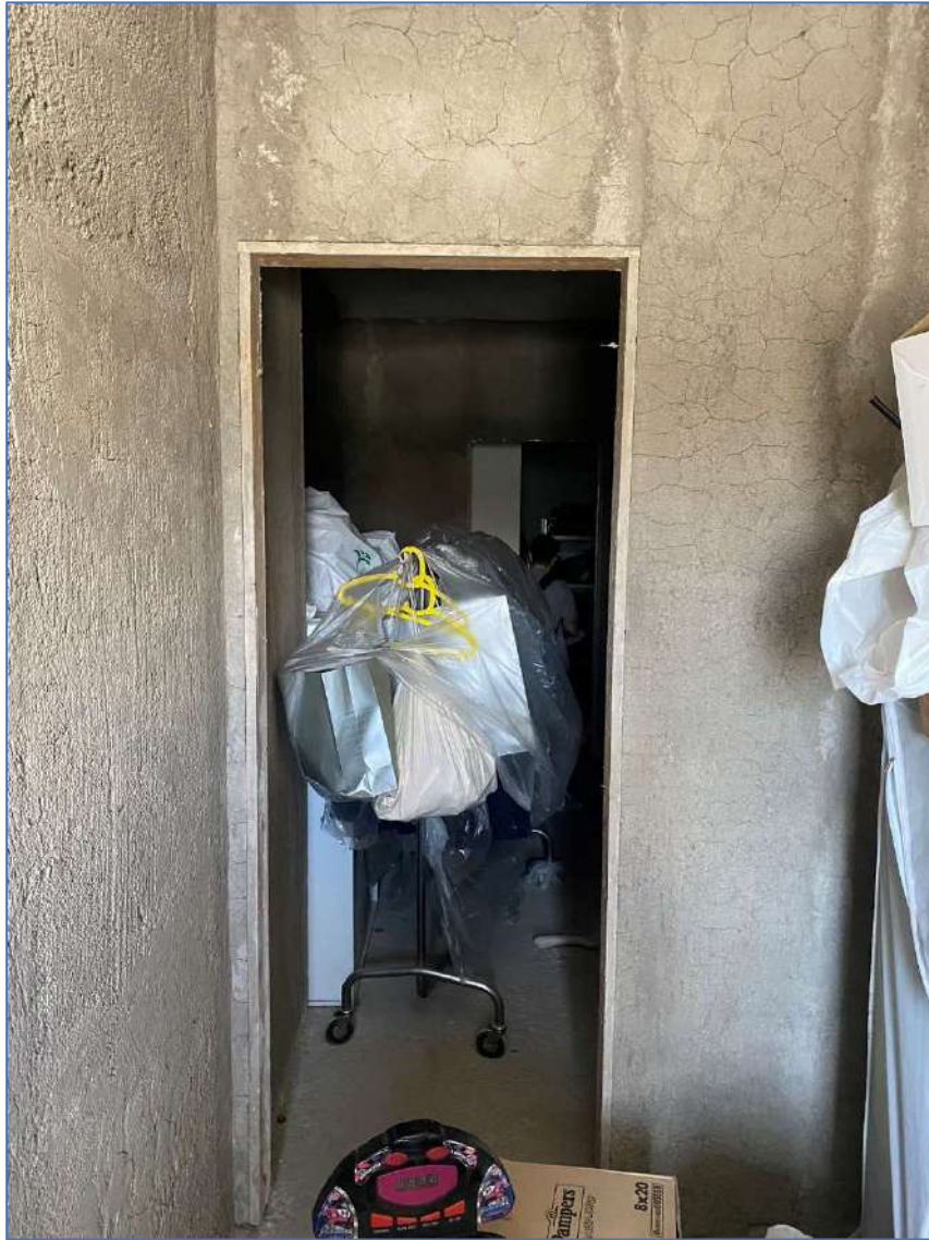
Foto 20. Porzione di immobile non rifinita.
