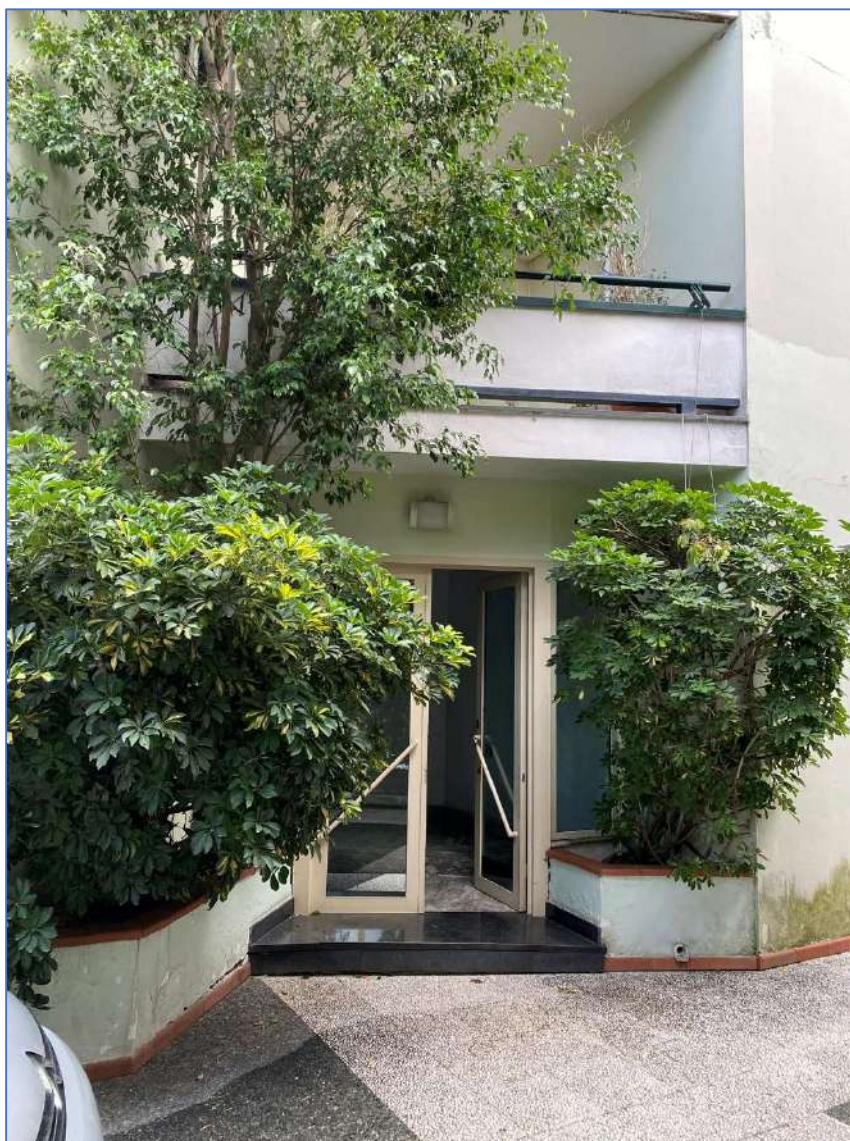
Foto 9. Ingresso scala fabbricato.
