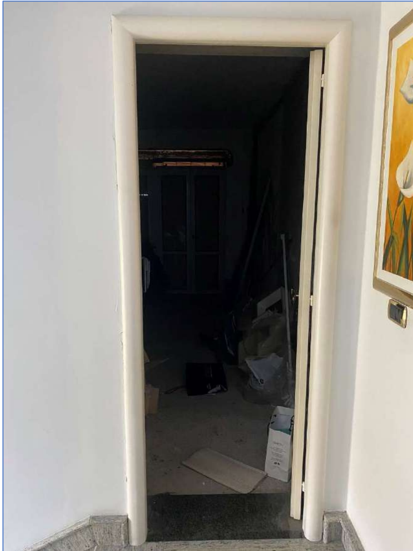
Foto 13. Ingresso porzione di immobile non rifinita.
