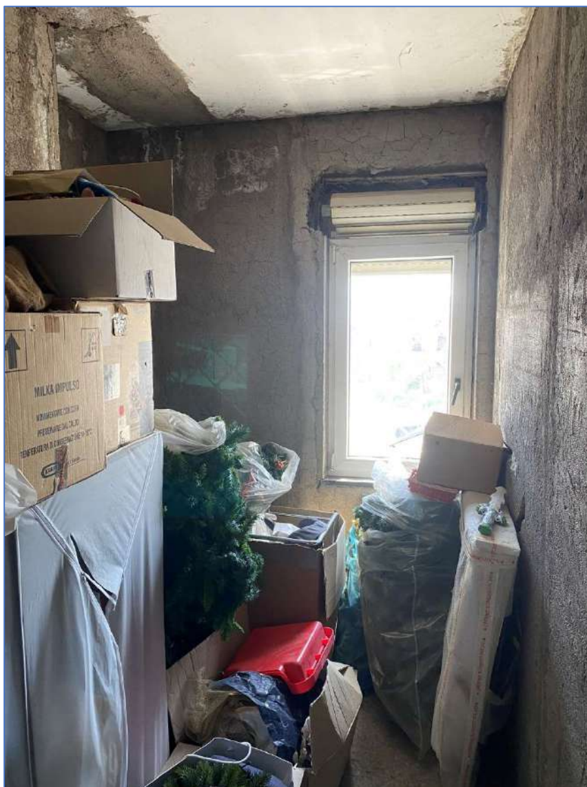
Foto 19. Porzione di immobile non rifinita.
