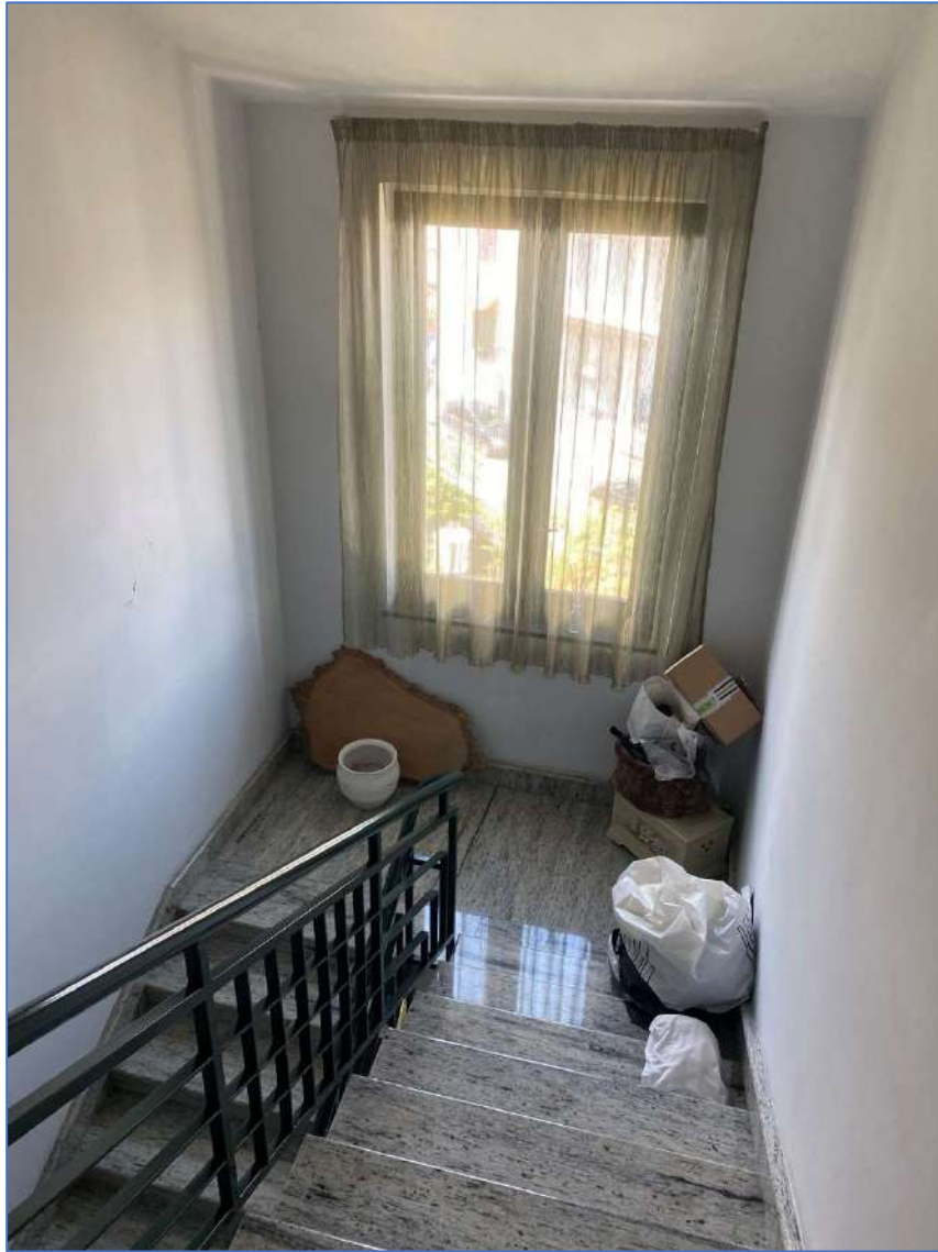
Foto 11. Vano scala fabbricato.
