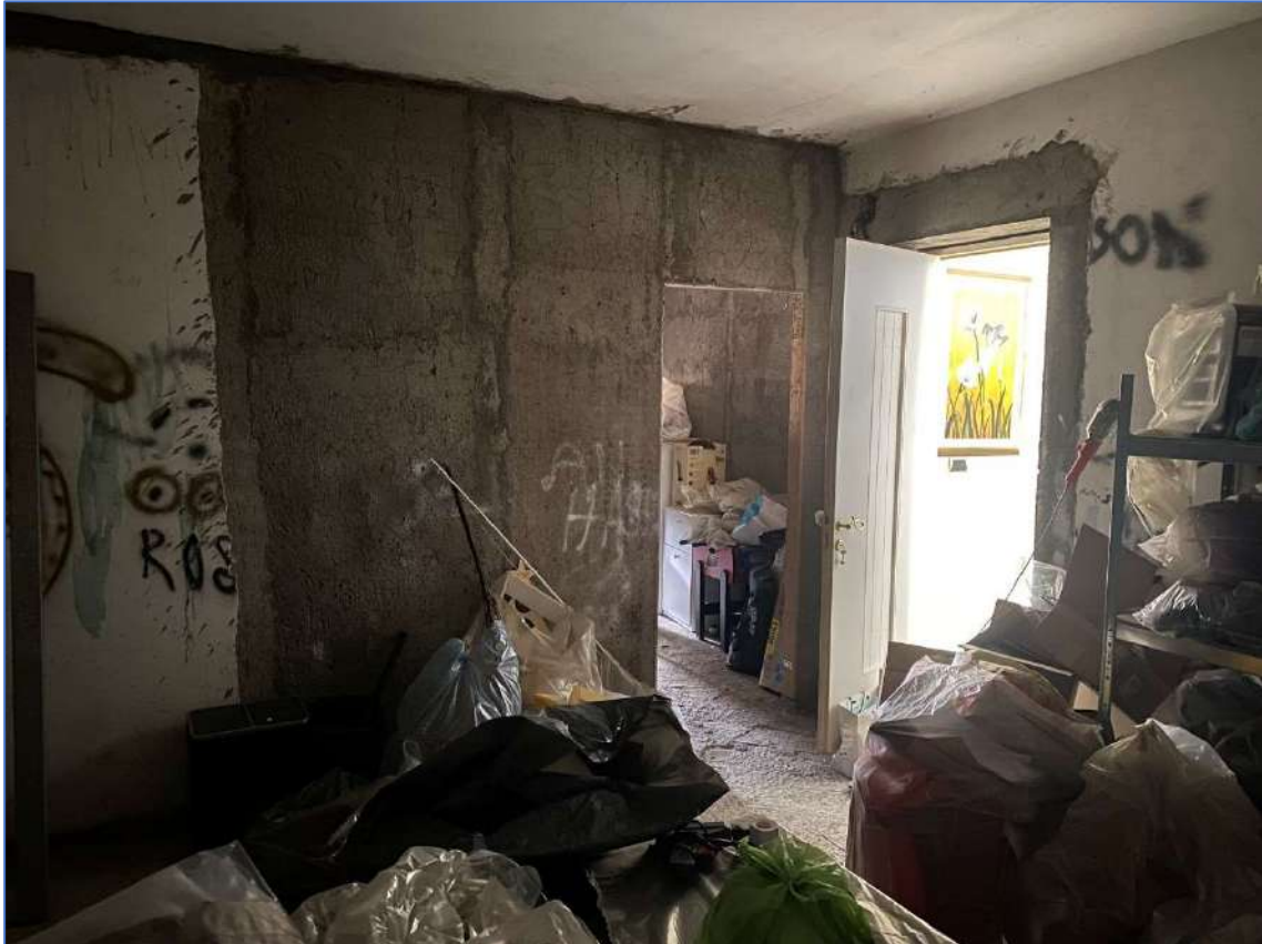
Foto 15. Porzione di immobile non rifinita.
