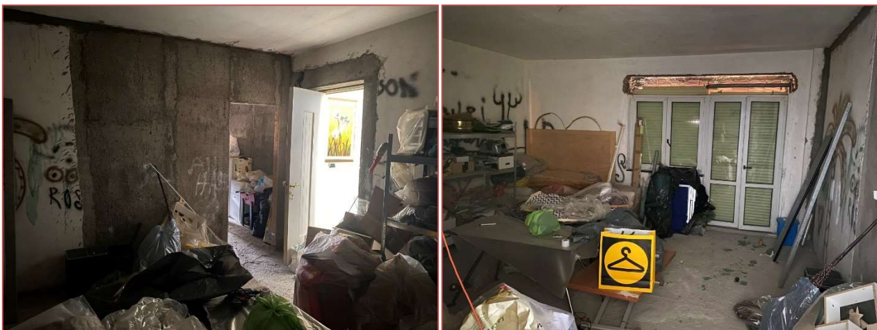
FIGURA 5. IMMOBILE SUBALTERNO 4. PORZIONE NON RIFINITA.
