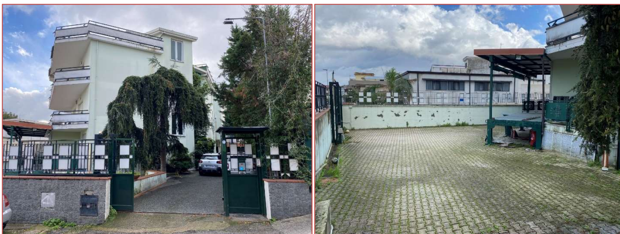
FIGURA 7. INGRESSO DA VIA LUCCI E CORTE ESTERNA.
