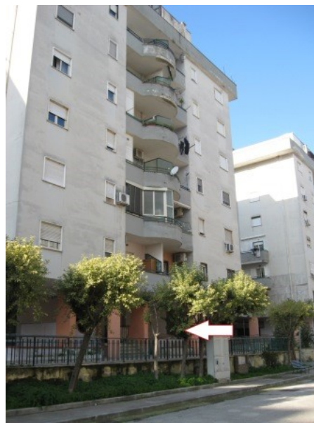
Figura 9 facciata est del Fabbricato A3 del lotto A del parco Aurora in Melito di Napoli
