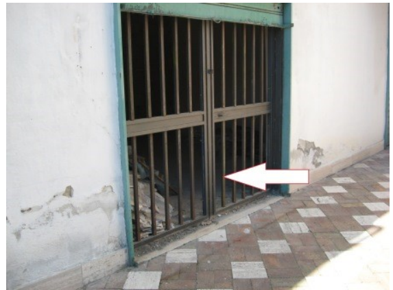
Figura 13 accesso al locale commerciale 2 indipendente
