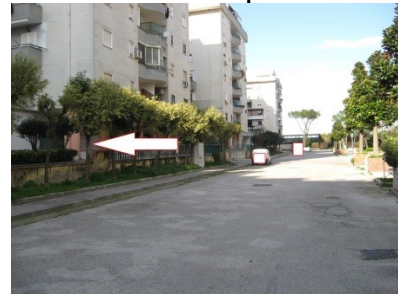
Figura 6 area condominiale ed accesso alla scala A3 del lotto A del Parco Aurora in Melito di Napoli
