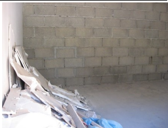
Figura 25 interno del locale commerciale locale 2
