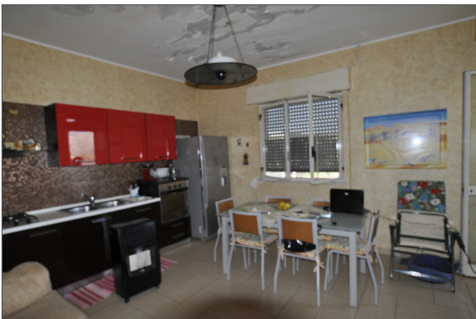
FOTO 6 - Vista interna - Cucina -
