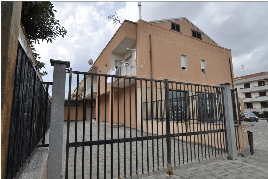
FOTO 2 - Vista esterna Fabbricato -
