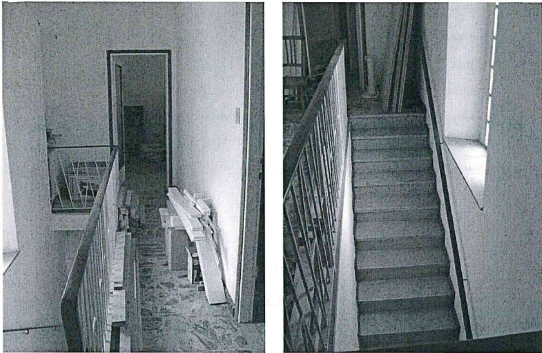
Vista interna abitazione – particolare vano scala e disimpegno P1
