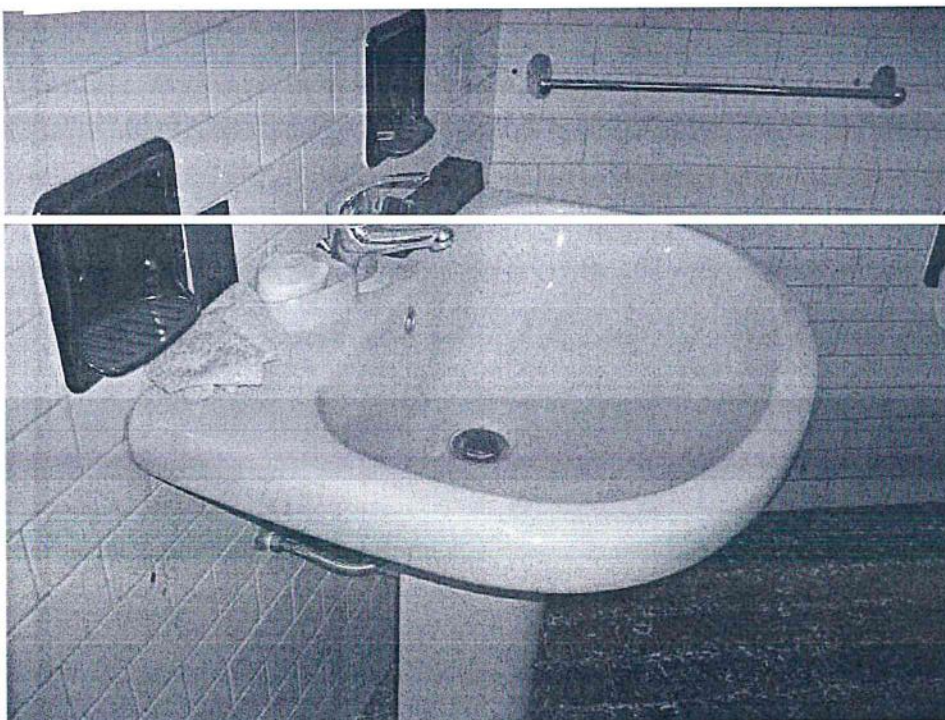
Vista interna abitazione P1 – particolare sanitari
