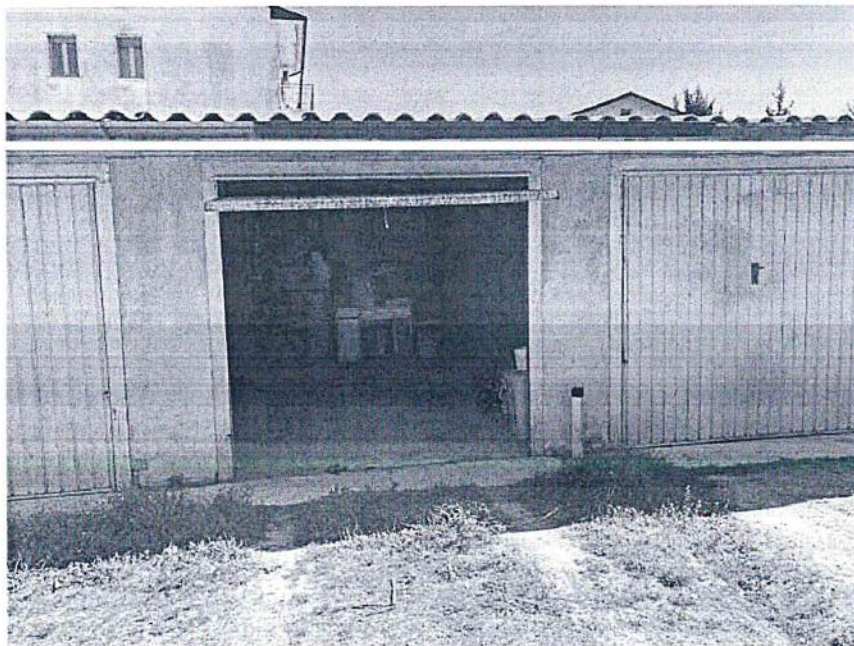
Vista esterna autorimessa
