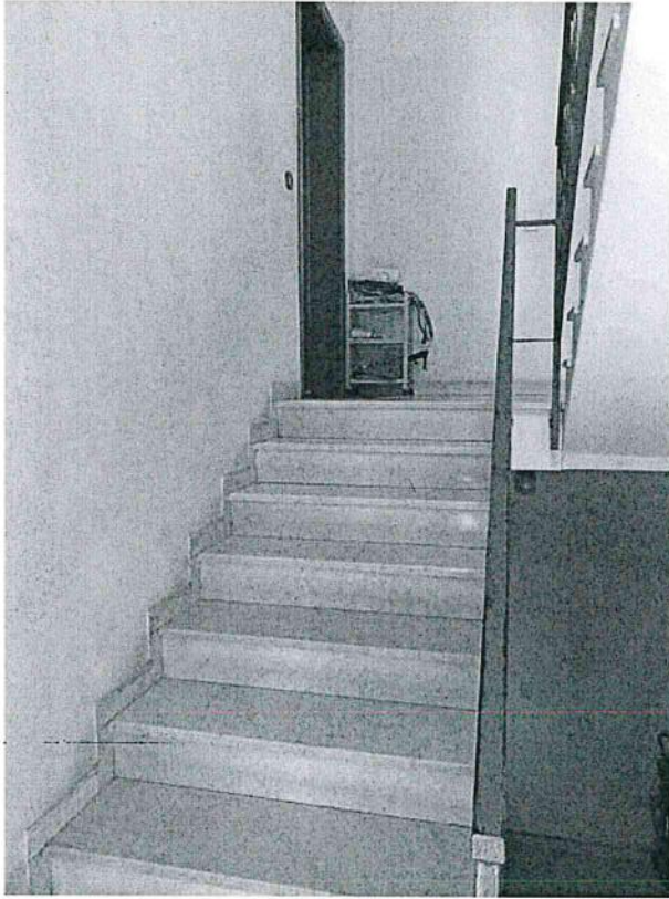
particolare vista interna vano scala condominiale
