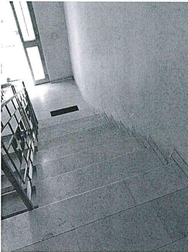
particolare vista interna vano scala condominiale
