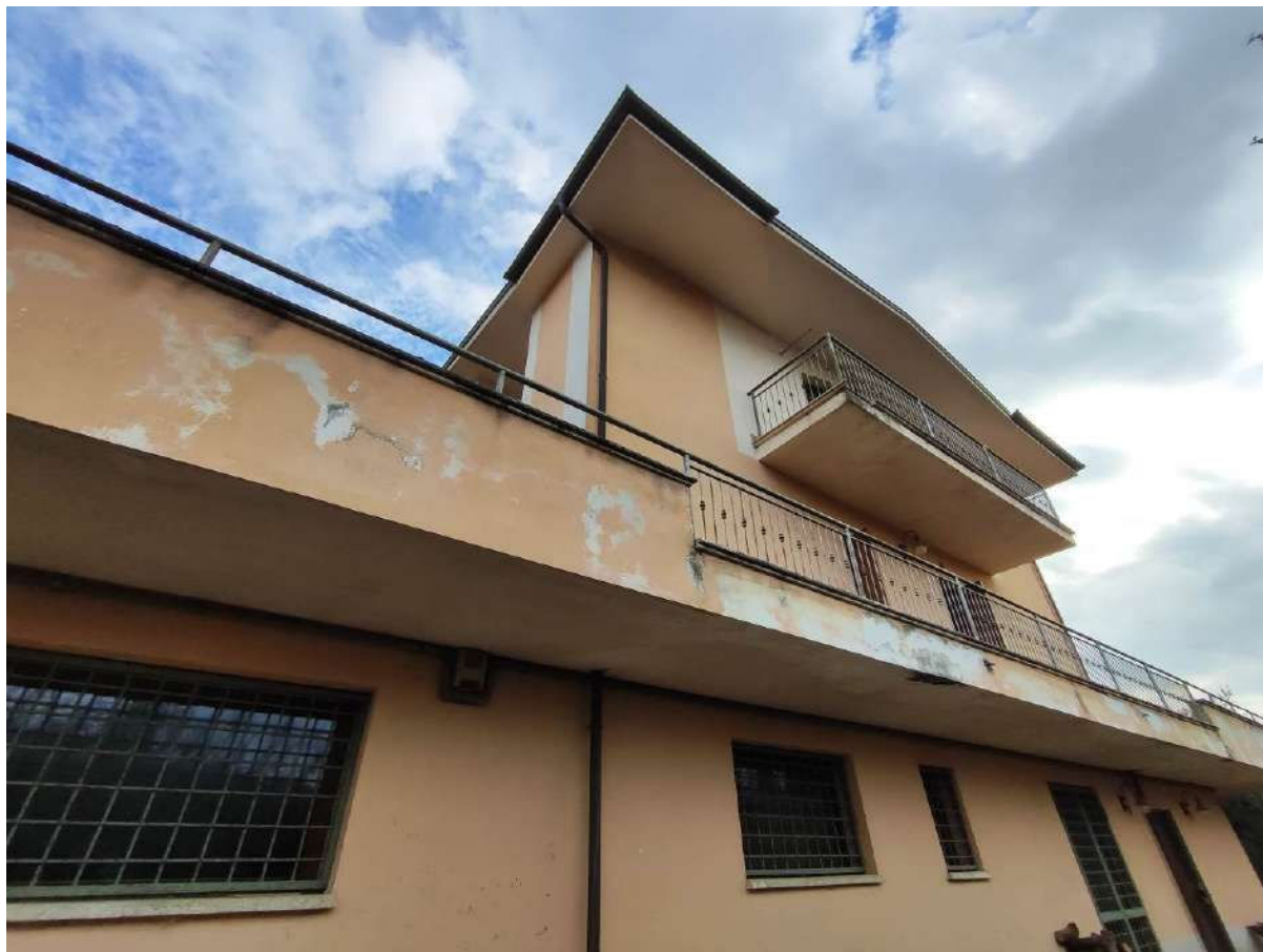
Foto 5 - Veduta laterale del fabbricato
