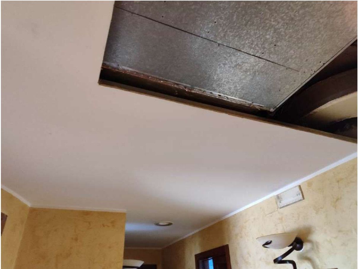
Foto 41 - Interni piano primo, disimpegno
