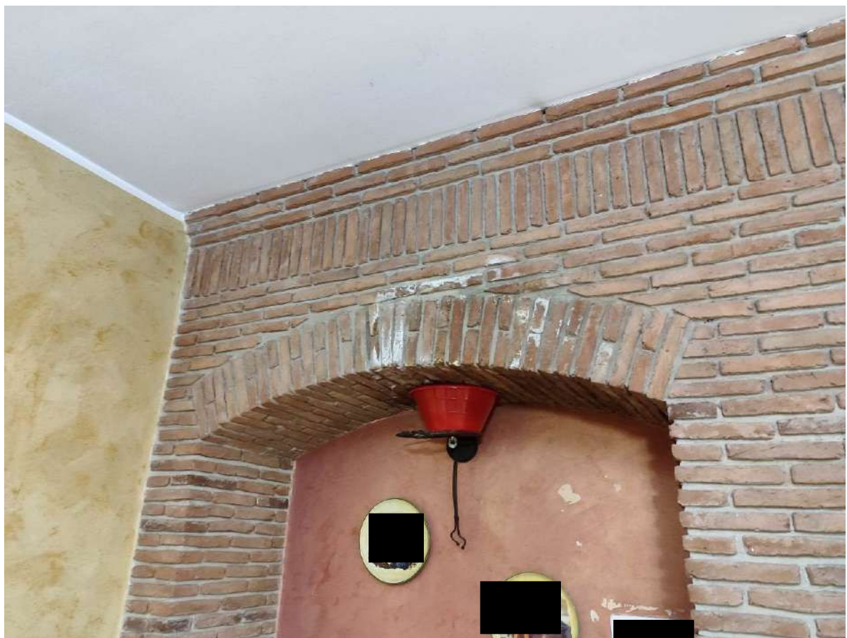
Foto 20 - Interni piano terra, cucina
