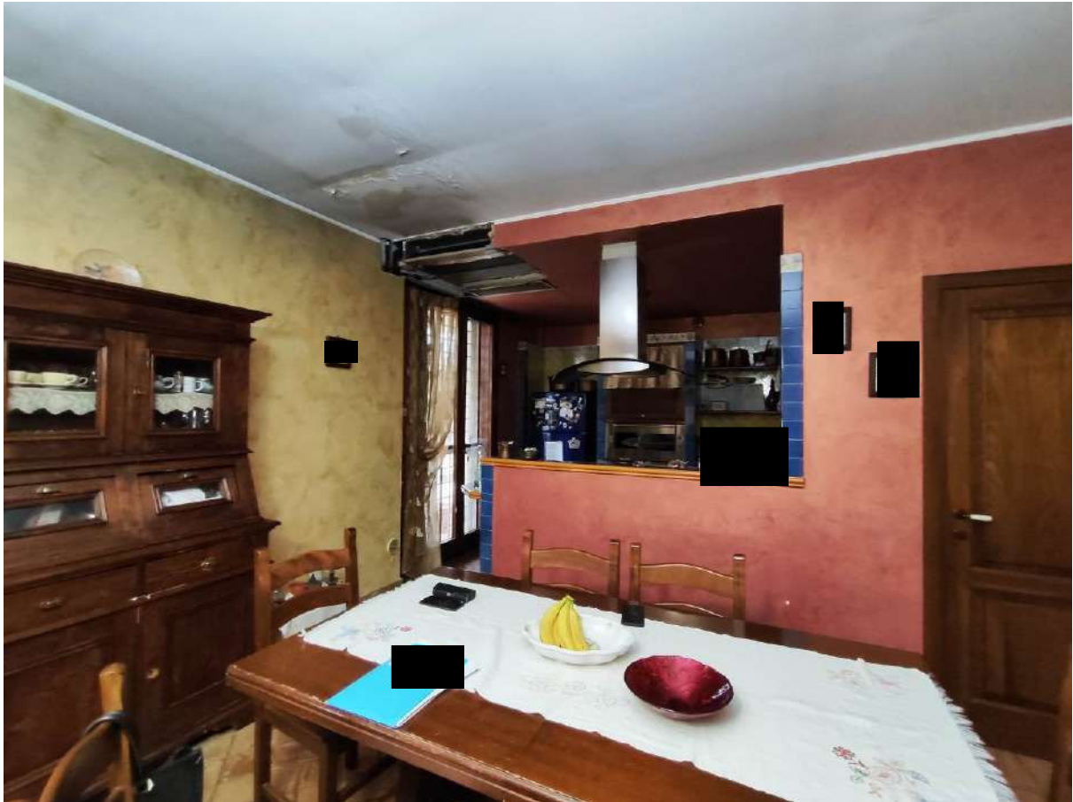
Foto 21 - Interni piano terra, cucina
