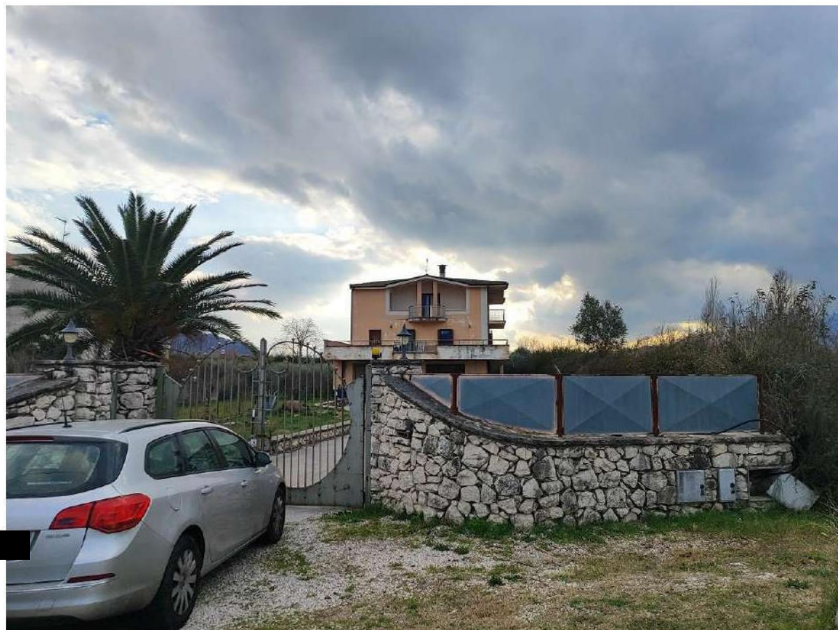
Foto 1 –Veduta da strada pubblica
