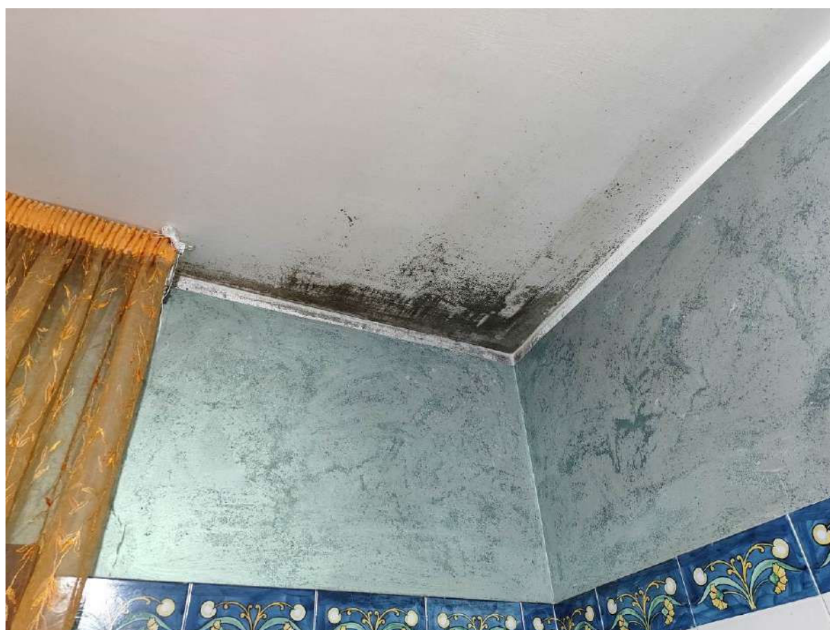
Foto 50 - Interni piano primo, wc
