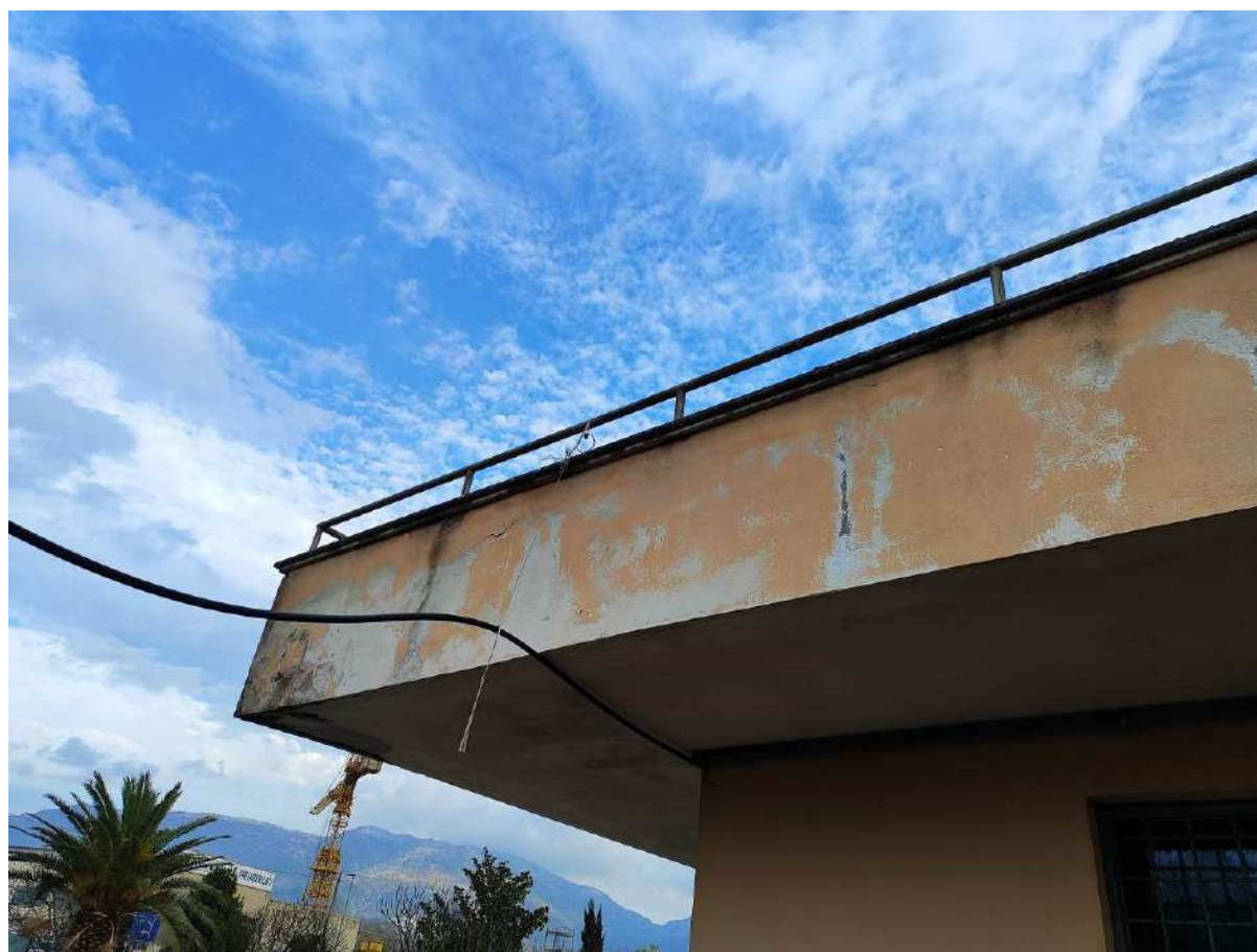
Foto 6 - Dettaglio prospetto laterale
