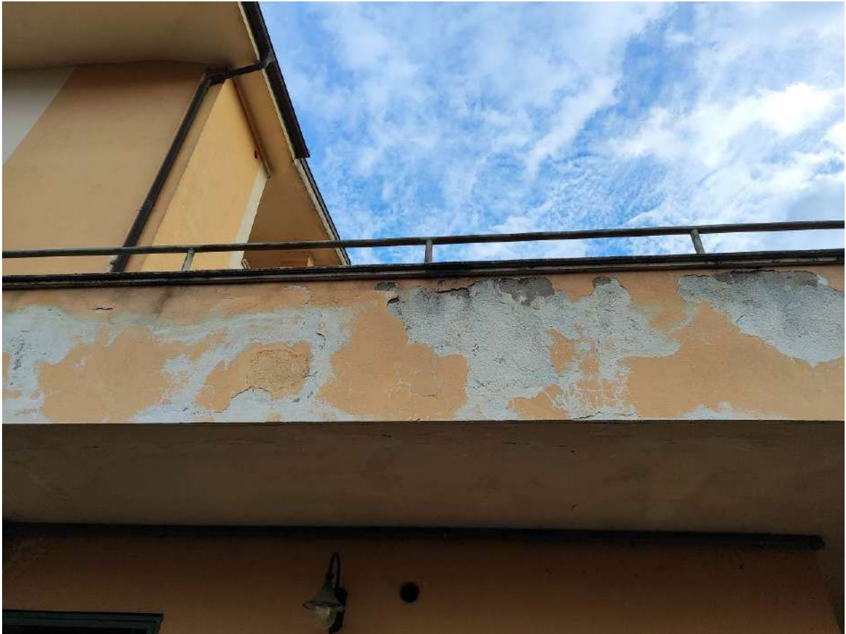
Foto 9 - Dettaglio prospetto laterale
