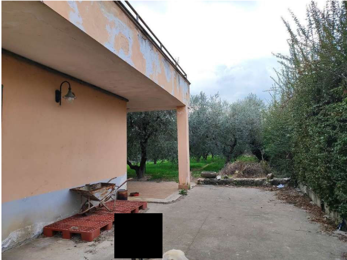
Foto 7 - Dettaglio prospetto laterale
