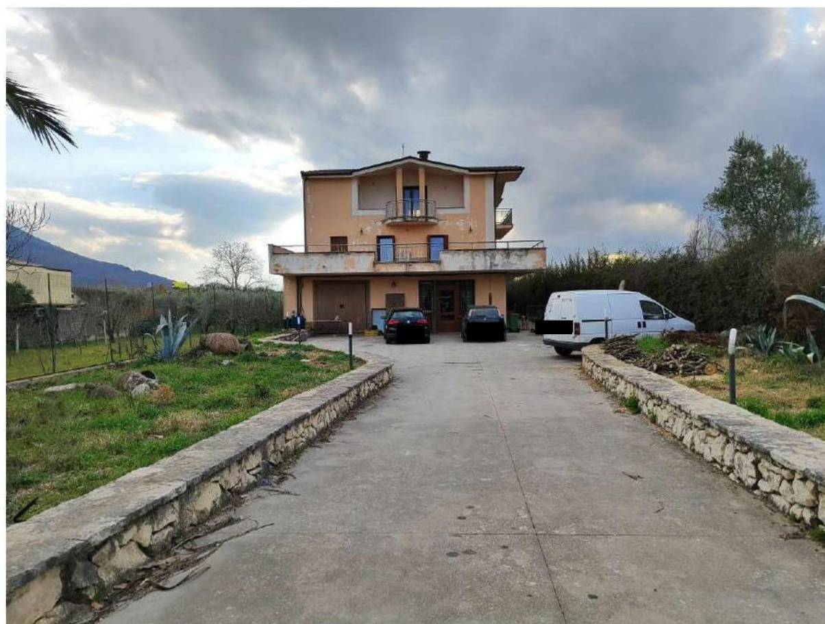
Foto 2 –Veduta da area esterna
