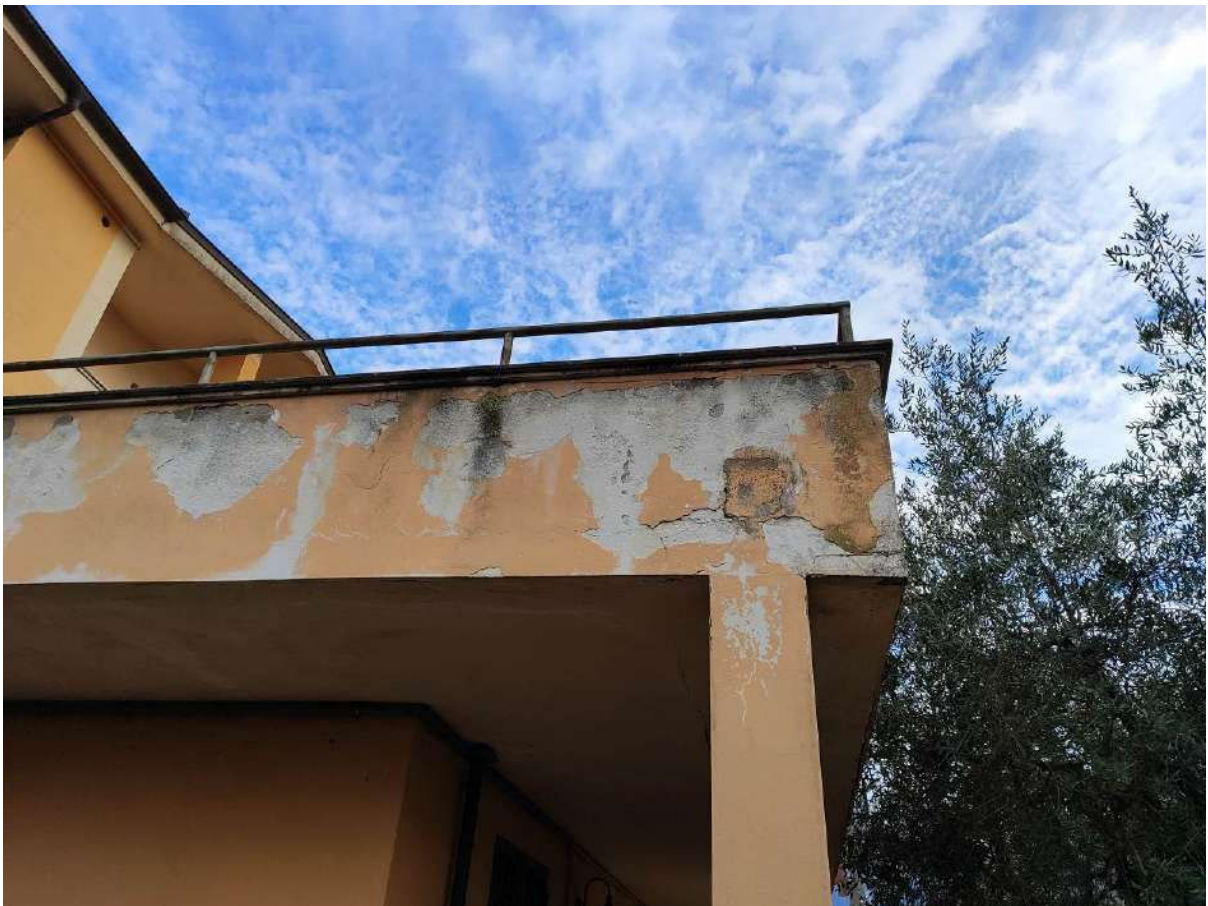
Foto 10 - Dettaglio prospetto laterale
