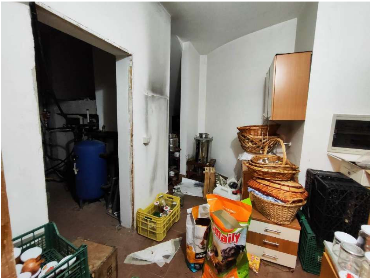
Foto 38 - Interni piano terra, cantina
