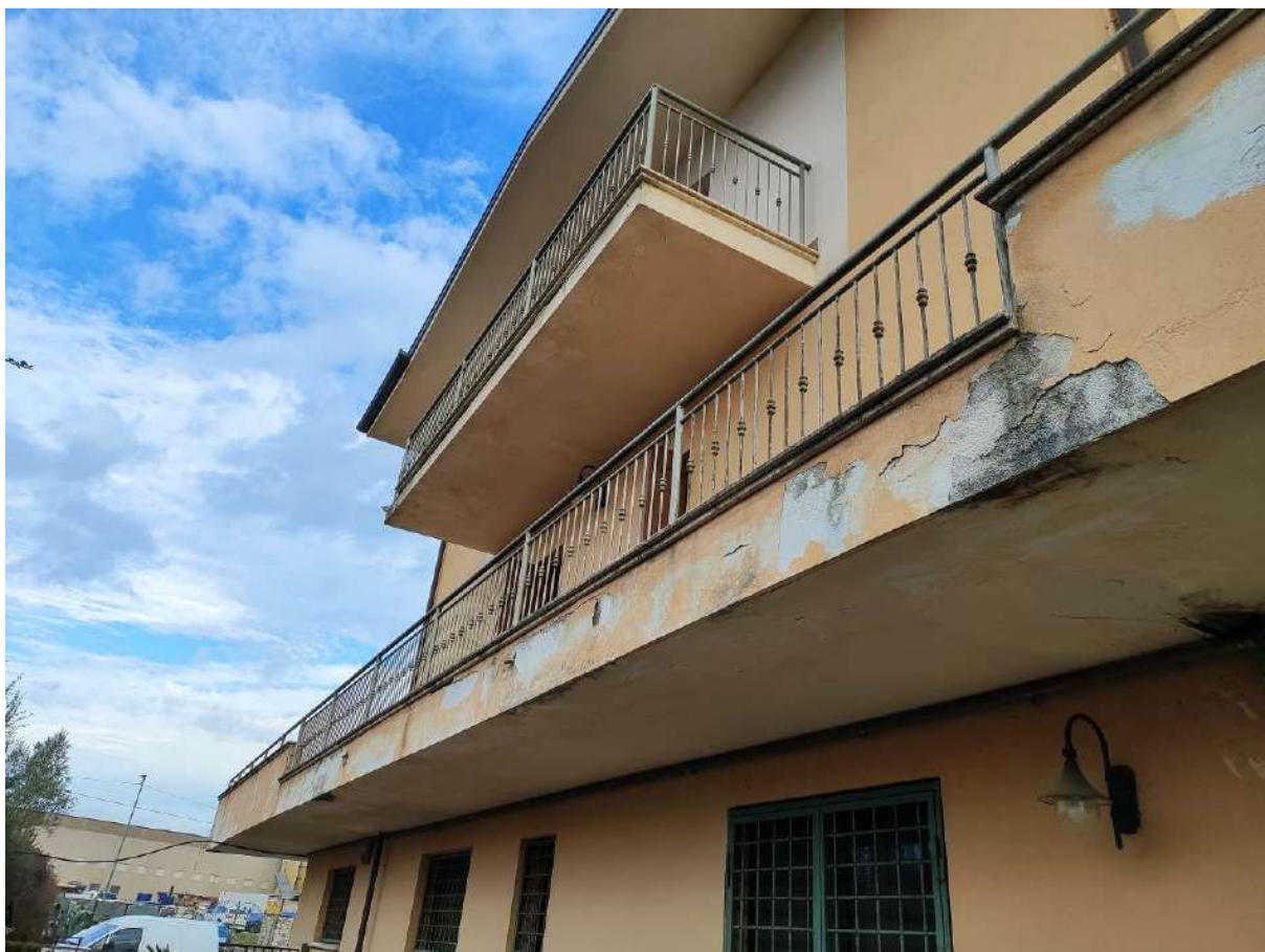
Foto 8 - Dettaglio prospetto laterale
