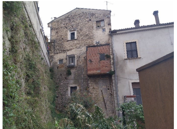
Foto 5 : esterno, Via Zambecario
