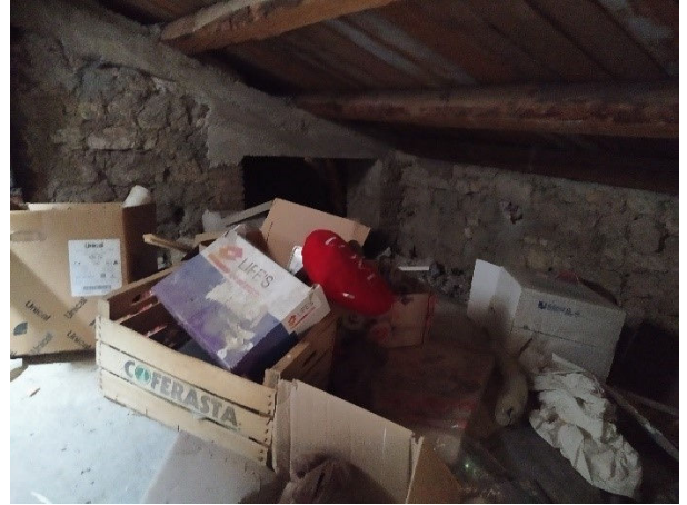
Foto 46: interno, sottotetto livello P1
