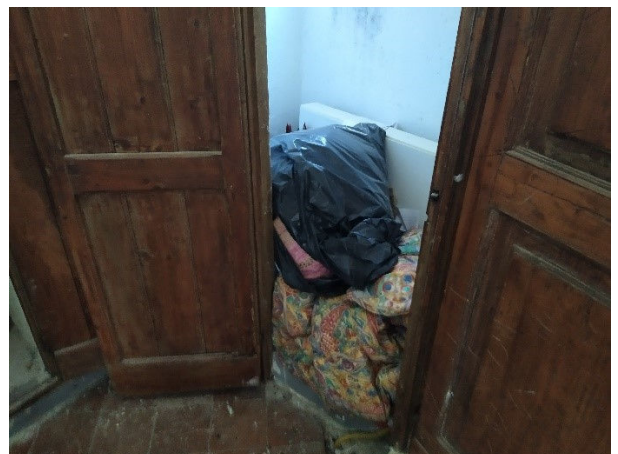
Foto 48: interno, ripostiglio livello P1
