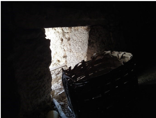
Foto 44: interno, sottotetto livello P1
