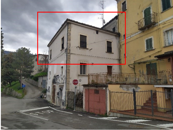
Foto 1 : esterno, Via Zambecario
