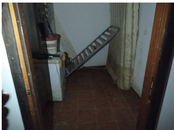
Foto 15: interno, ripostiglio livello S1
