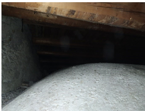
Foto 65: interno, sottotetto livello P2
