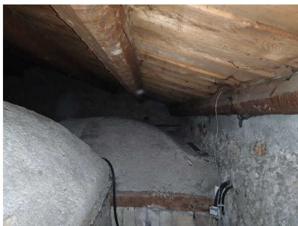
Foto 66: interno, sottotetto livello P2
