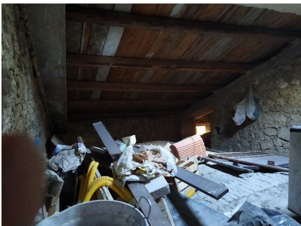
Foto 45: interno, sottotetto livello P1
