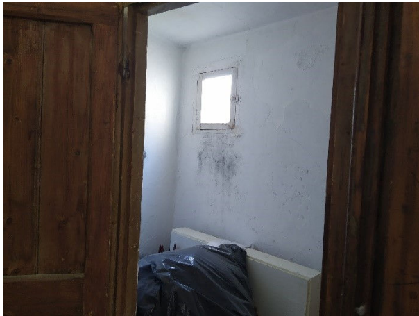
Foto 49: interno, ripostiglio livello P1
