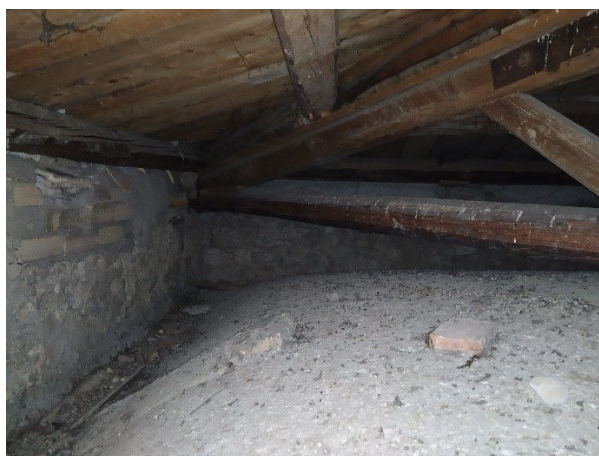
Foto 42: interno, sottotetto livello P1
