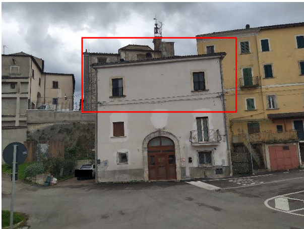
Foto 2 : esterno, Via Zambecario
