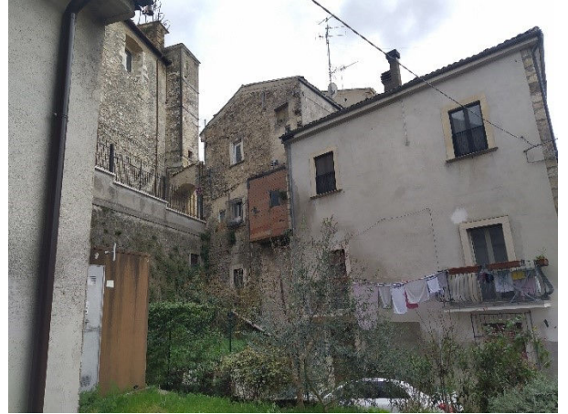
Foto 4 : esterno, Via Zambecario
