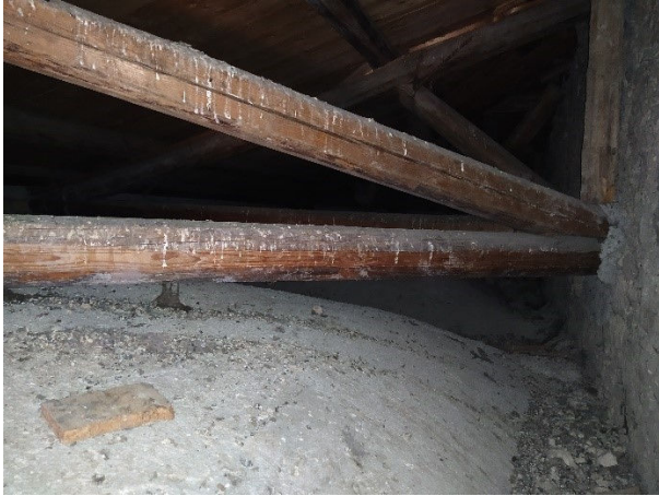
Foto 43: interno, sottotetto livello P1
