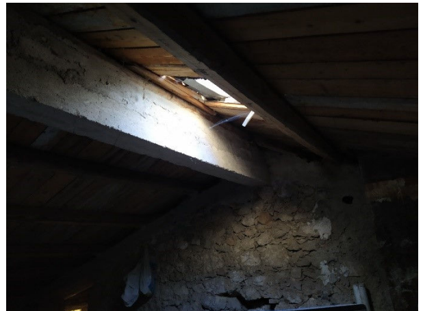
Foto 47: interno, sottotetto livello P1
