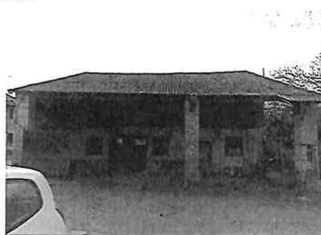
Figure 7- vista nord corpo B
