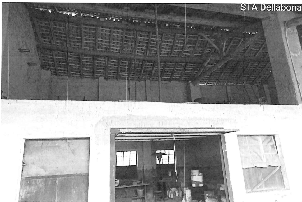
vista del fienile da terra con ex stalla
