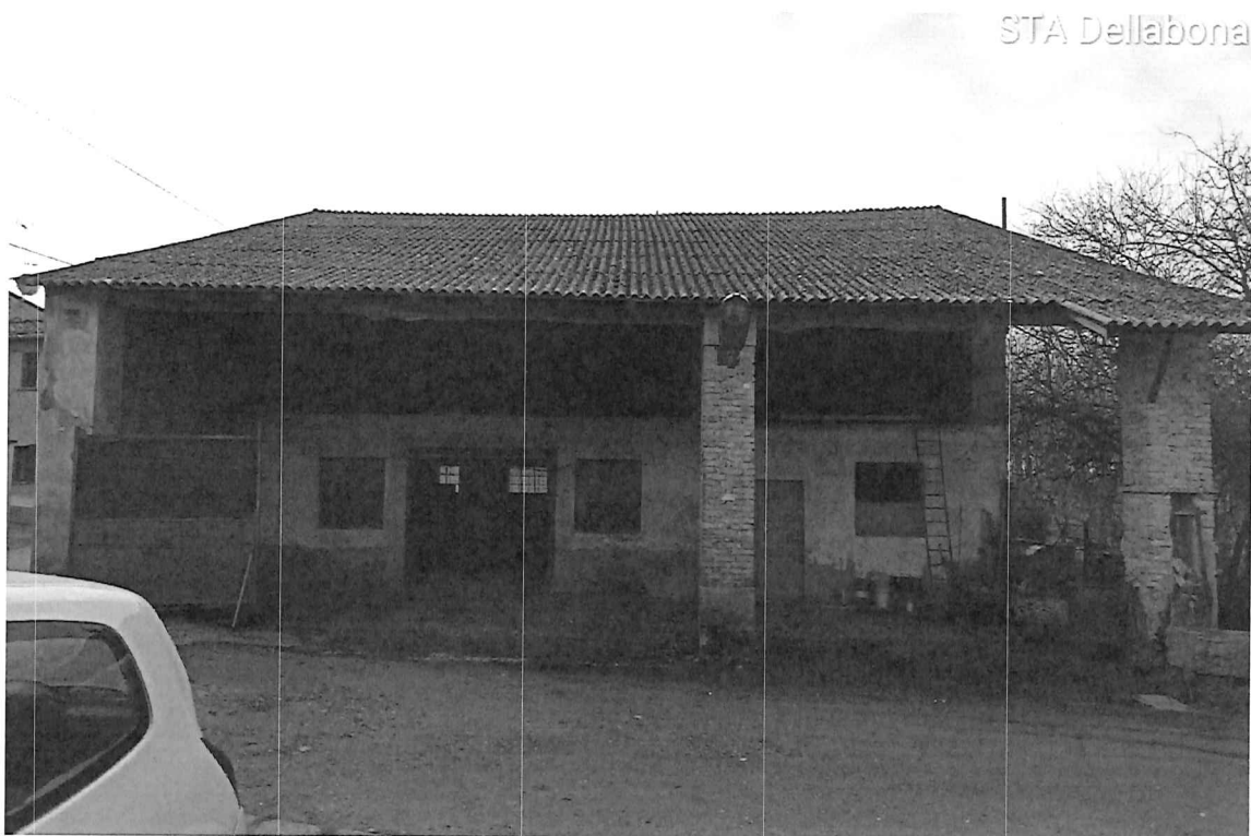
vista nor portico
