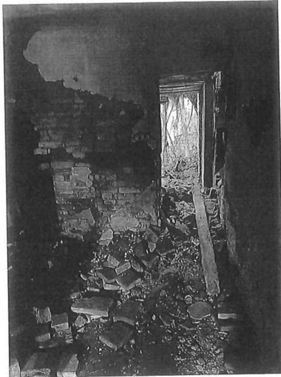
Particolare di un interno
