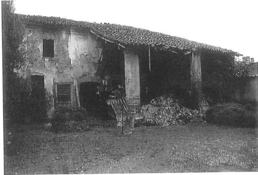
Altro particolare della facciata in lato sud
