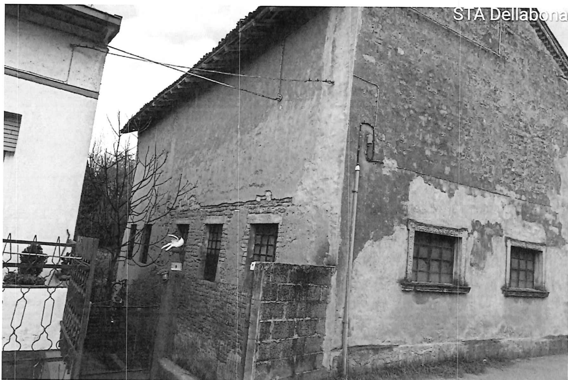
particolare di confine area comune
