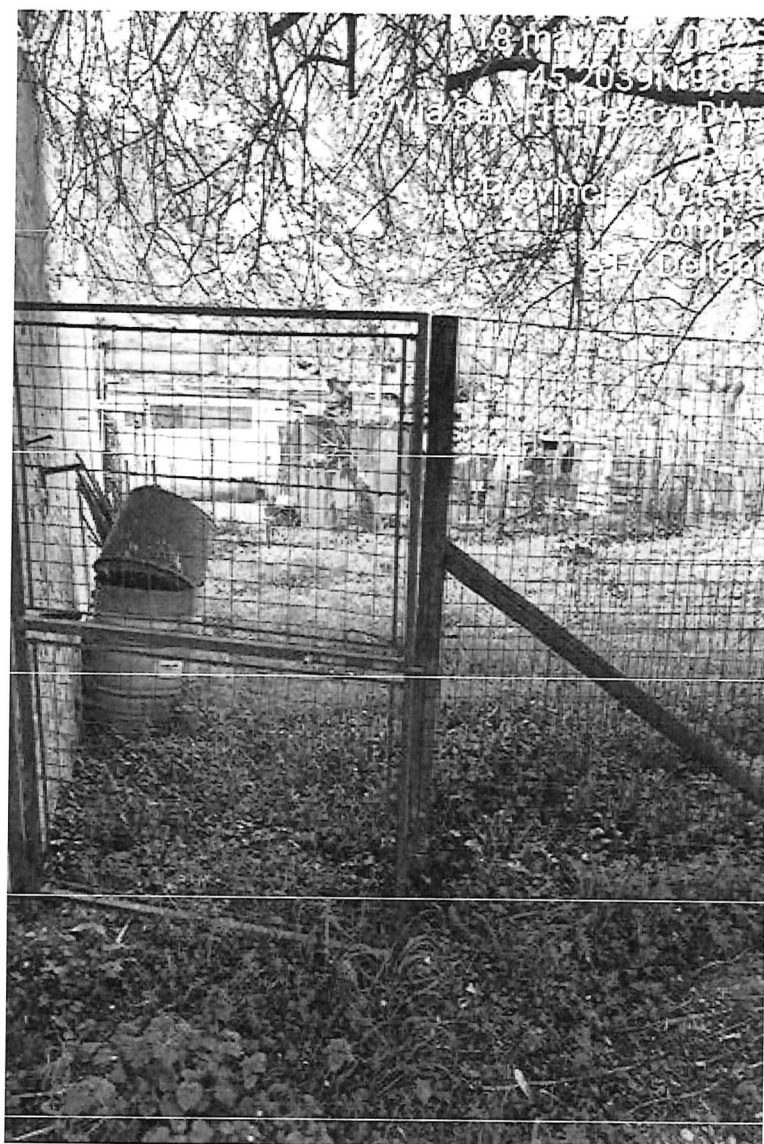
particolare area comune dove c'era il pollaio demolito
