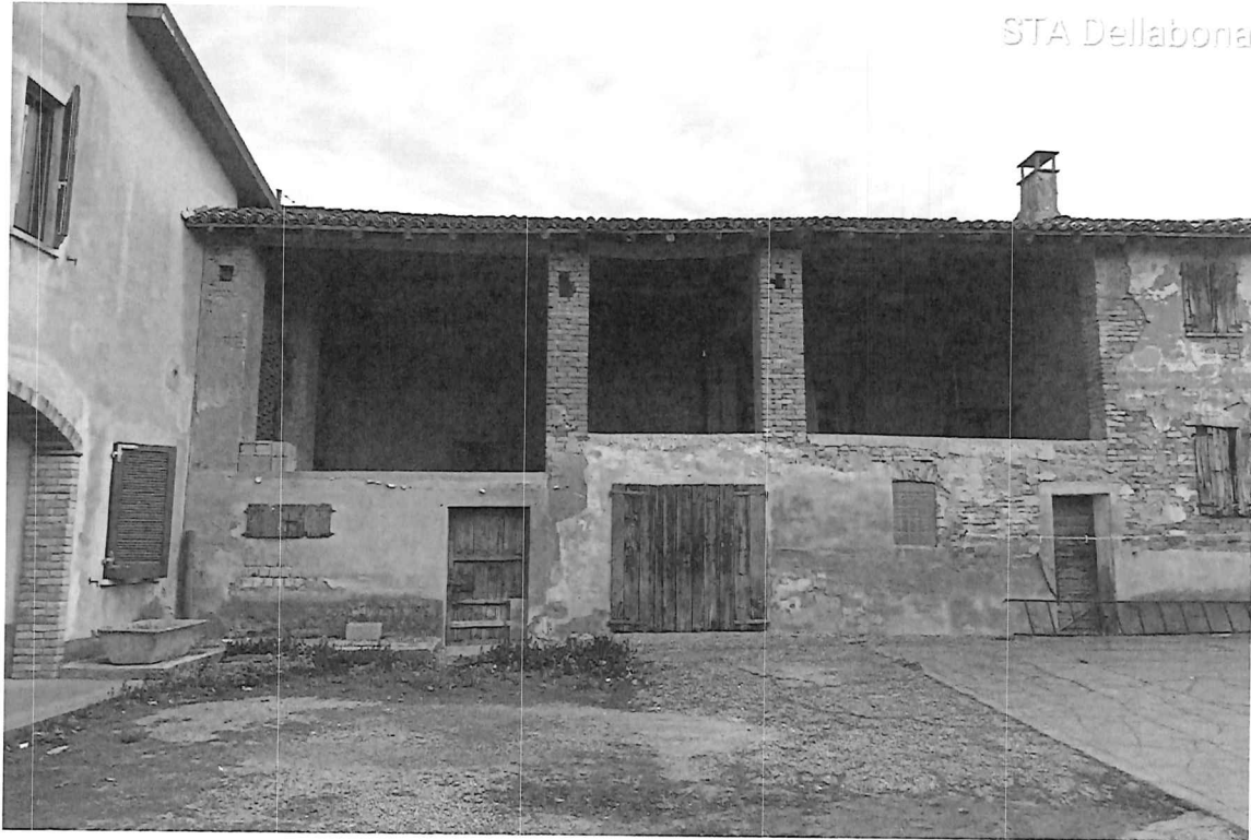
lato sud porzione magazzini
