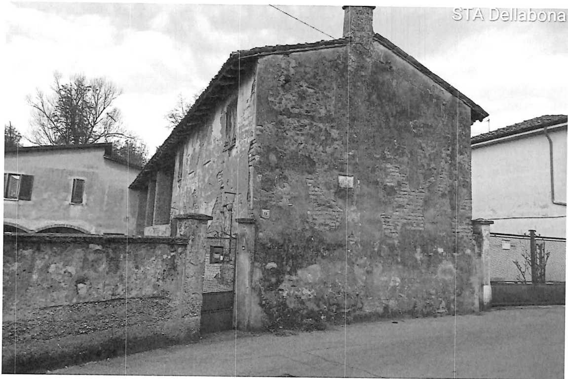
lato est fabbricato
