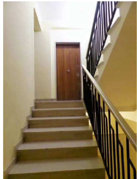
Foto n° 2.4. Palazzina "R": Vano scala
