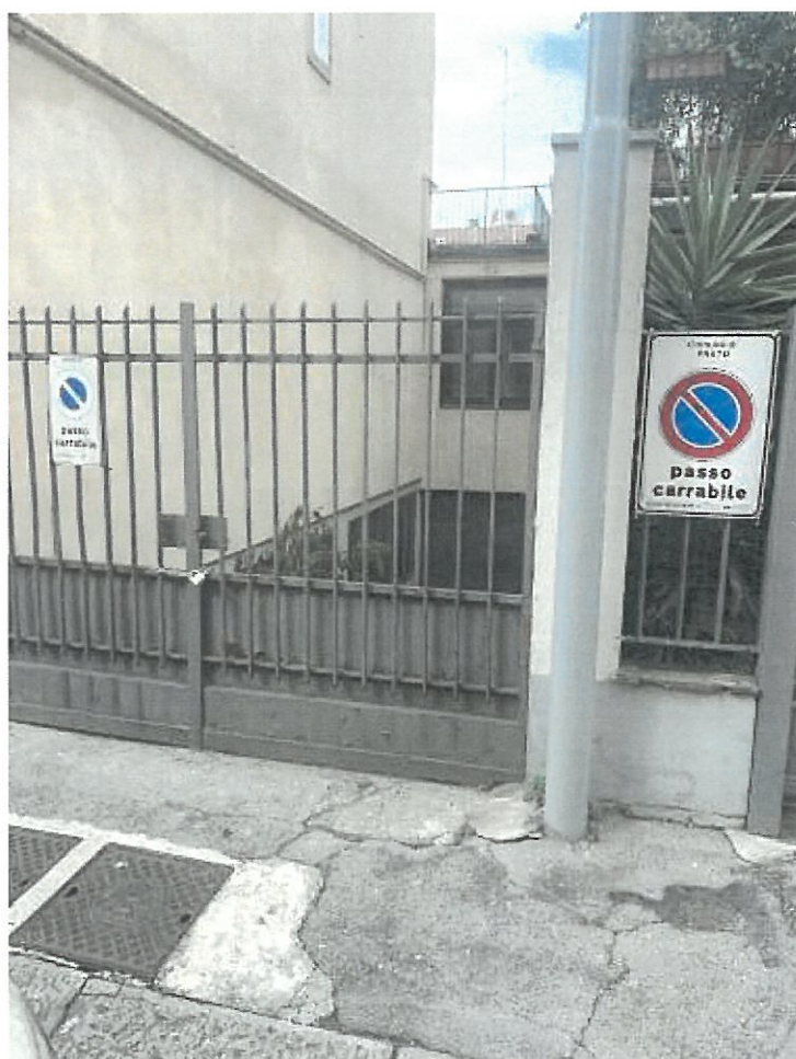
Foto rampa deposito piano interrato
