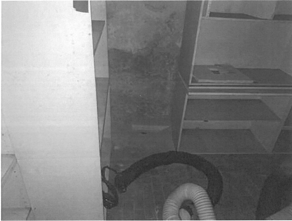
Foto deposito piano interrato
