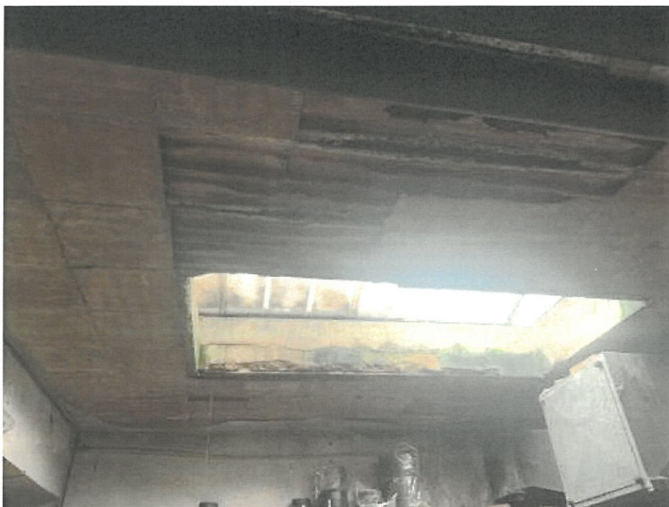
Foto deposito piano interrato
