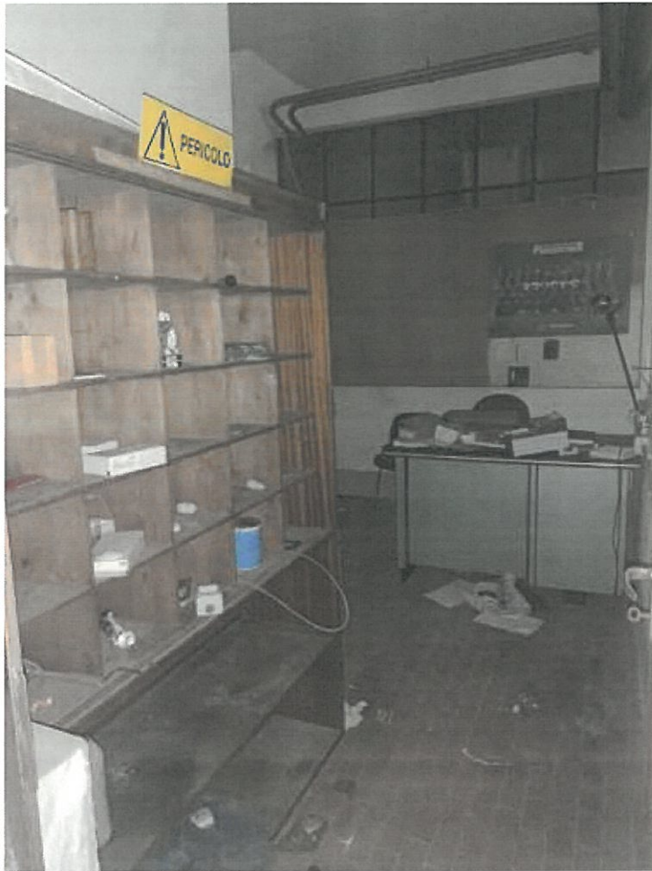
Foto deposito piano interrato
