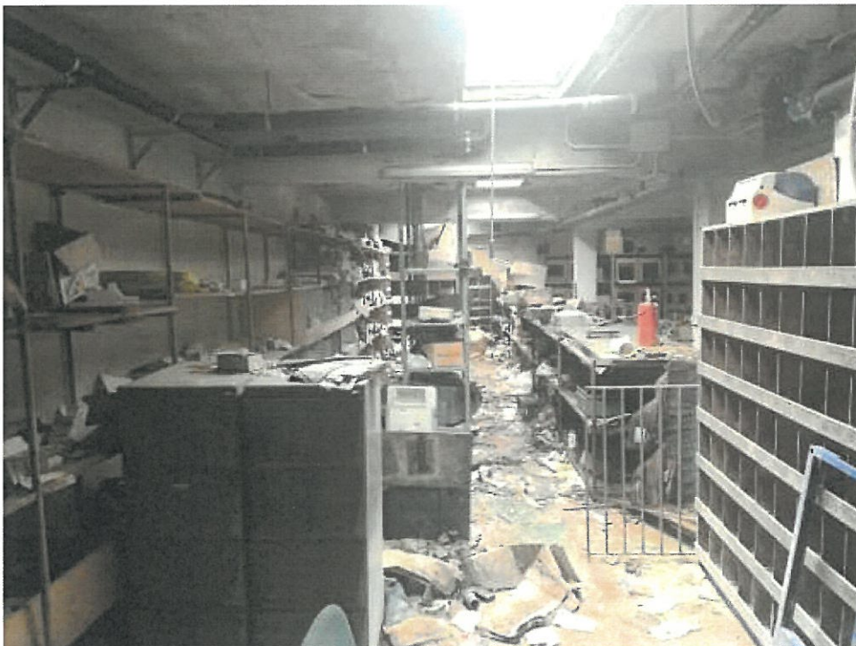
Foto deposito piano interrato
