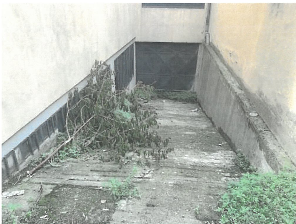
Foto rampa deposito piano interrato
