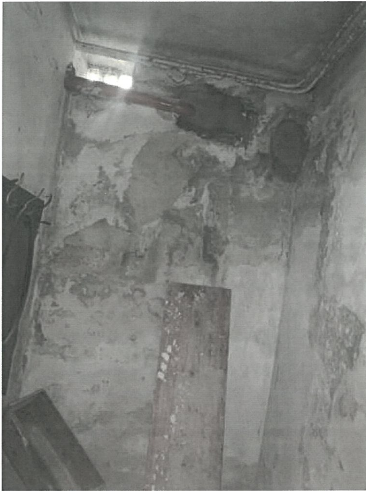
Foto deposito piano interrato
