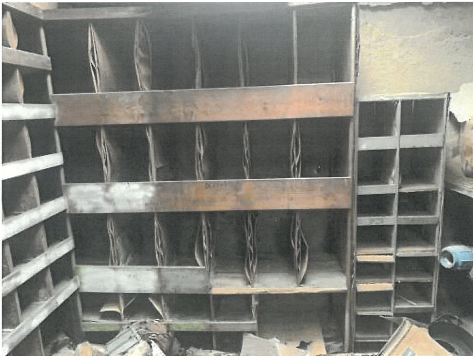
Foto deposito piano interrato
