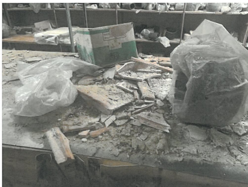
Foto deposito piano interrato
