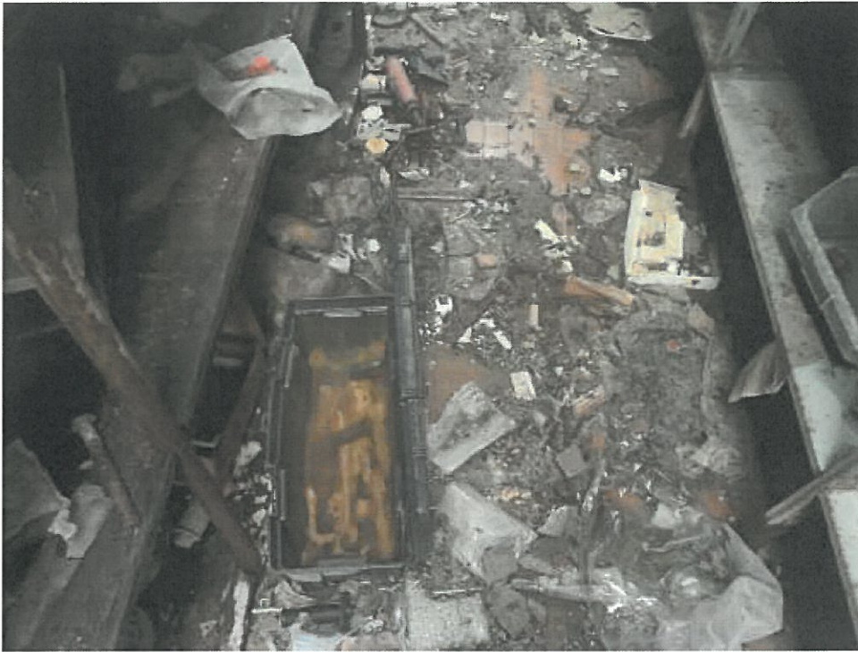
Foto deposito piano interrato
