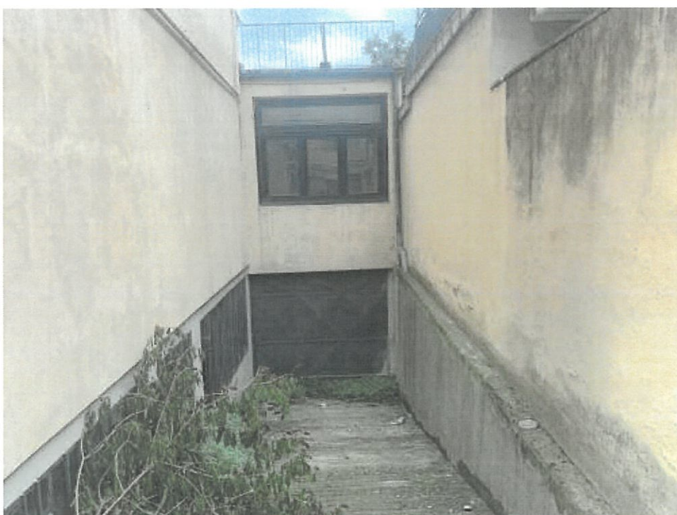
Foto rampa deposito piano interrato
