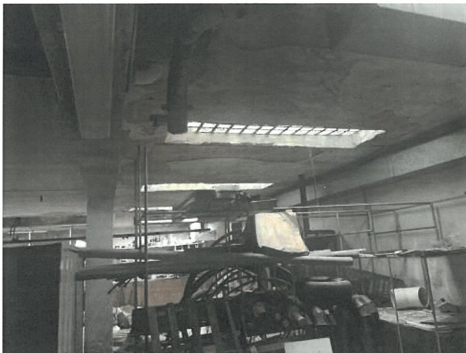
Foto deposito piano interrato
