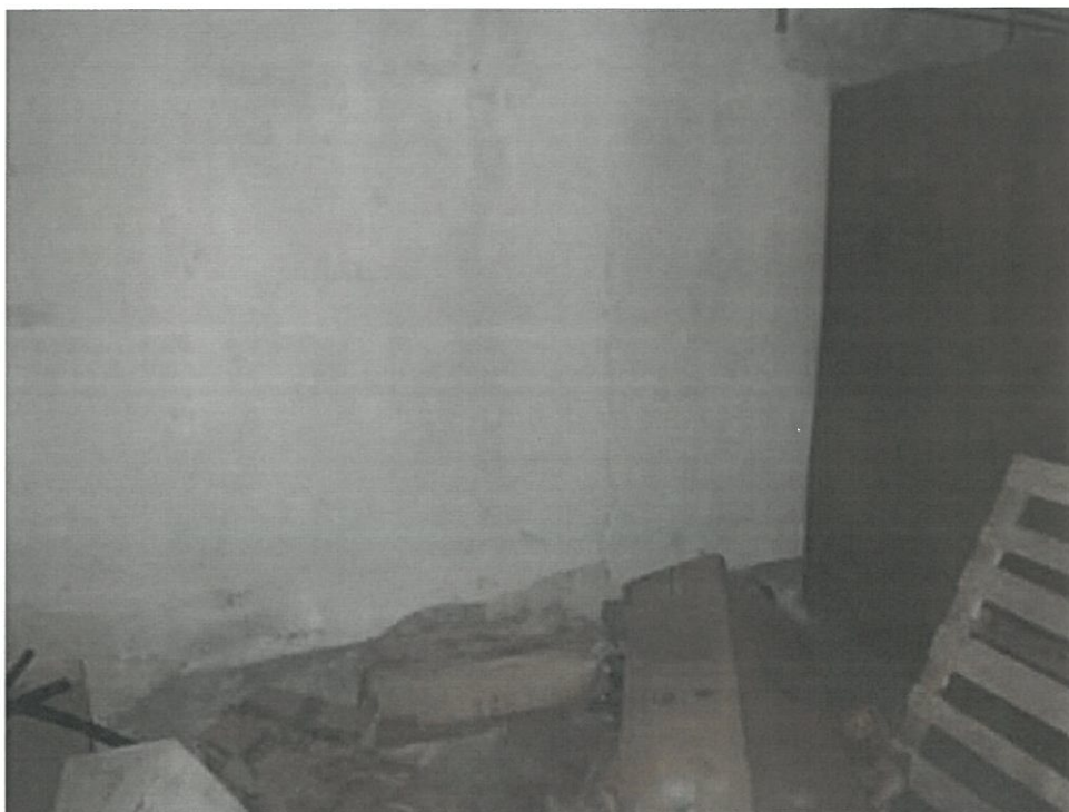
Foto deposito piano interrato
