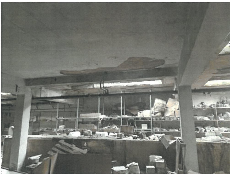
Foto deposito piano interrato
