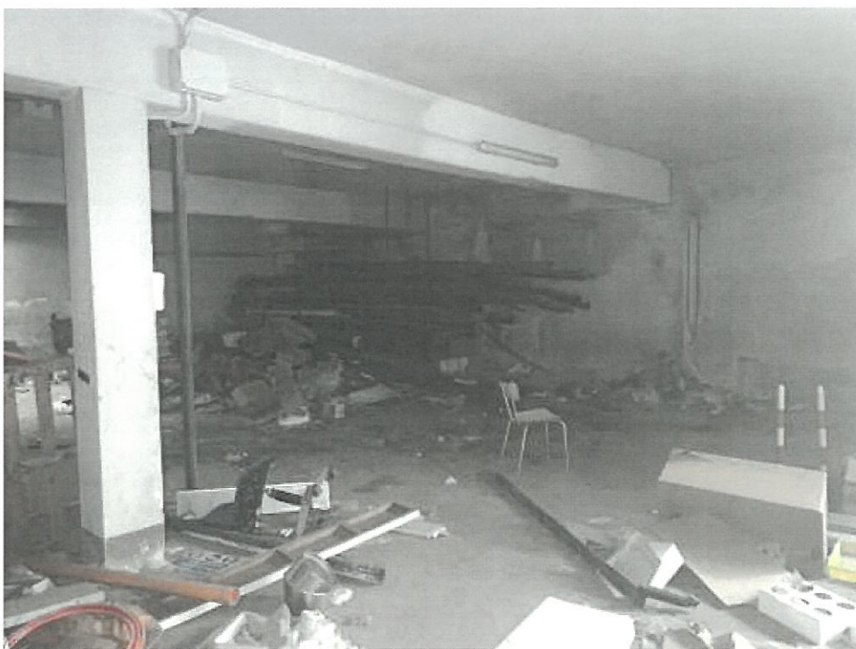
Foto deposito piano interrato
