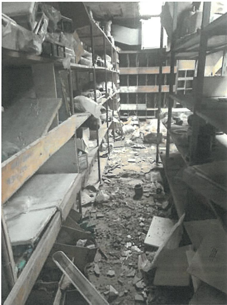
Foto deposito piano interrato
