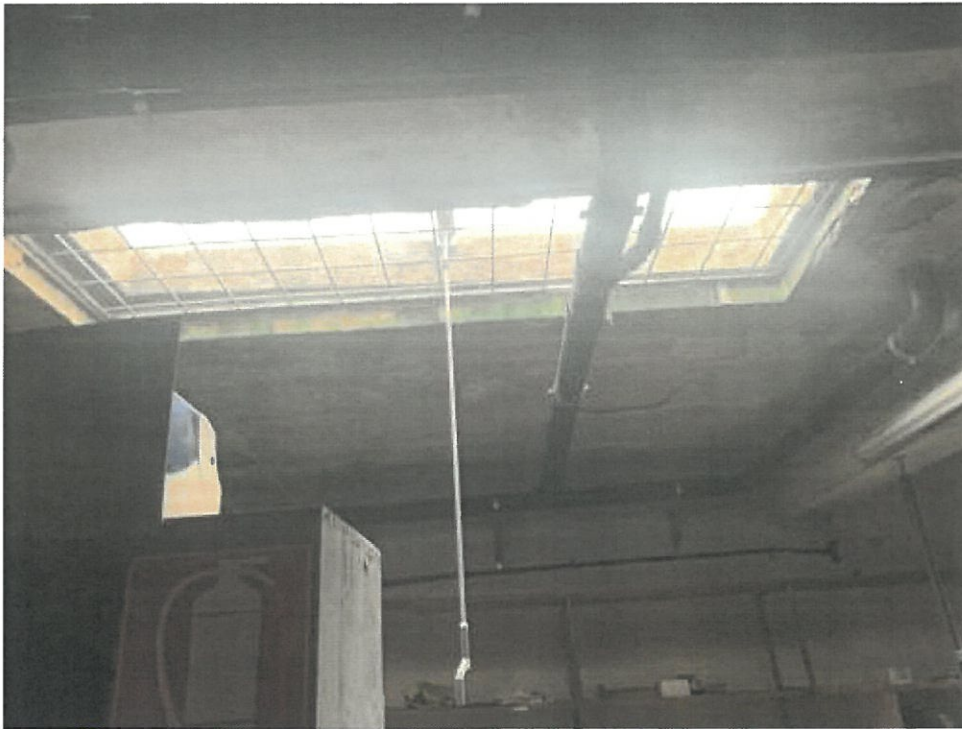
Foto deposito piano interrato
