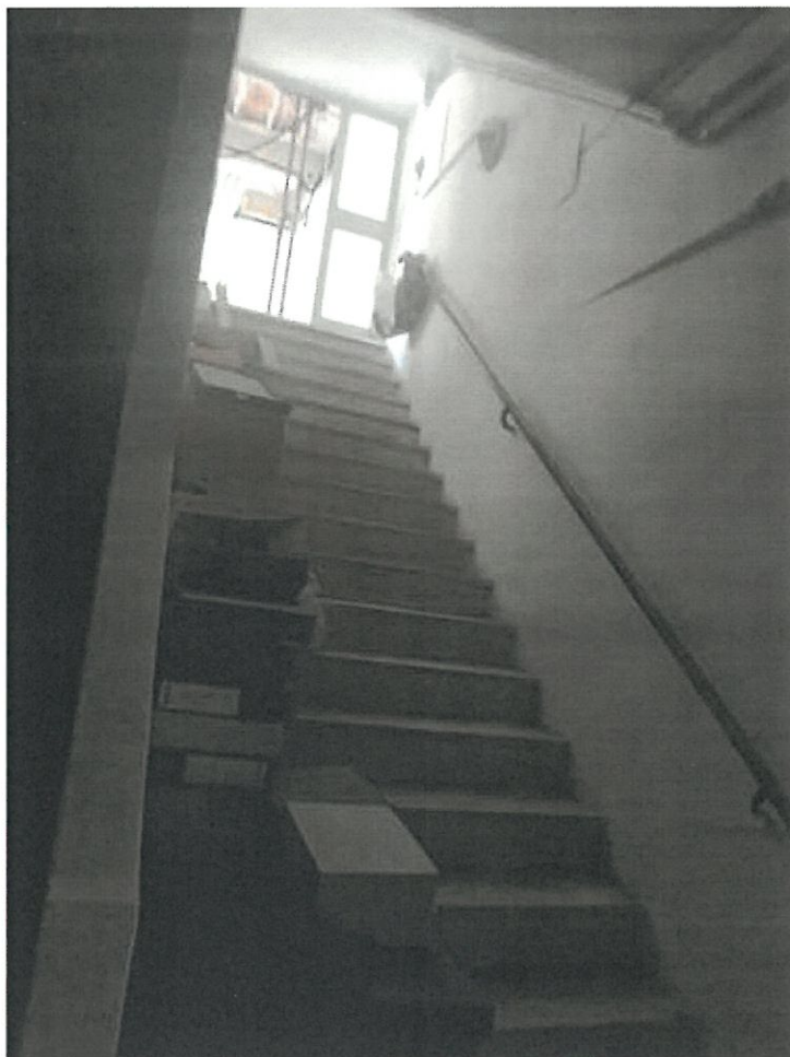
Foto deposito piano interrato
