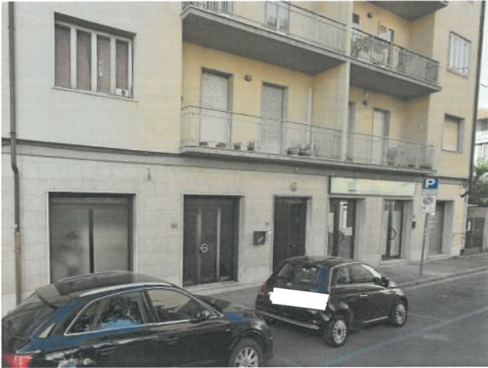
Foto fabbricato condominiale su via Arcangeli
