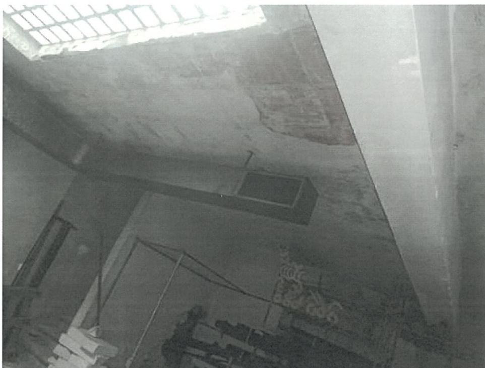
Foto deposito piano interrato
