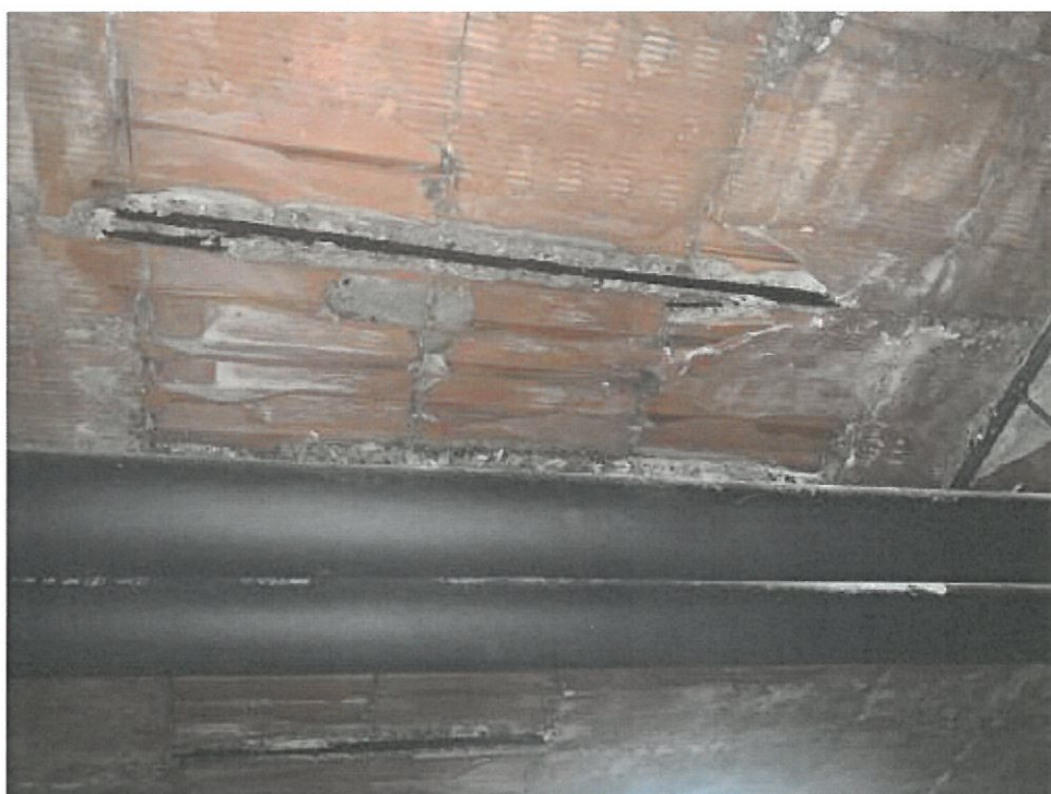
Foto deposito piano interrato
