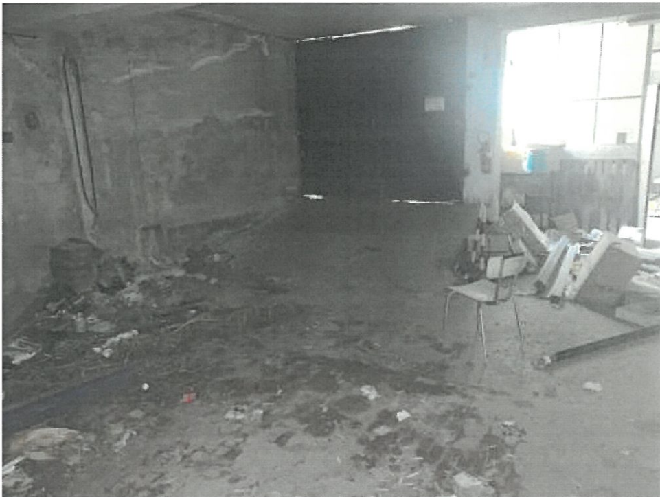
Foto deposito piano interrato
