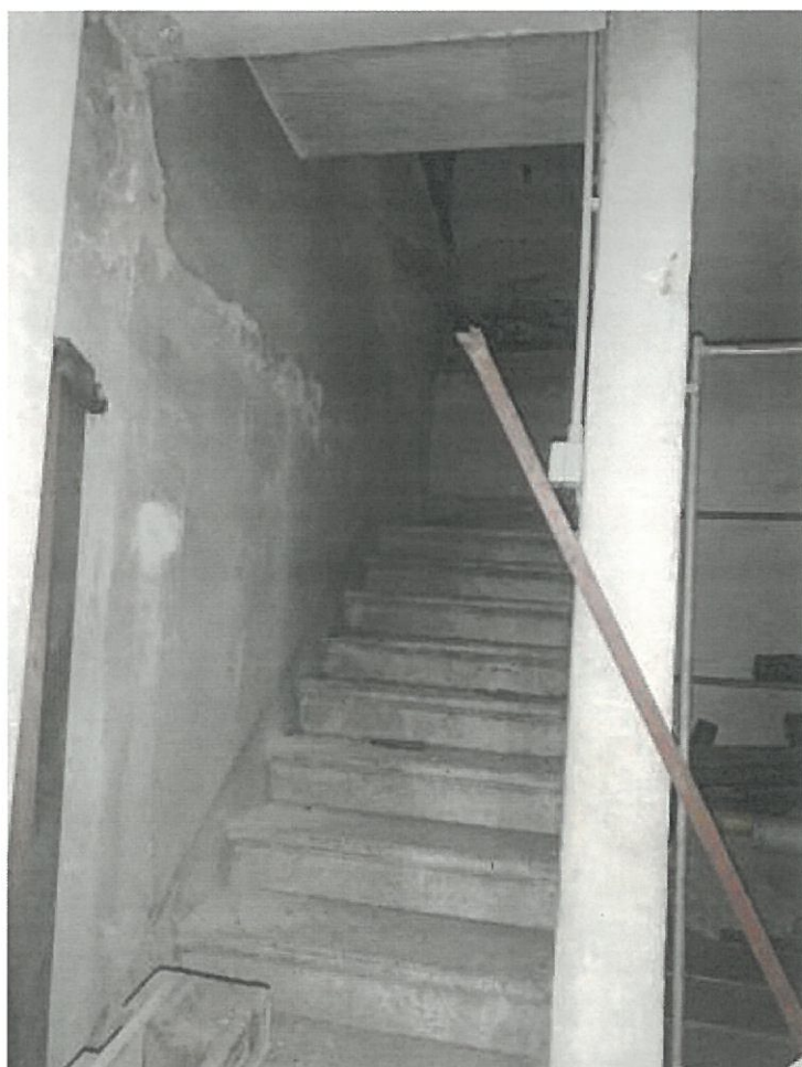
Foto deposito piano interrato
