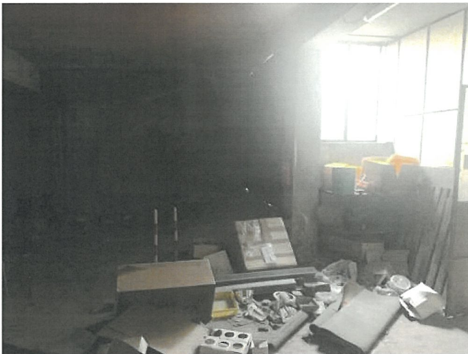
Foto deposito piano interrato
