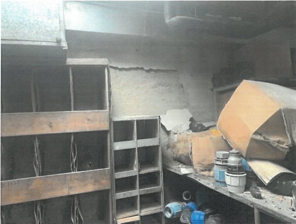
Foto deposito piano interrato
