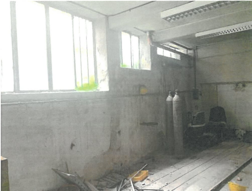
Foto deposito piano interrato
