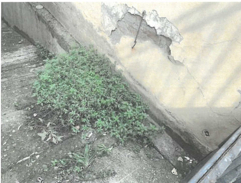
Foto rampa deposito piano interrato
