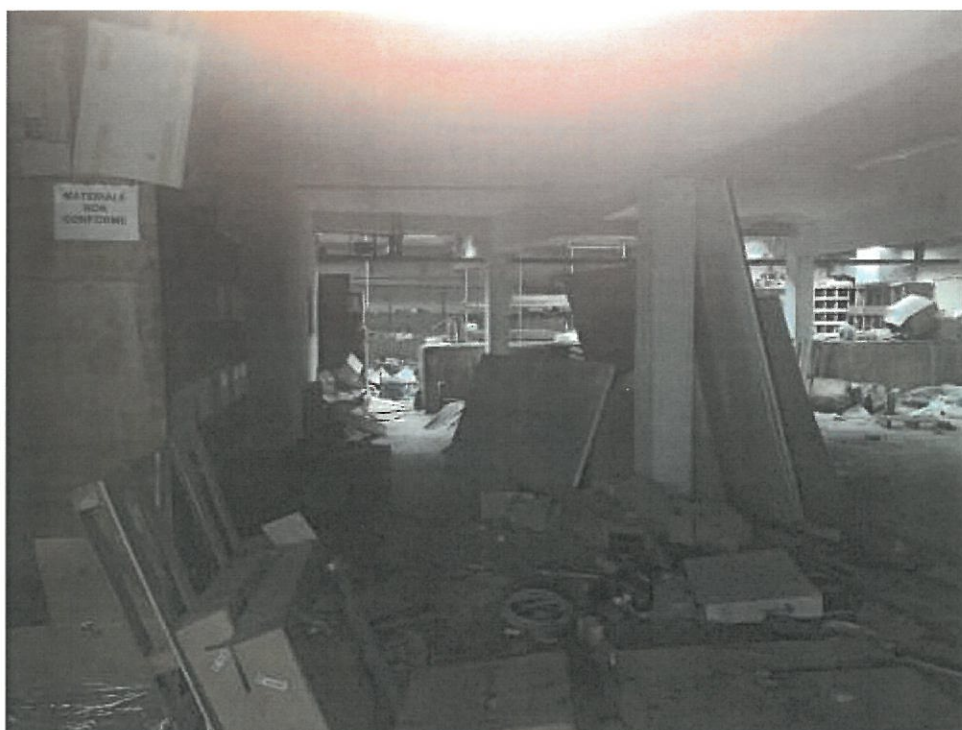
Foto deposito piano interrato
