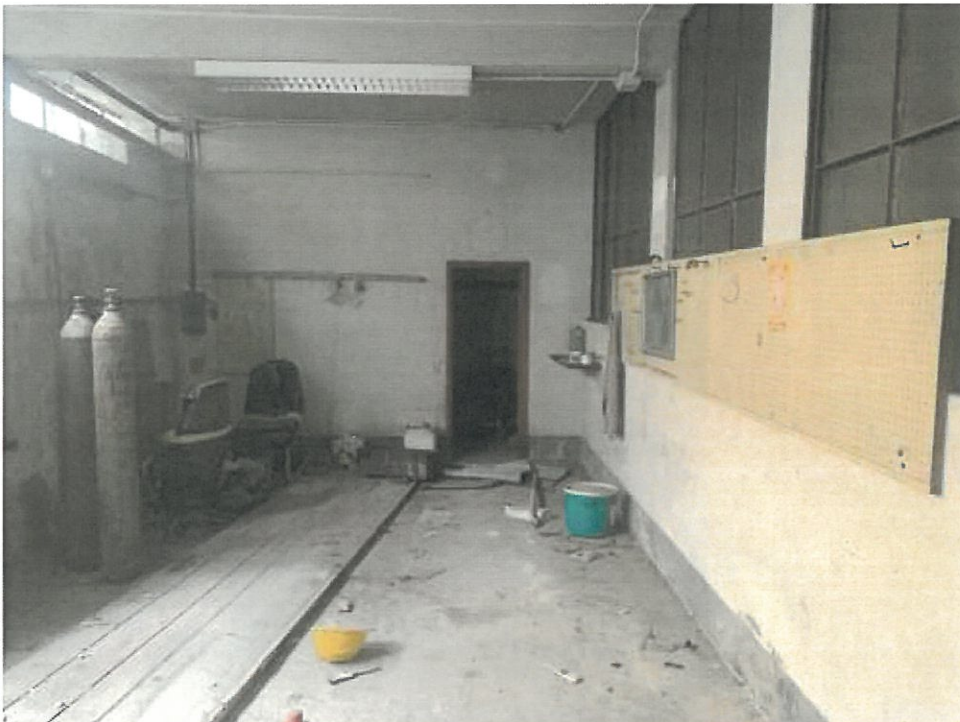
Foto deposito piano interrato
