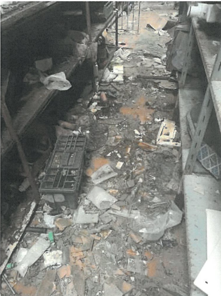
Foto deposito piano interrato
