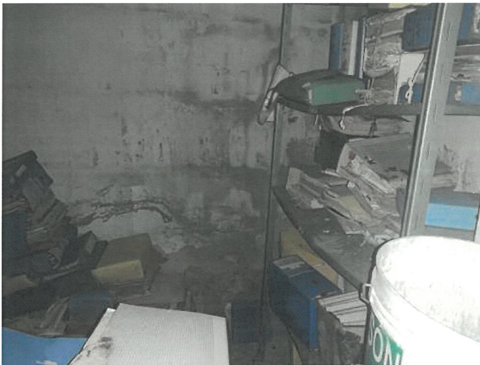
Foto deposito piano interrato
