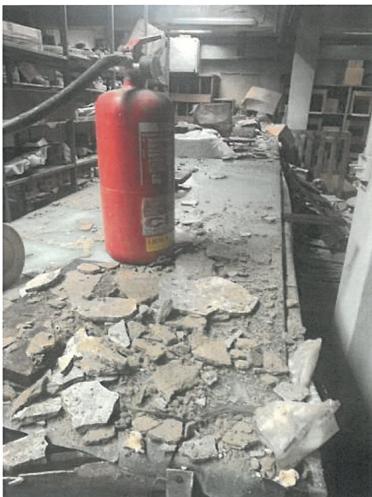
Foto deposito piano interrato
