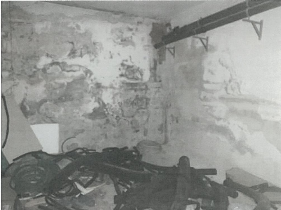
Foto deposito piano interrato
