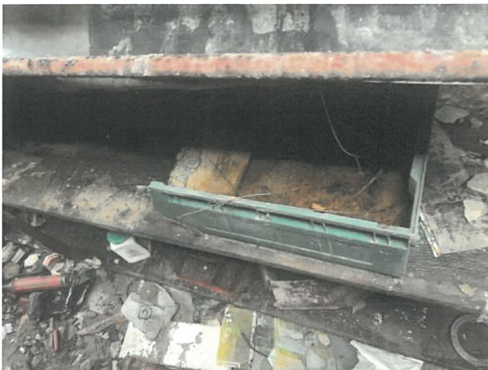
Foto deposito piano interrato
