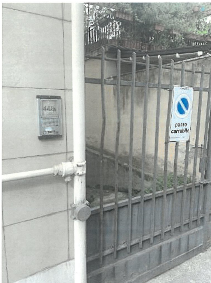
Foto rampa deposito piano interrato
