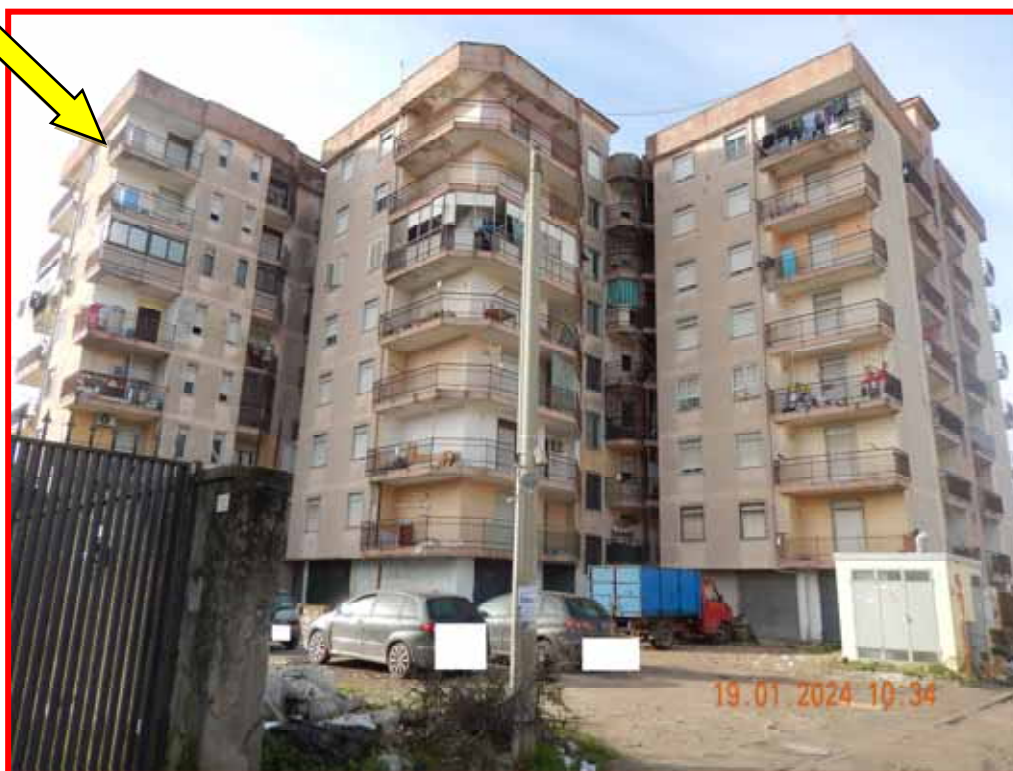
Fabbricato ubicato alla Via Bosco a Casacelle 25 – Giugliano in Campania (NA)
