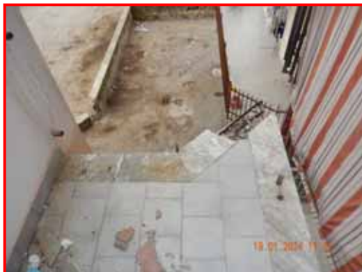
immagine 9 – balcone lato Sud
