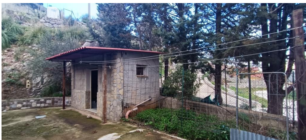
Foto n. 5 - Vista esterna del locale di sgombero di piano terra.
