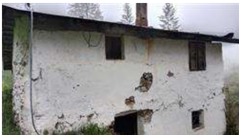
Vista esterna edificio
