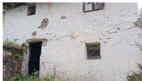
Vista esterna edificio
