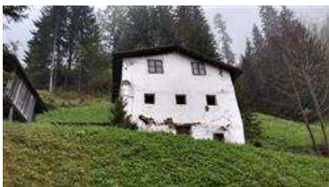
Vista esterna edificio
