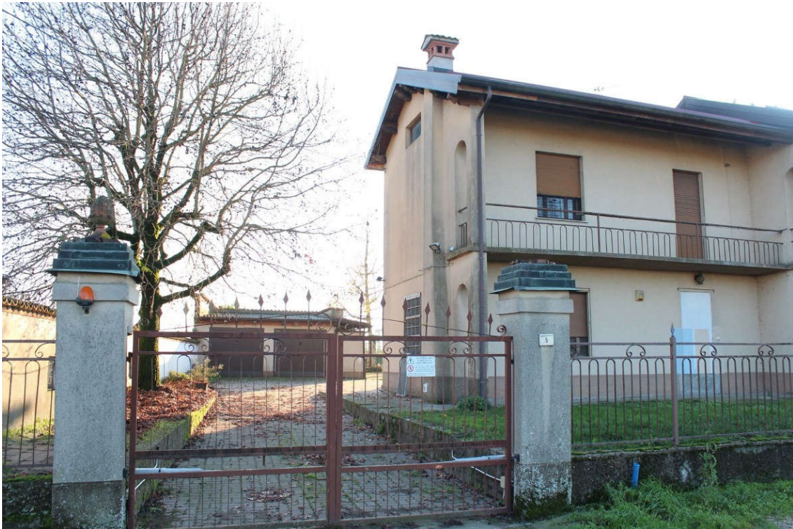
Prospetto est casa e porte fabbricato mapp 573
