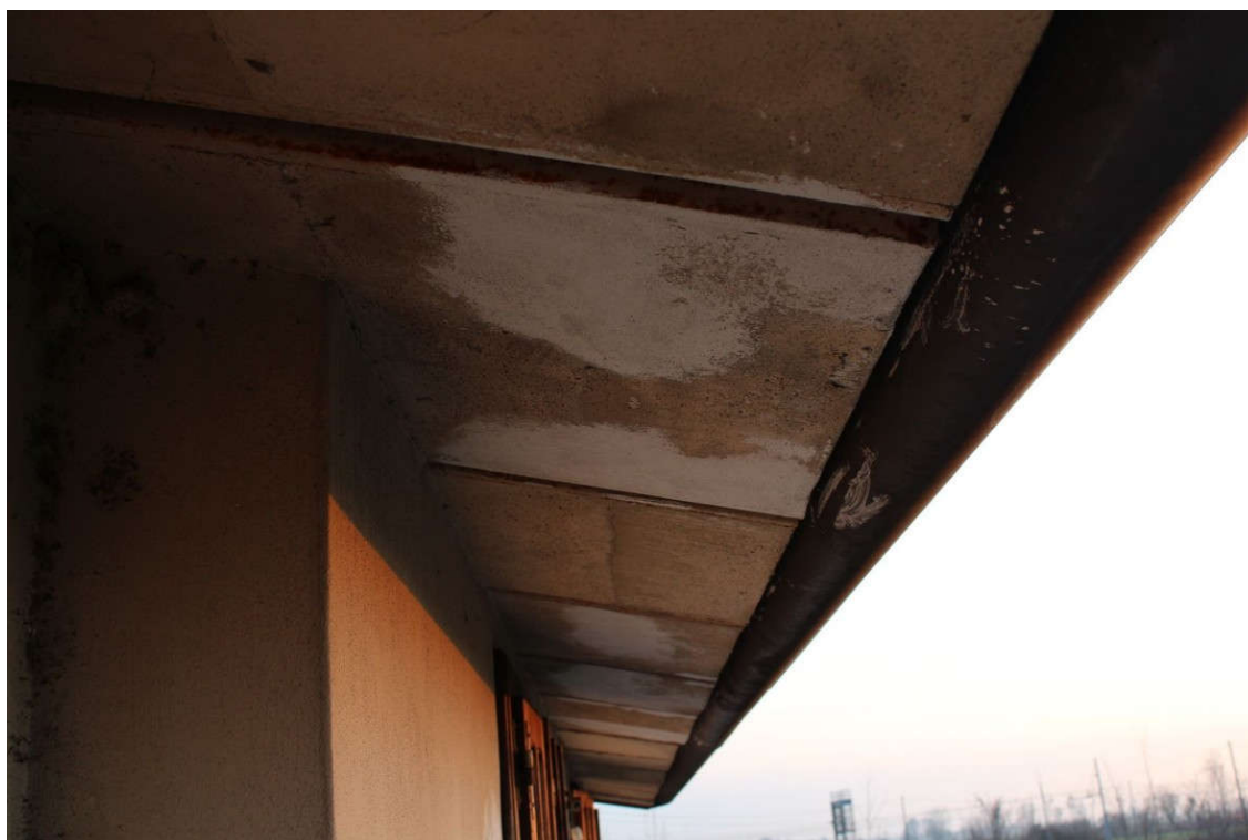
Particolare gronda zona lavanderia-bagno
