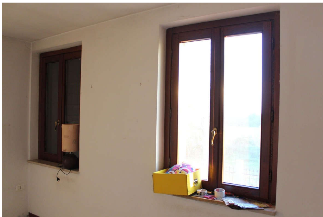
Finestre lato sud della soffitta
