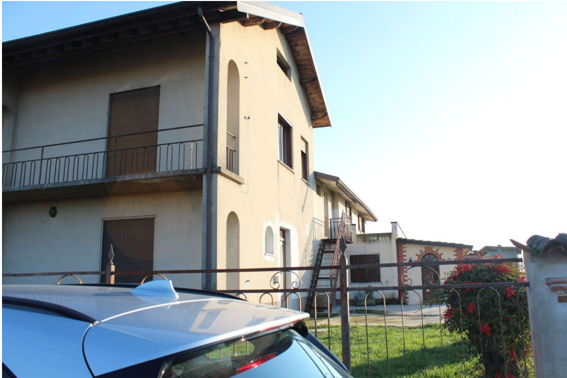
Prospetto ovest casa con ingresso locali magazzino
