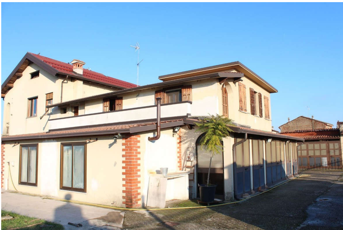
Parte posteriore dell'edificio ripresa dall'angolo sud-ovest
