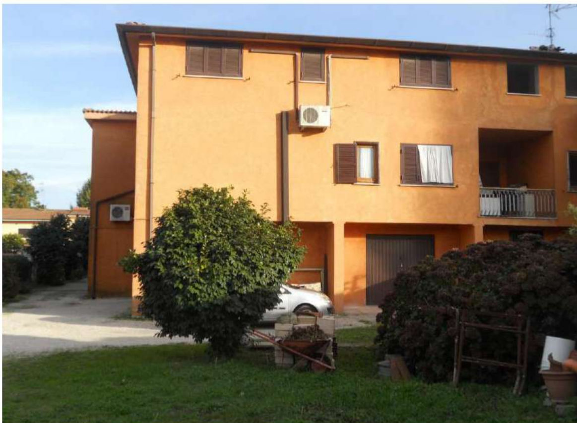
Foto n°7 - Prospetto ovest del fabbricato
