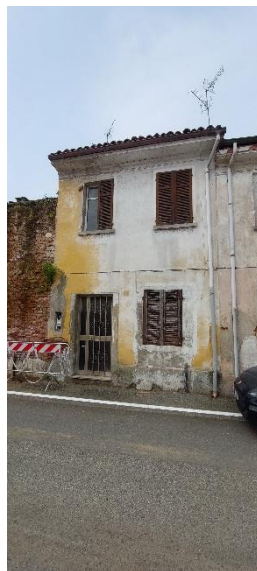
FOTO 2 – Facciata su Via San Giovanni n.17
