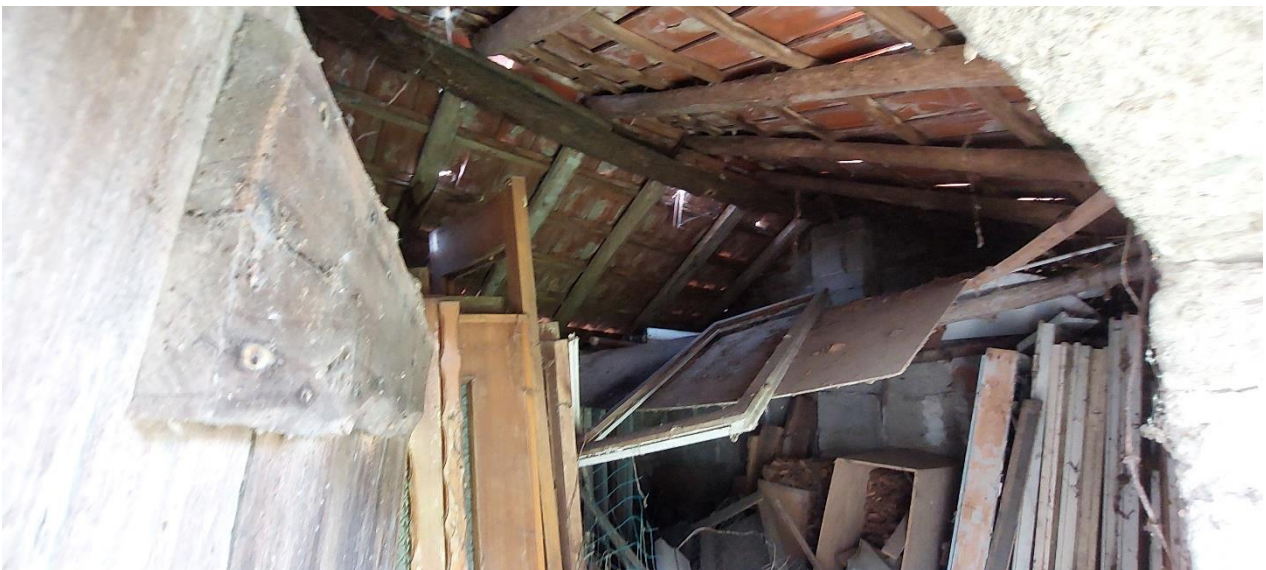
FOTO 27 – Interno locale di sgombero
