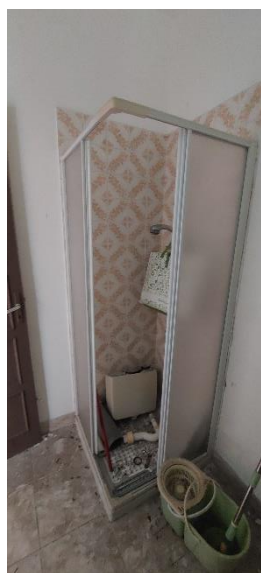
FOTO 8 – Bagno al piano terreno
