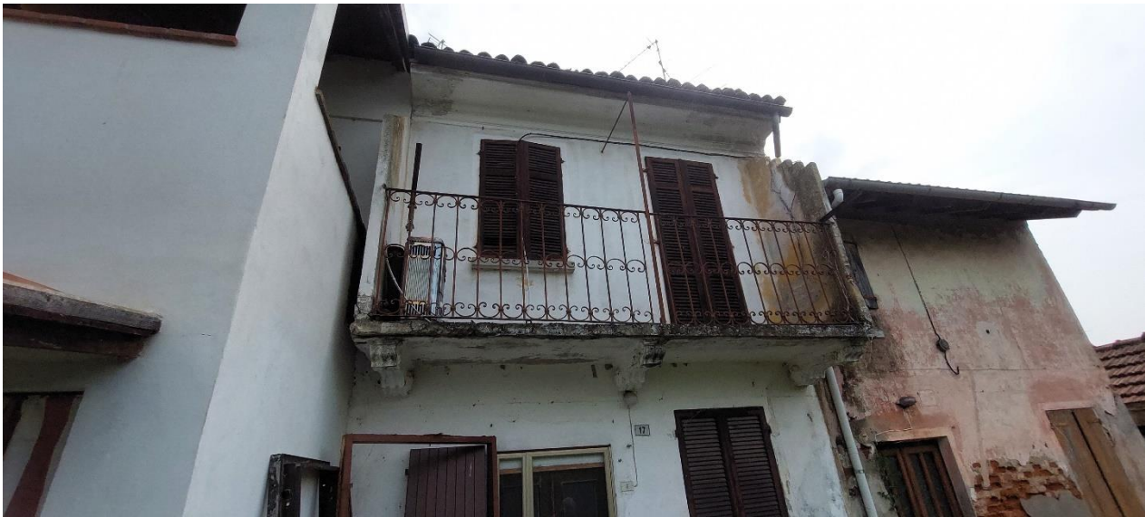
FOTO 4 – Facciata su cortile interno
