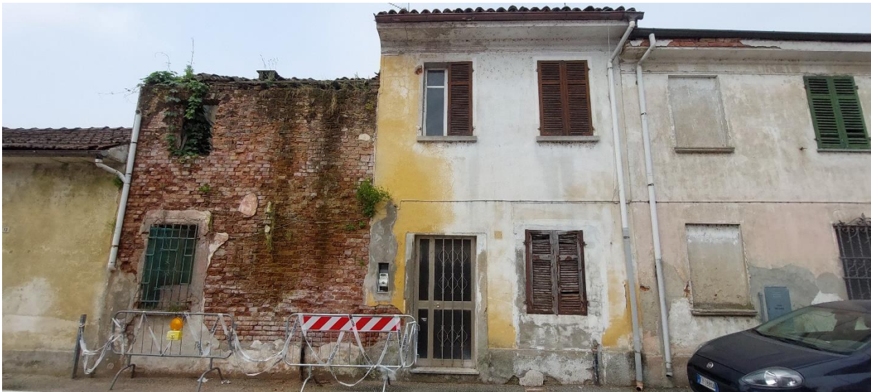
FOTO 1 – Facciata su Via San Giovanni n.17
