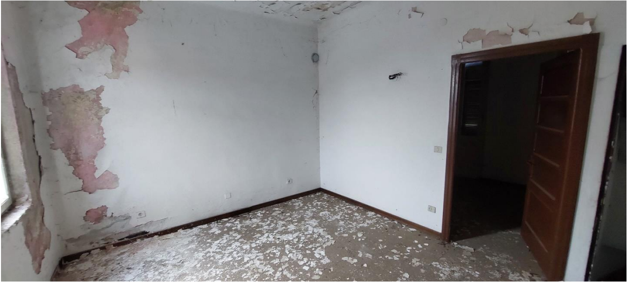
FOTO 16 – Camera al piano primo
