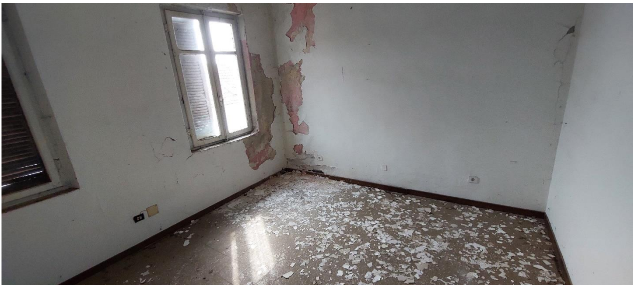
FOTO 15 – Camera al piano primo
