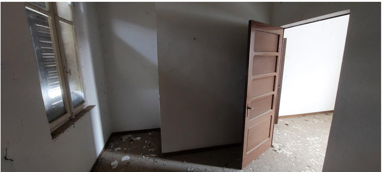
FOTO 18 – Camera al piano primo
