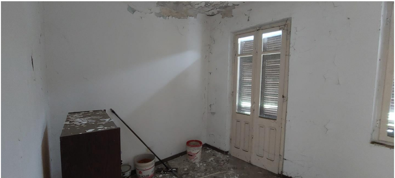
FOTO 17 – Camera al piano primo
