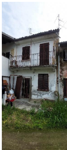
FOTO 6 – Facciata su cortile interno
