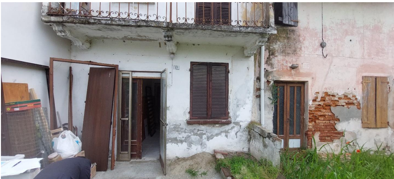
FOTO 5 – Facciata su cortile interno
