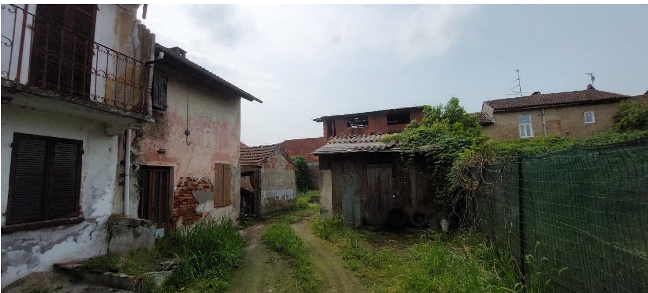
FOTO 3 – Facciata su cortile interno
