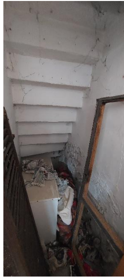
FOTO 11 – Ripostiglio sotto scala al piano terreno
