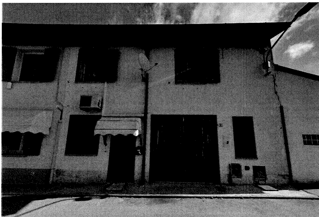
FOTOGRAFIA 2: vista della casa (fronte strada) su via Camillo Clerici 15 – lato sud.
