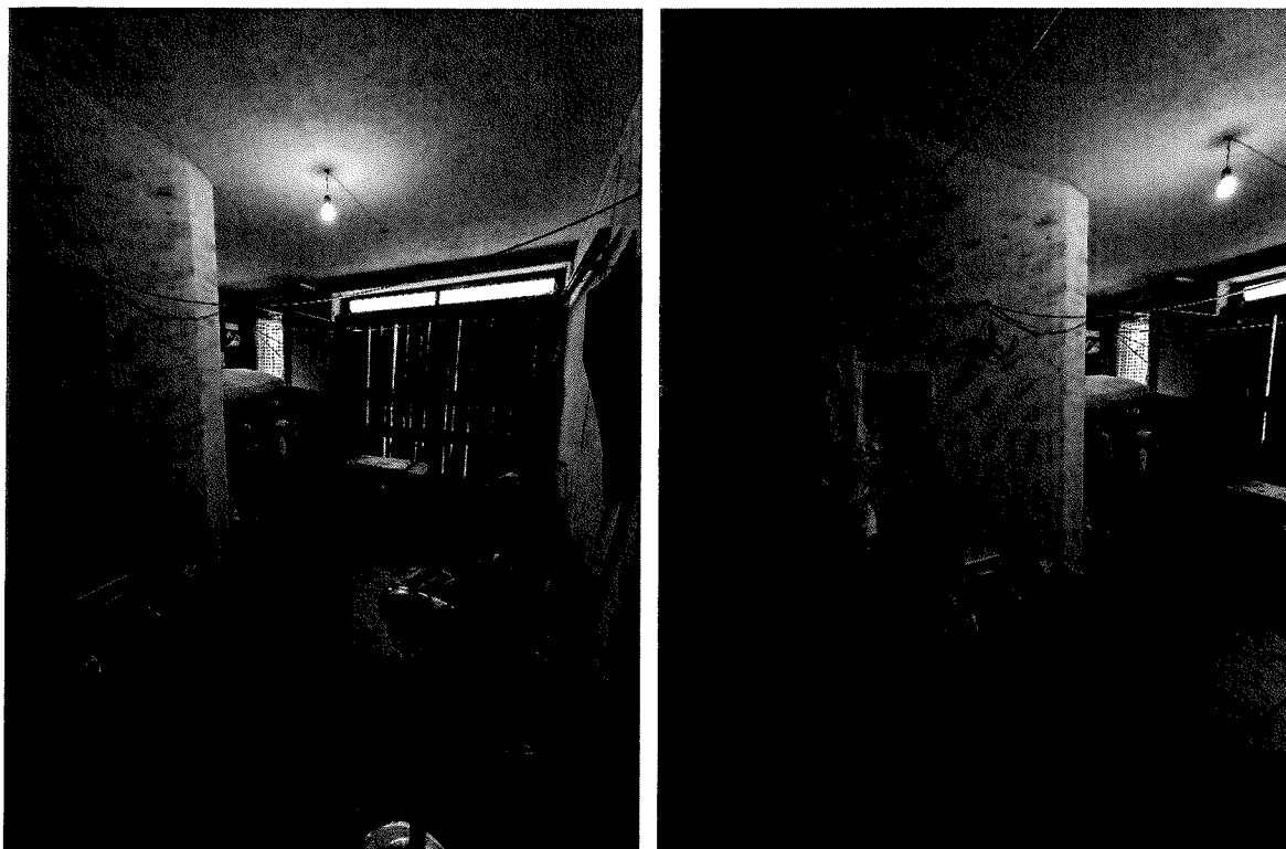
FOTOGRAFIA 24-25: Viste dell'autorimessa con accesso diretto dal piano terra e dalla strada.
