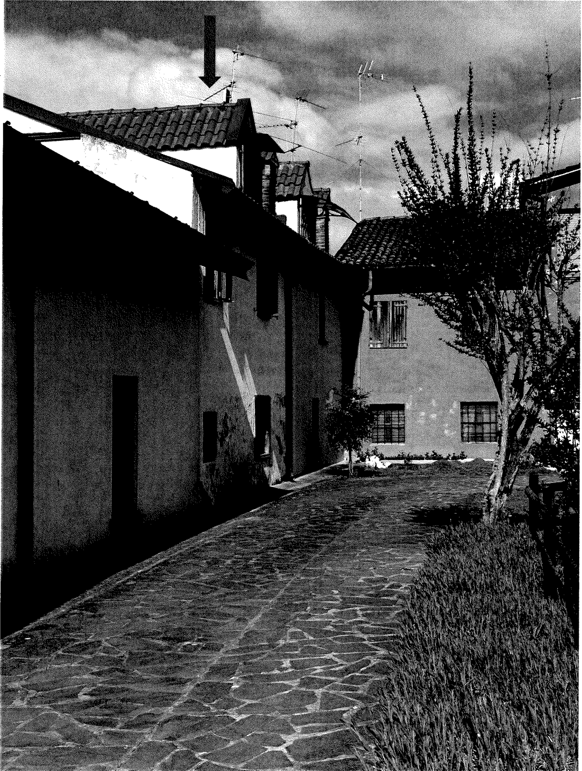
FOTOGRAFIA 3: vista del retro della casa da via Palestro – lato nord (area esterna NON di proprietà)
