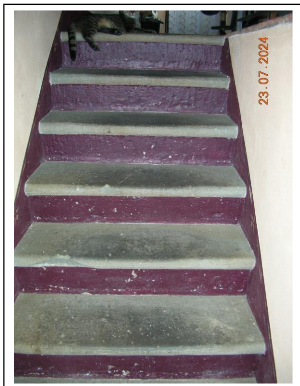
Scala di accesso alla sala
