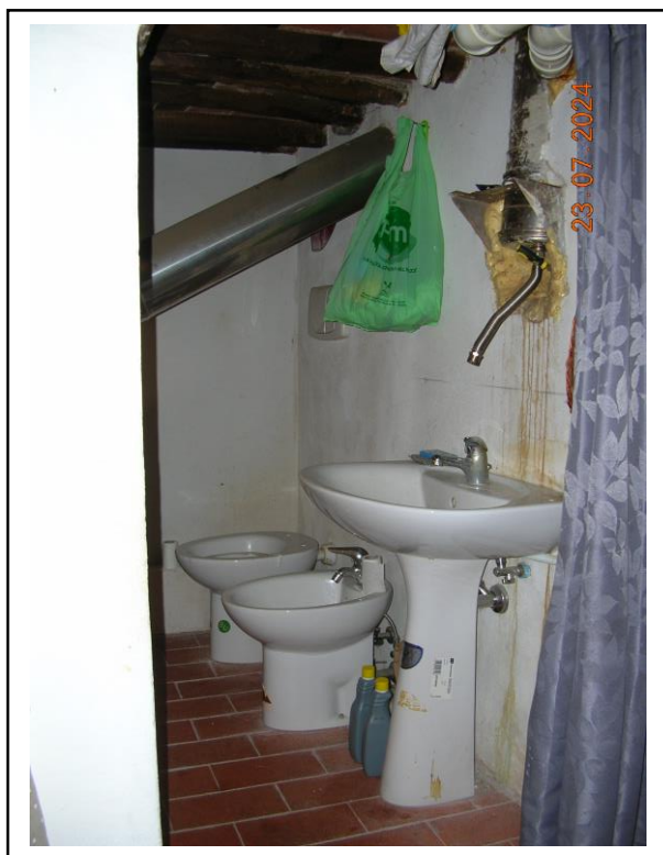
Servizio igienico e Lavanderia adiacenti alla cucina
