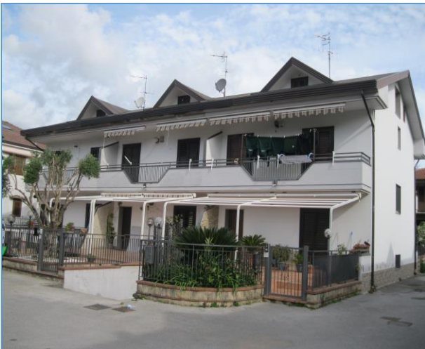
Edificio in cui ricade l'immobile pignorato
