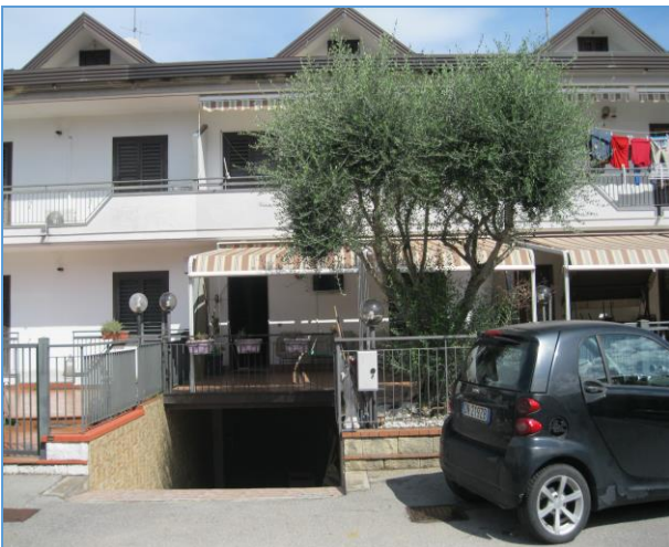
Prospetto principale dell'immobile pignorato
