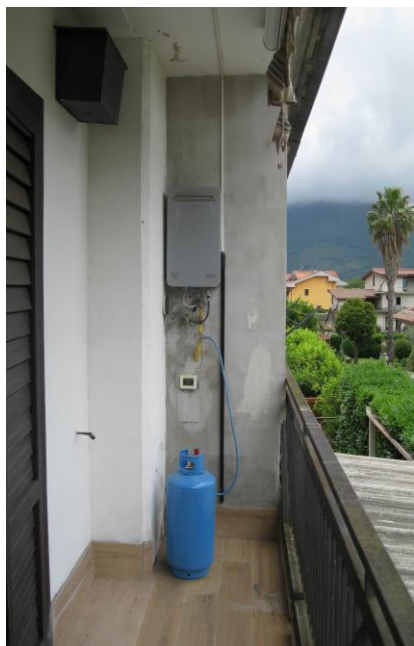
Piano Primo: Balcone lato nord
