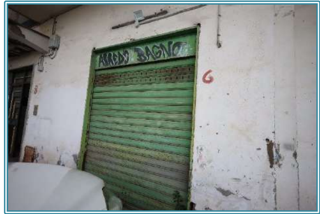
Figura 25 Accesso principale al LOTTO 3
