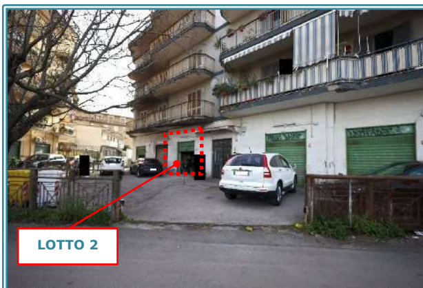
Figura 16 Accesso corte comune (sub. 1)
