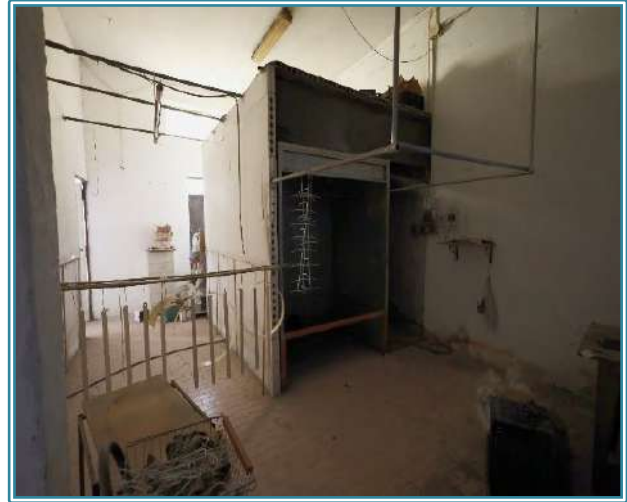
Figura 32 Vista dell'interno del box2
