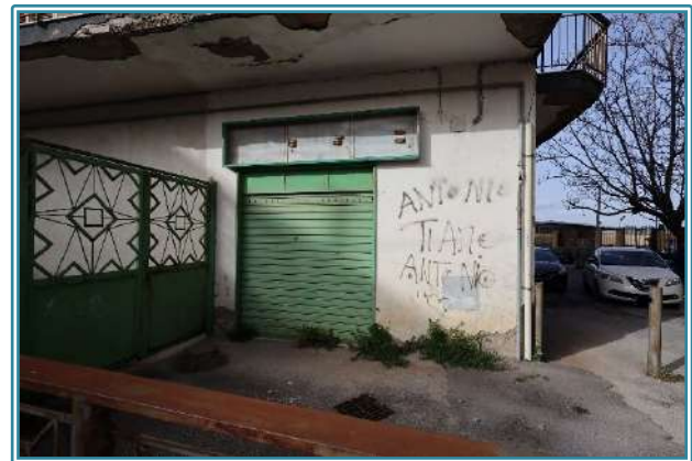
Figura 9 Accesso sul prospetto sud
