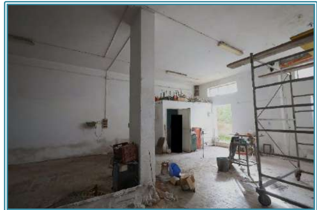
Figura 27 Vista dell'interno del box
