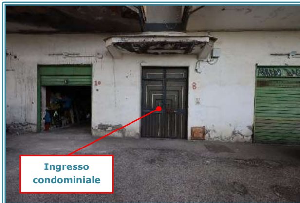
Figura 35 Ingresso condominiale dalla corte comune (sub. 1)
