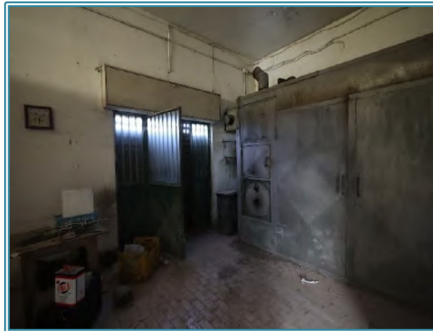
Figura 33 Vista dell'interno del box2
