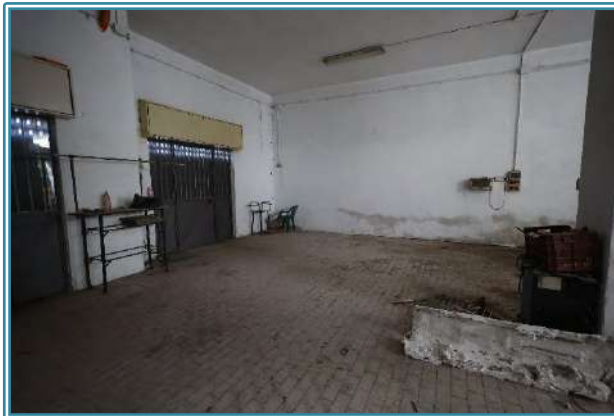
Figura 26 Vista Box LOTTO 3 fuso con LOTTO 4
