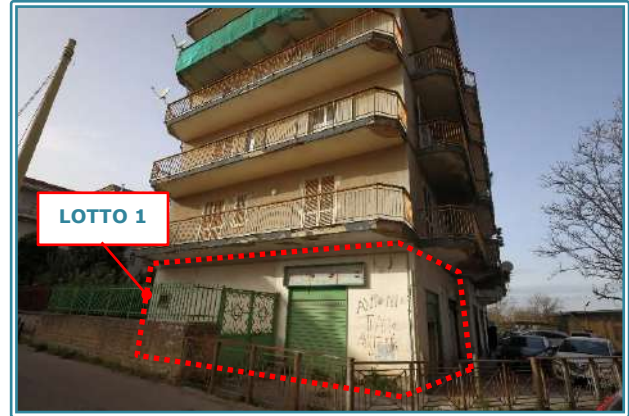
Figura 7 Vista fabbricato da Traversa 1ª Roma Verso Scampia
