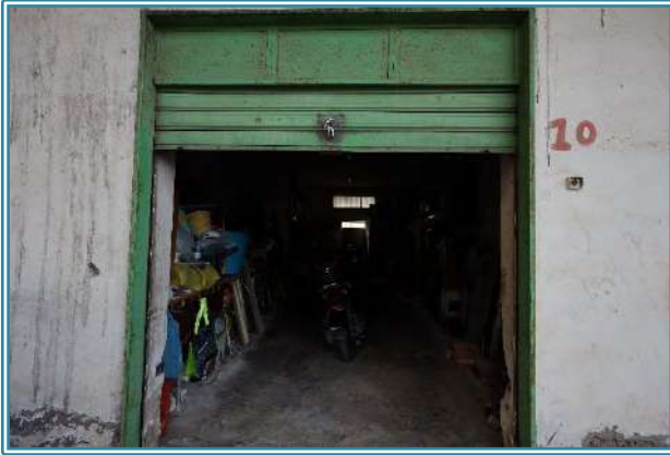
Figura 18 Accesso principale al LOTTO 2
