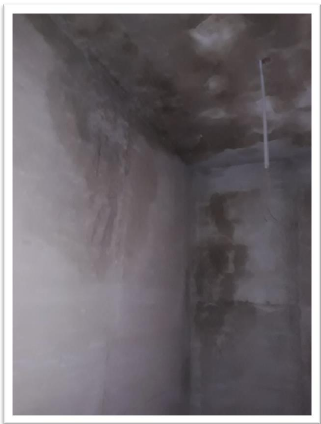
Foto 1: Tracce di acqua sul solaio di copertura e lungo la parte divisoria ed esterna.
