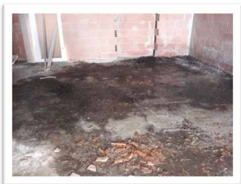
Foto 3: Macchia scura sul piano di calpestio in fondo al vano che denuncia la presenza di acqua.
