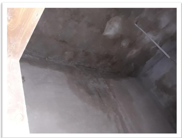
Foto 1: Tracce di acqua sul solaio di copertura e lungo la parte divisoria ed esterna.
