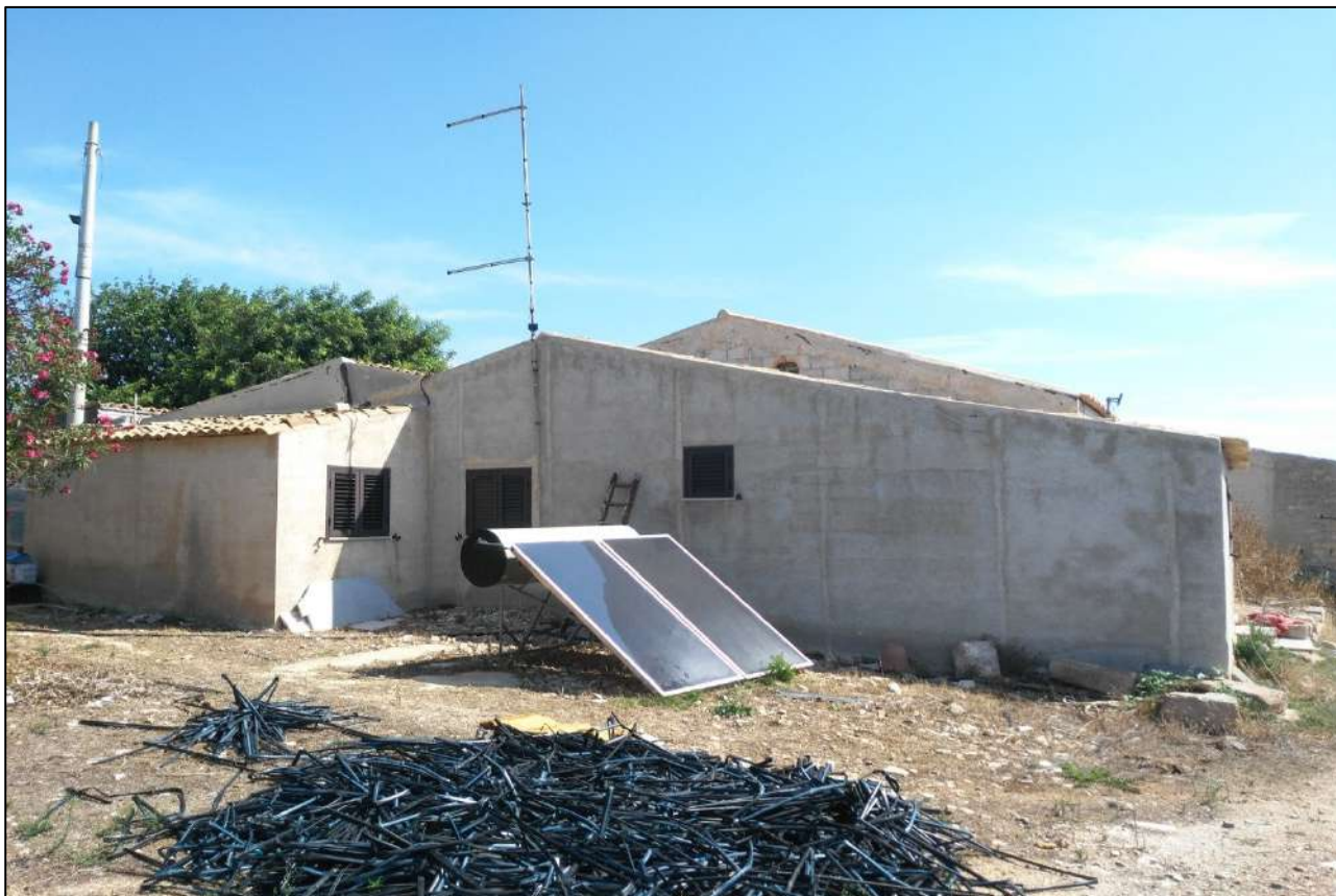
Foto 17 Vista panoramica esterna immobile foglio 35 p.Ila 1195 sub 4
