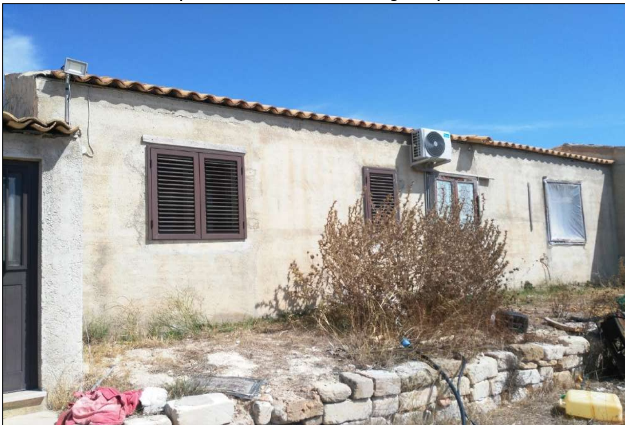
Foto 18 Vista panoramica esterna immobile foglio 35 p.Ila 1195 sub 3 e 4
