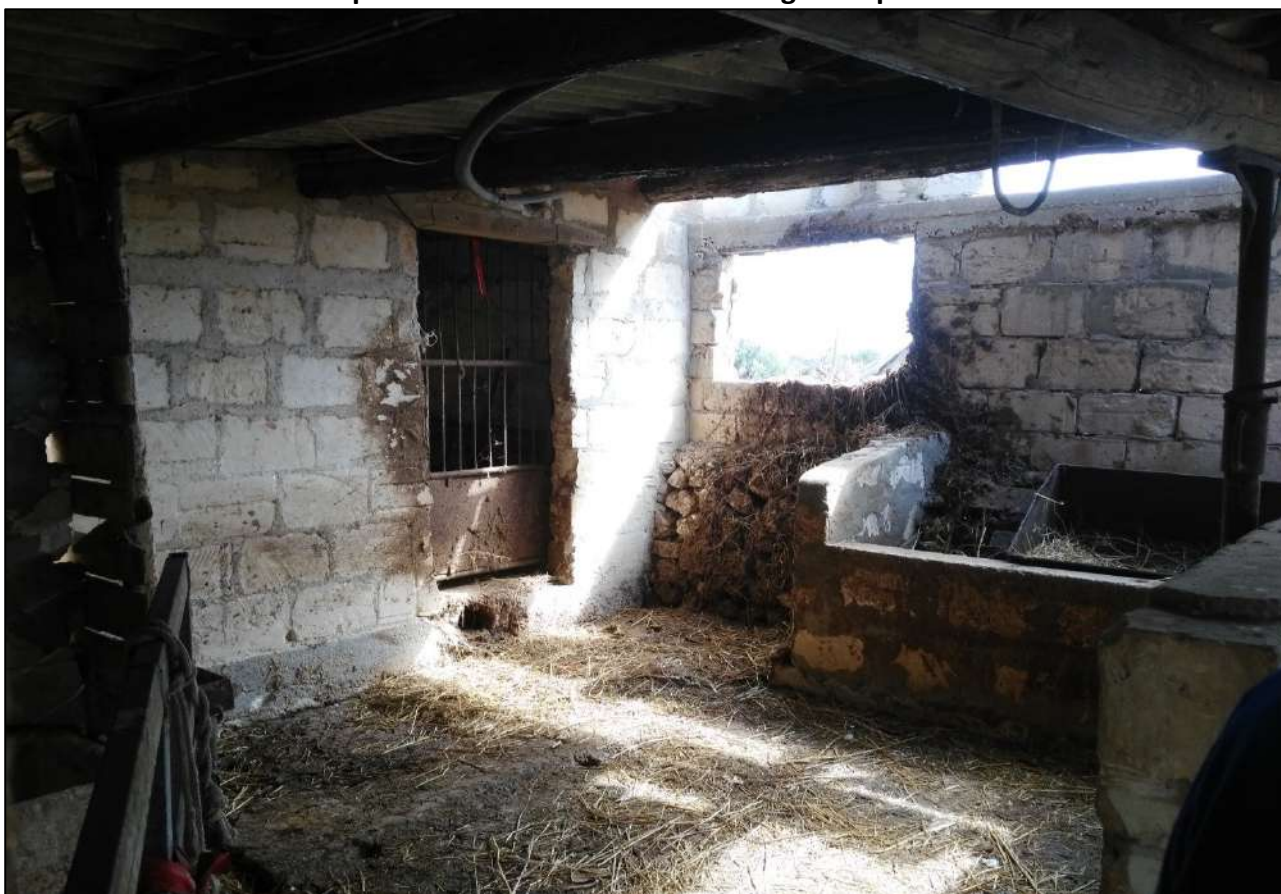
Foto 42 - Vista panoramica interna immobile foglio 35 p.la 1492 sub 1-2-3
