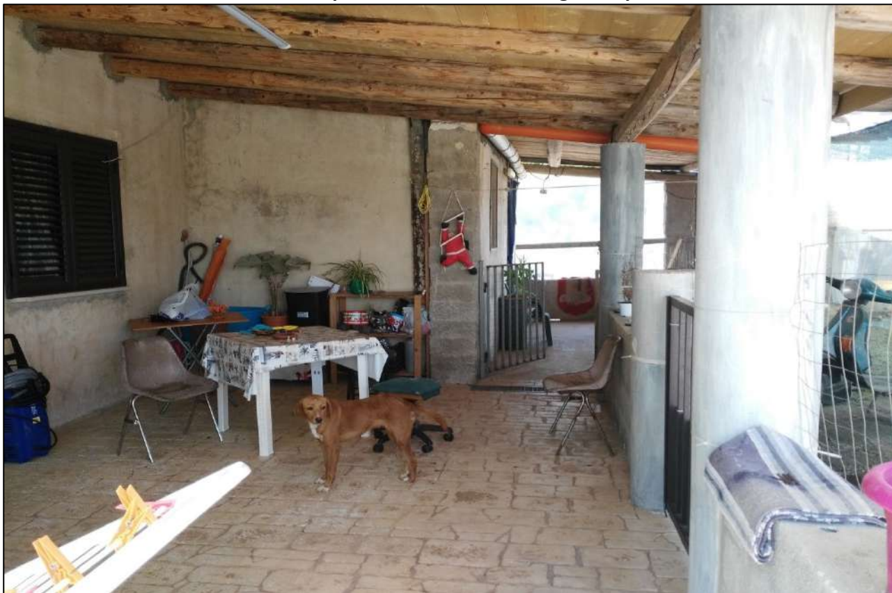
Foto 16 - Vista panoramica esterna immobile foglio 35 p.Ila 1195 sub 3 e 4
