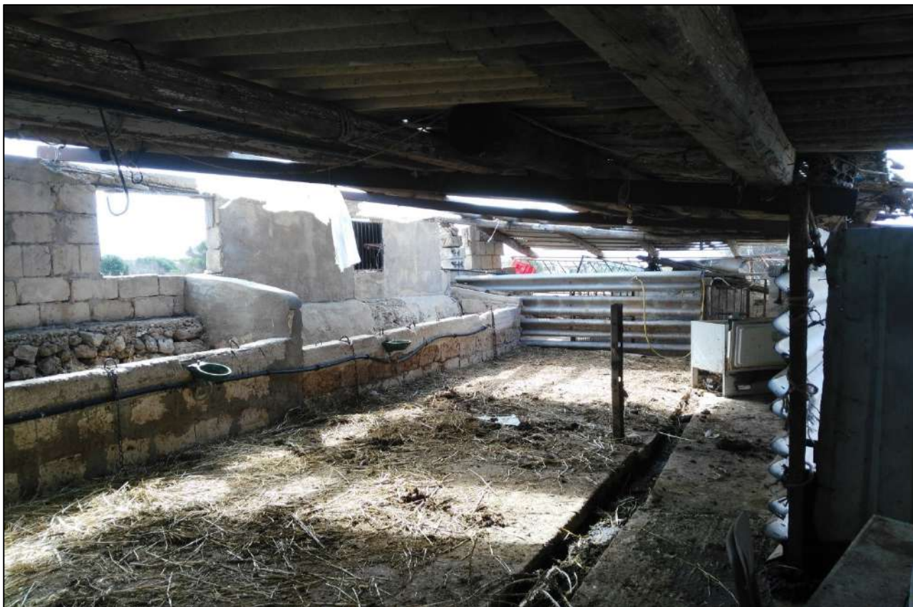
Foto 41 - Vista panoramica interna immobile foglio 35 p.la 1492 sub 1-2-3
