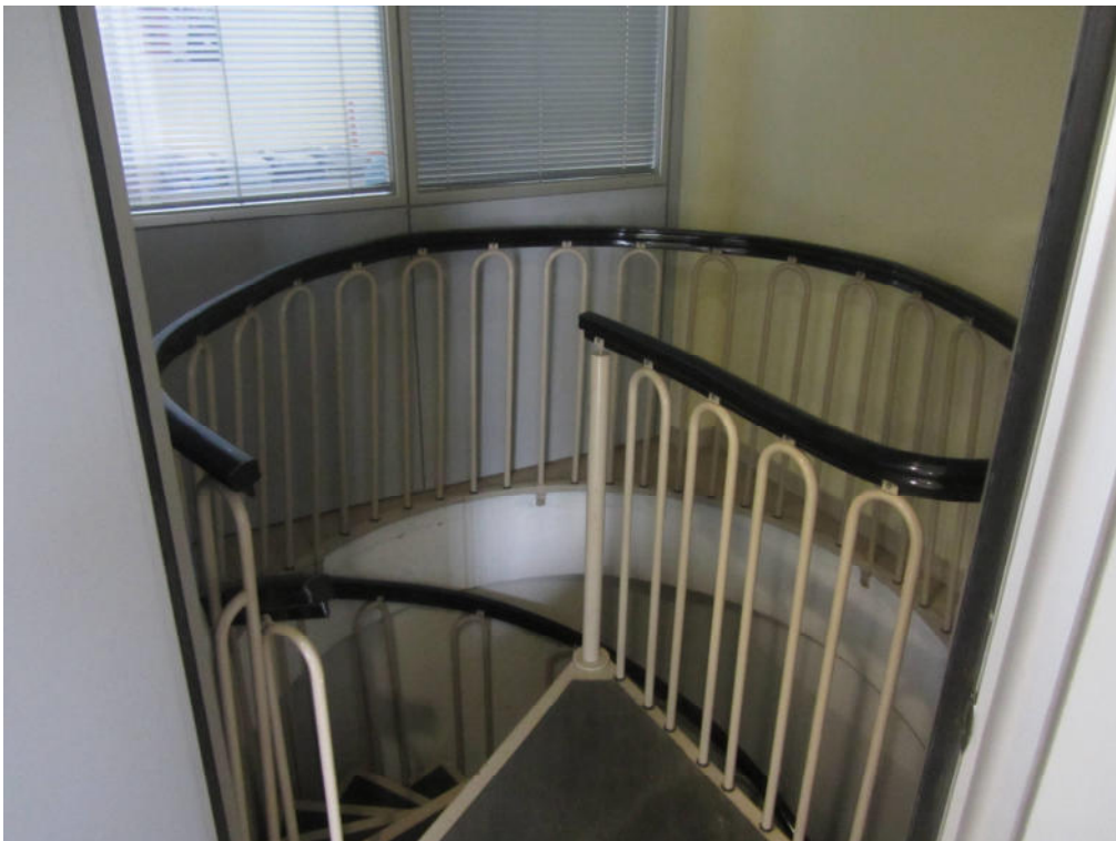
Foto n. 06 – vista della scala a chiocciola di collegamento tra piano terra e piano interrato
