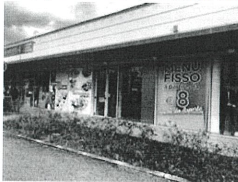
foto 8 - vista ingresso sub 48
