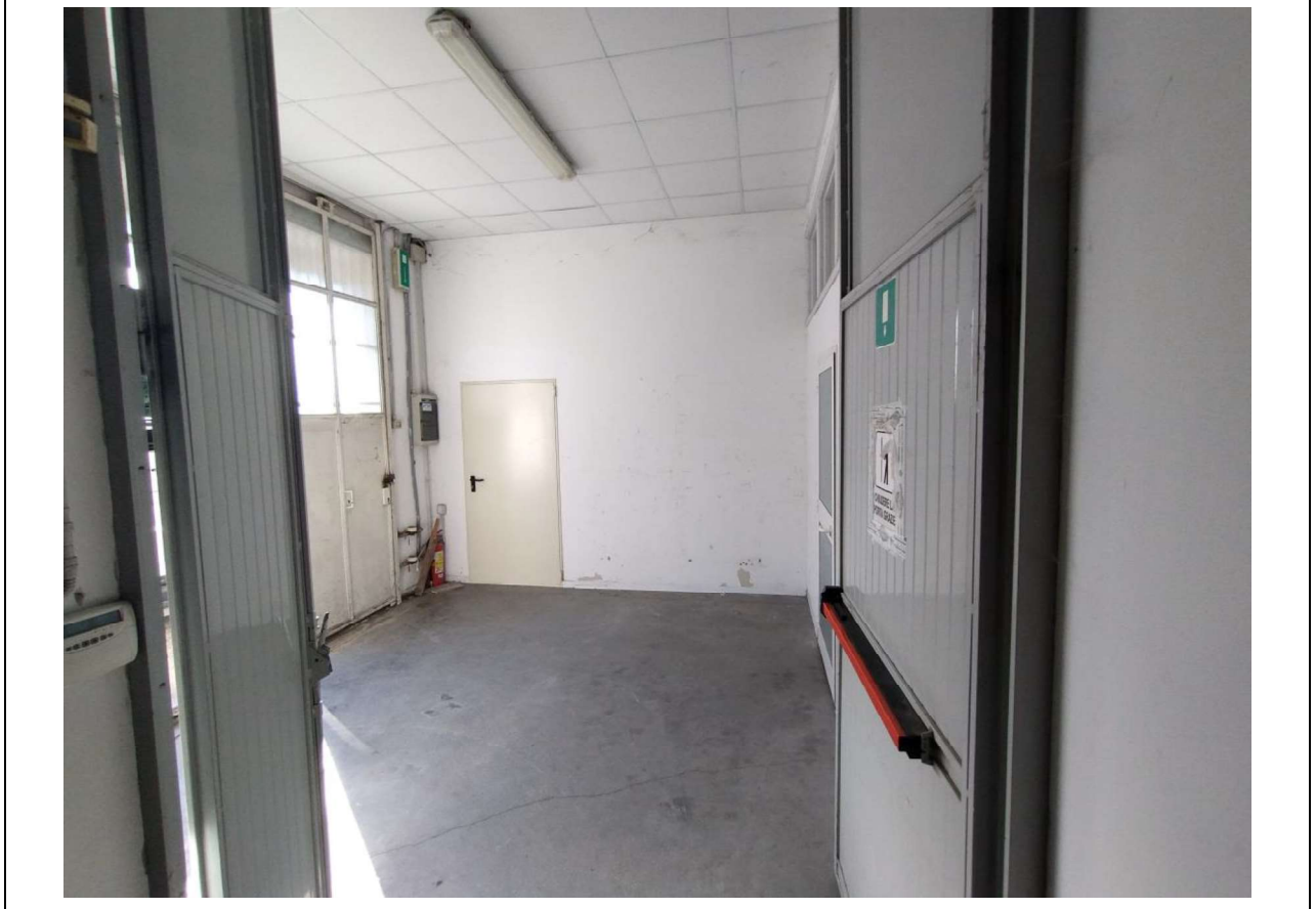
Foto n° 37 - Sub 27 “B.C.N.C.” ai Sub 25 e 26 - Ingresso
