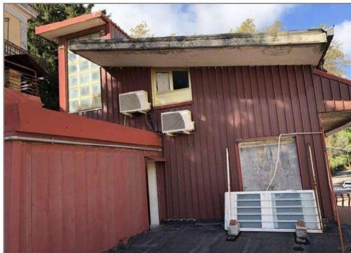
**Foto nn.12-13-14-15-16: La diversa esecuzione della copertura con una quota di impostazione totalmente diversa da quella autorizzata.**
